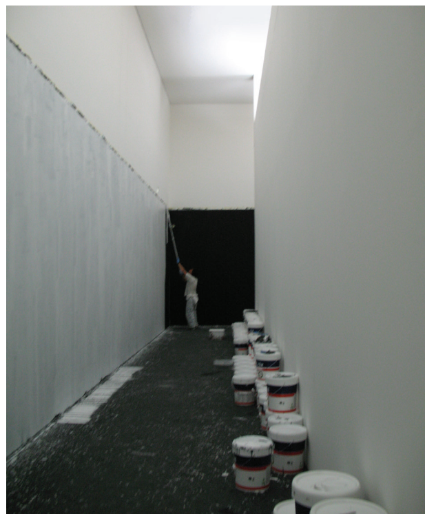
Il. 8. Transformacja: Museum as Performance, Serralves Museum of Contemporary Art, Porto, arch. Alvaro Siza (fot. A. Kwiatkowska)
