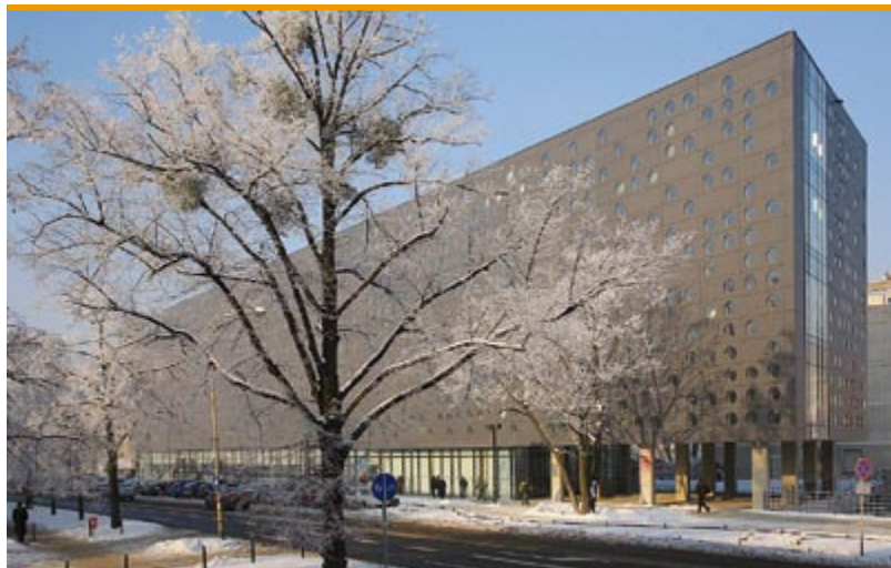
Usytuowanie gmachu Zintegrowanego Centrum Studenckiego wzdłuż Wybrzeża Stanisława Wyspiańskiego stanowi kontynuację linii zabudowy wyznaczonej przez Gmach Główny uczelni, styczeń 2009 roku
