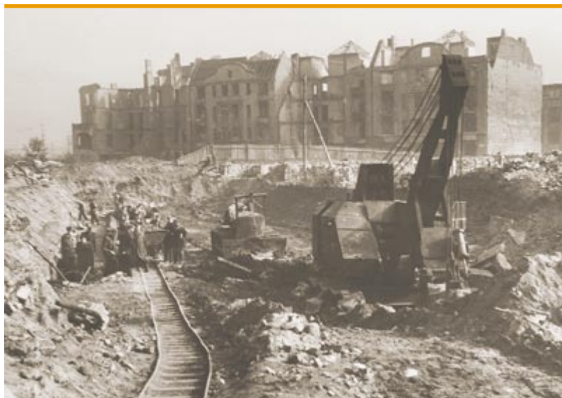
Prace przy niwelacji terenu pod budowę obiektów Politechniki Wrocławskiej przy placu Grunwaldzkim. W tle kikuty domów przy ulicy Marii Skłodowskiej-Curie, 1950 rok
