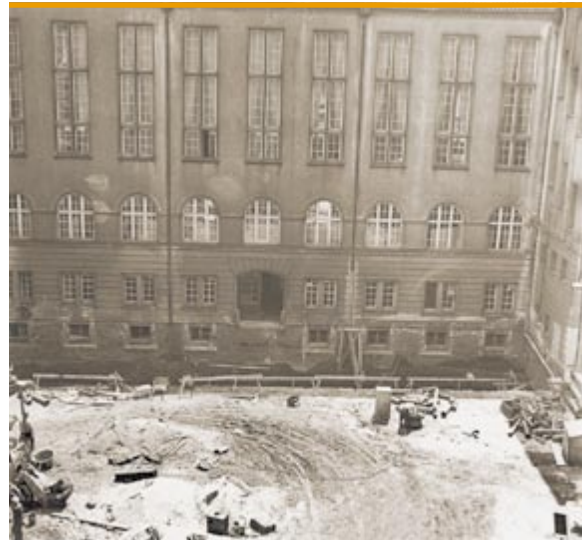
Południowa pierzeja dziedzińca wewnętrznego Gmachu Głównego Politechniki Wrocławskiej przed zasłonięciem przez wzniesione w latach 1971-1972 dwukondygnacyjne skrzydło „A”, zima 1971 roku
