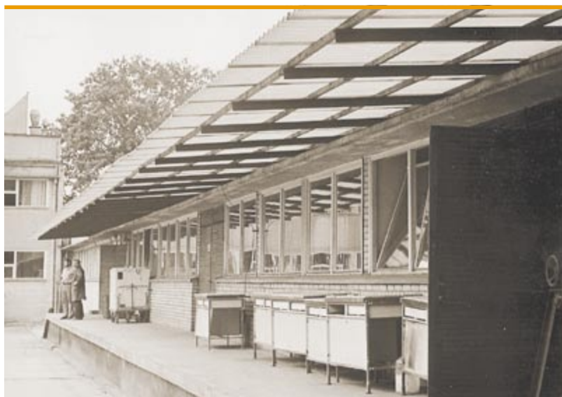
Jednym z pierwszych obiektów zrealizowanej w 1971 roku głównej zabudowy ośrodka przy ulicy Gdańskiej był oddany do użytku w 1969 roku budynek Instytutu Chemii i Technologii Nafty i Węgla (F-2)
