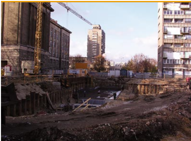
Wstępny etap budowy gmachu Centrum Naukowo-Badawczego Wydziału Elektrycznego (D-20); po lewej budynek Wydziału Elektrycznego (D-1), po prawej Dom Naukowca, 5 listopada 2003 roku
