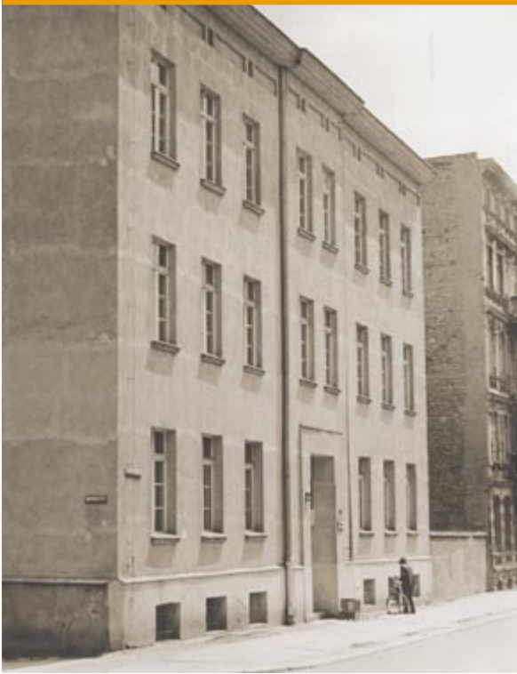
Dawny budynek szkolny przy Wybrzeżu Stanisława Wyspiańskiego został przejęty przez Politechnikę w 1968 roku. Stał się siedzibą Studium Nauki Języków Obcych Politechniki Wrocławskiej
