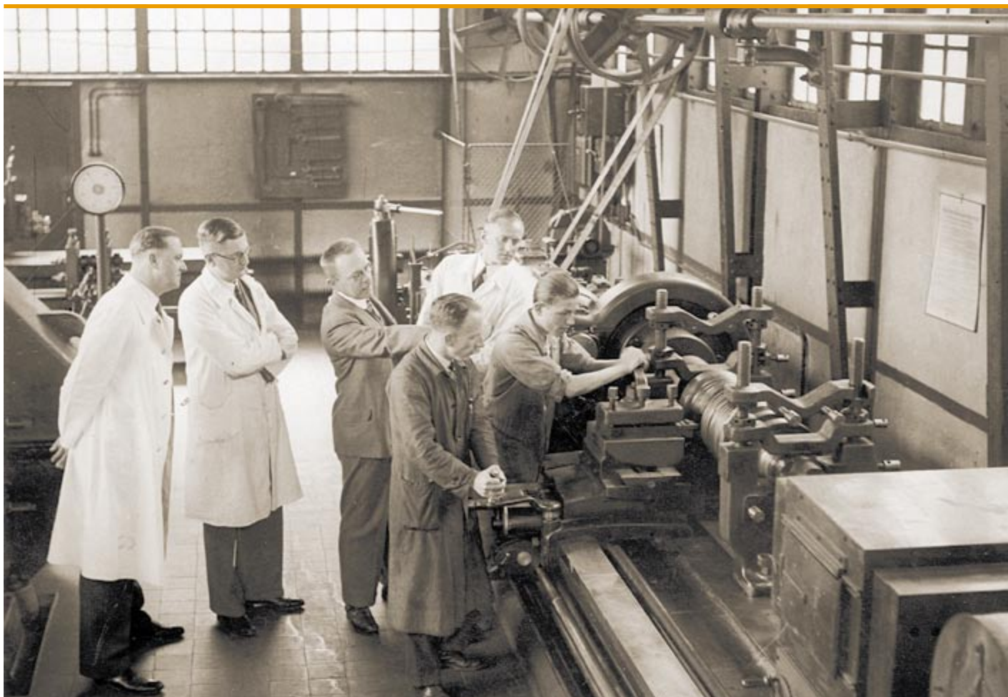
Wnętrze walcowni doświadczalnej Wyższej Szkoły Technicznej (dziś budynek B-2), około 1943 roku
