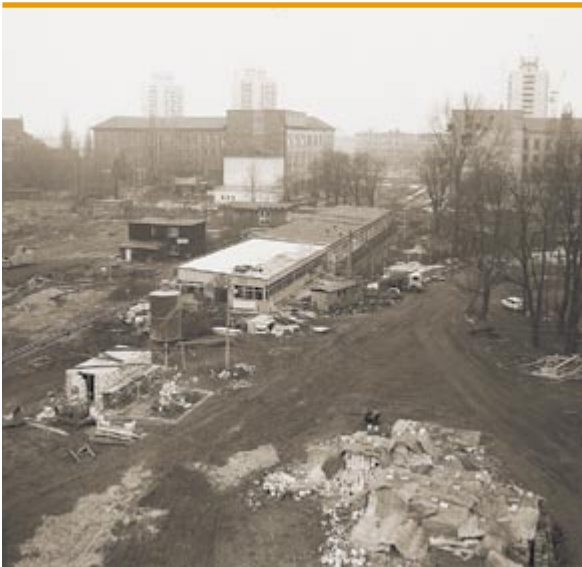
Modernizacja budynku D-5 sfotografowana z najwyższej kondygnacji budowanego właśnie C-6. W głębi panorama okolic placu Grunwaldzkiego, wiosna 1972 roku
