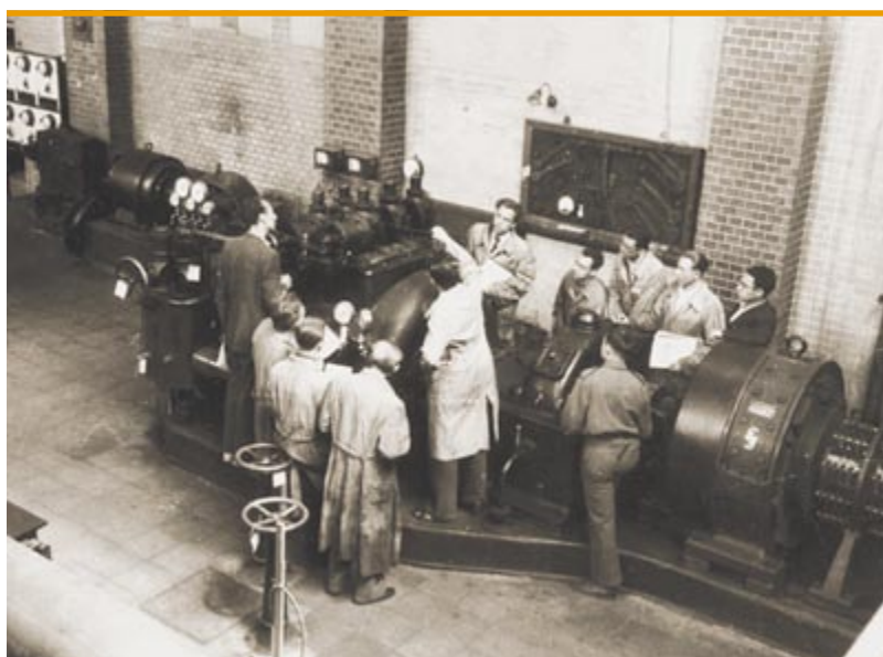
Od roku akademickiego 1954/1955 w hali maszyn budynku A-4 odbywały się zajęcia dla studentów Wydziału Mechaniczno-Energetycznego, 1. połowa lat 50.
