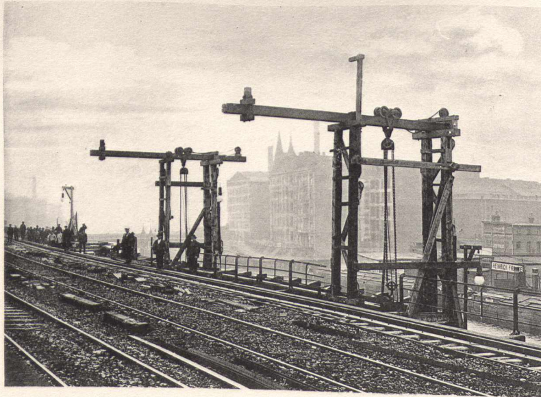
Abb. 1. Krane zum Abladen und Einsetzen der Hauptträger.
