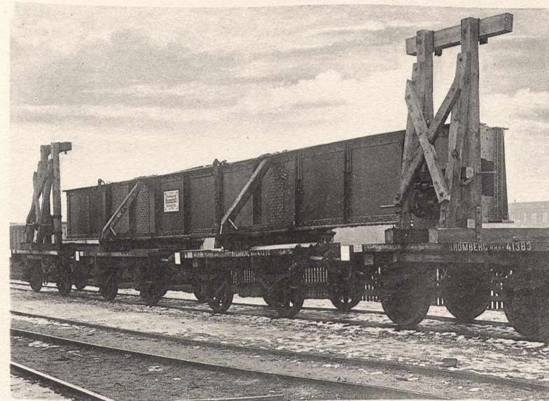
Abb. 2. Zum Einbau bereitstehender Hauptträger.
