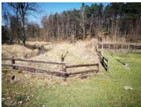
5. Pozostałości fundamentów wraz z zarysem papierni. Po lewej widoczny kawałek ściany, po prawej dawne koryto rzeczki (fot. Jerzy Smalec)
