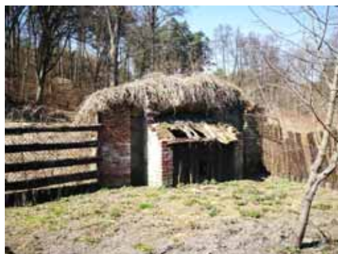
4. Pozostałość po ścianie przyziemia papierni z widocznym sklepieniem zejścia do podziemi (fot. Jerzy Smalec)
