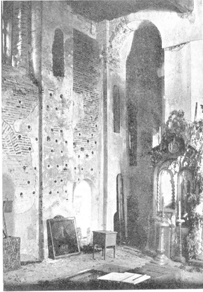
Rys. 36. Kołozą. Wnętrze cerkwi przy północnej absydzie.
