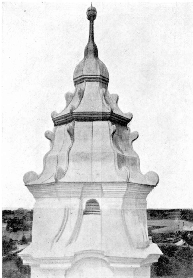
Rys. 54. Włodawa, hełm wieży kościelnej.
