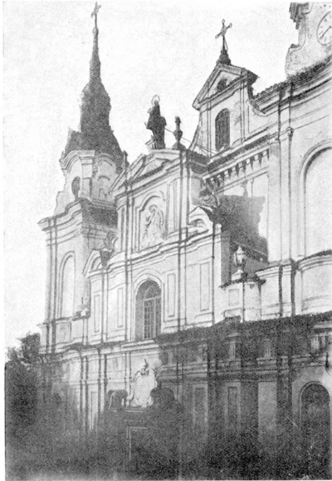
Rys. 33. Lubartów, fara, elewacja frontowa z dzwonnicy.
