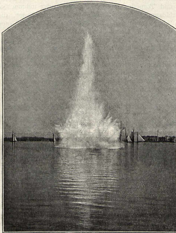
Mine mit 100 Pfund Dynamit-Ladung.
