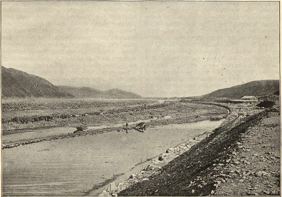
Der in der Ausführung begriffene Kanal des Eisernen Thors.
