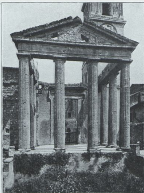
Abb. 116. Herkulestempel in Cori (Mitteilungen des Archäologischen Instituts)
