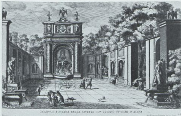
Abb. 112. Villa d'Este: Civettafontäne und Theater, ehemaliger Zustand
