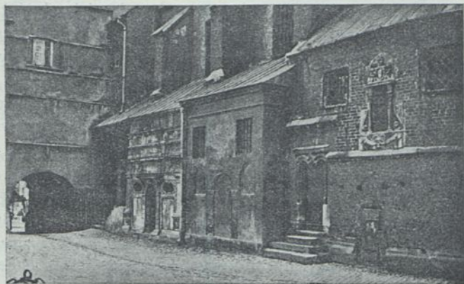
Widok ściany bocznej kościoła św. Barbary w Krakowie.
