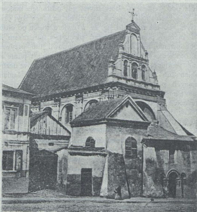
Ryc. 50. Kościół Karmelicki na placu Świętoduskim w Lublinie. Z ozdobną ścianą szczytową i bogatym gzemsem głównym i delikatnymi, lekkimi kapitelami słupów, cudnie kontrastowały proste, zwaliste formy przybudówek kościelnych, podpartych szerokimi, mocnymi skarpami, pokrytych gładkimi dachami, zwieńczonych zwykłym okapem lub skromnymi tympanami.
