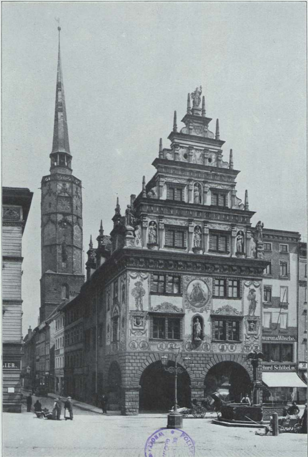
Rammereigebäude in Neisse. Mit Genehmigung der Königl. Meßbildanstalt, Berlin.
