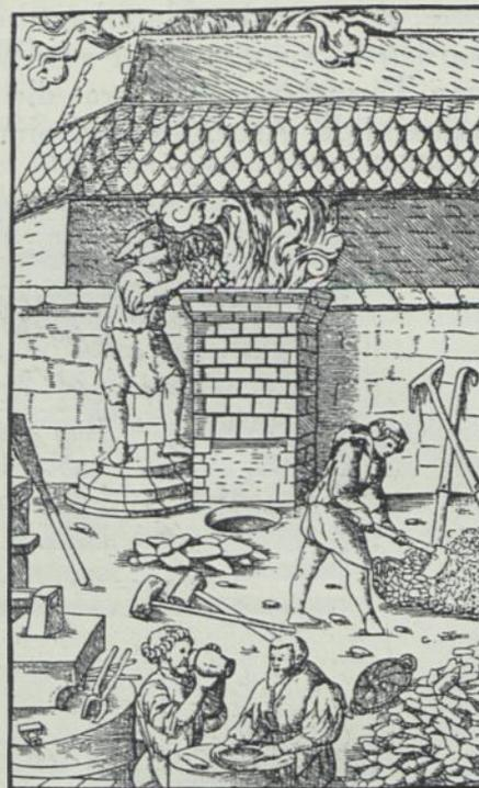
Abb. 39. Stückofenbetrieb, 16. Jahrhundert. Nach G. Agricola a. a. O., S. 341.
