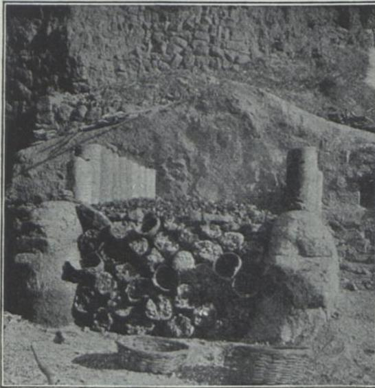
Abb. 69. Chinesischer Tiegelschmelzofen zur Erzeugung von Roheisen aus Erz.
