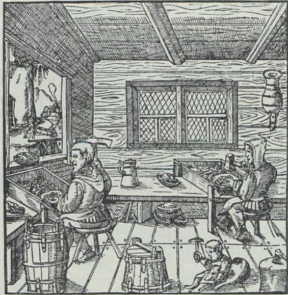
Abb. 26. Scheidung der Erze mit dem Fäustel.
