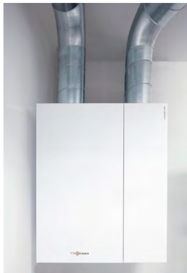
Ryc. 4. Centrala dla jednostki mieszkalnej systemu wentylacji mechanicznej z odzyskiem ciepła, Vitovent 300-W (fot. archiwum Viessmann)
