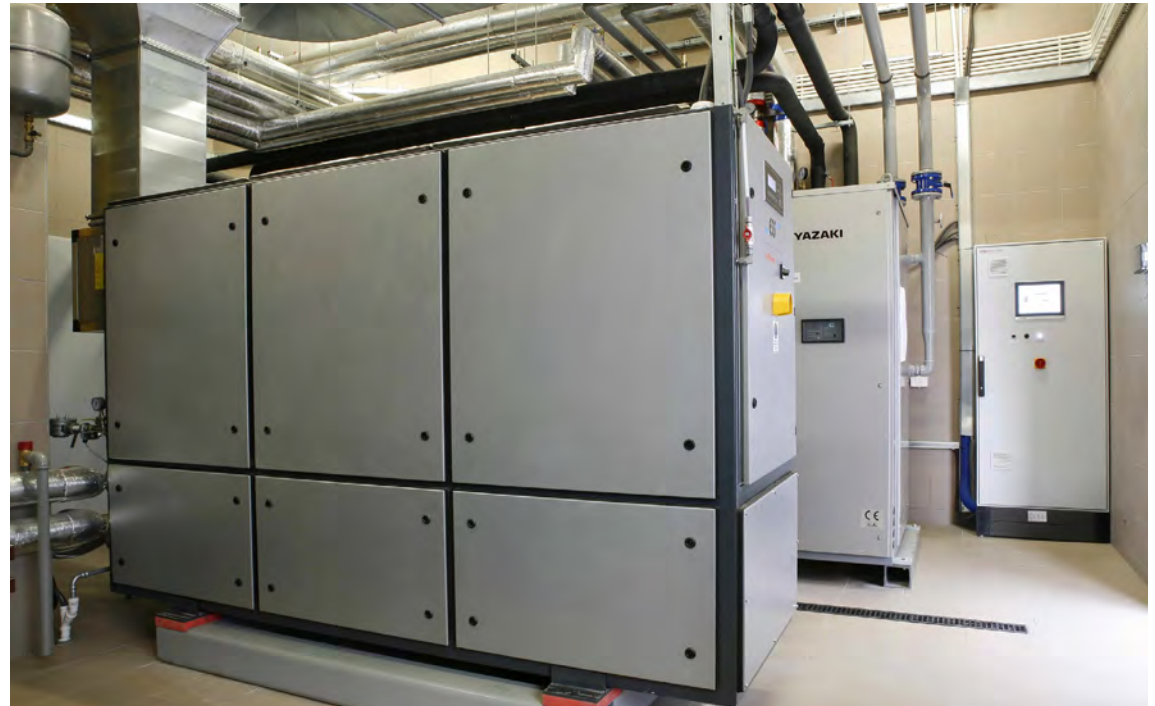
Ryc. 7. Kotłownia oparta na systemie trigeneracji – produkcja prądu, ciepła i chłodu (fot. archiwum Viessmann)
