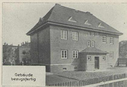
Namentlich in Bergbaugebieten, sowie an Orten mit beweglichem Baugrund und an Stellen wo Wasserentziehungsmöglichkeit des Terrains anzunehmen ist, dürfte die Stahlbauweise die gegebene Lösung sein, weil durch das System der Eisenkonstruktion eine Verankerung erzielt wird, welche die Stabilität des Hauses verbürgt.
