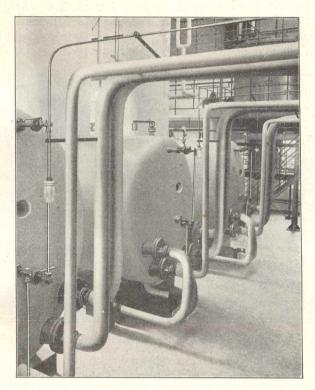
Fig. 28. Destillierblasen, Benzolfabrikationsanlage Bahnschacht.
