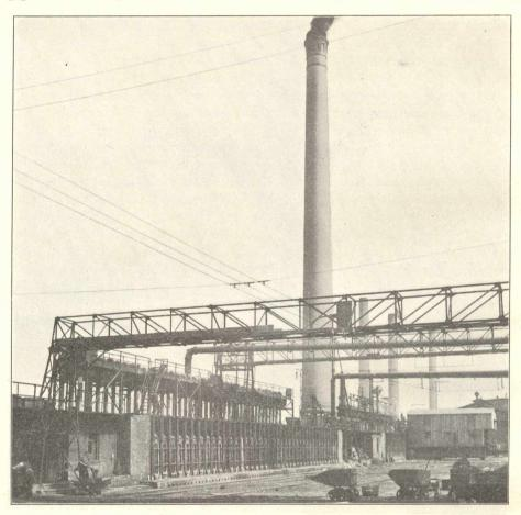
Fig. 19. Ofenbeschickung mit Absaugevorrichtung, Kokerei Bahnschacht
