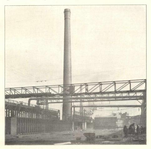
Fig. 18. Ofenbeschickung ohne Absaugevorrich ung, Kokerei Bahnschacht.
