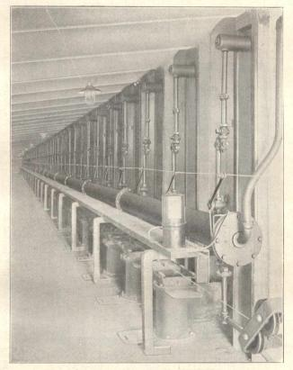
Fig. 7. Düsenkanal einer Koppers'schen Regenerativofengruppe, Kokerei Bahnschacht.
