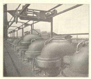
Fig. 17. Koppers'sche Absperrvorrichtung, Kokerei Bahnschacht.
