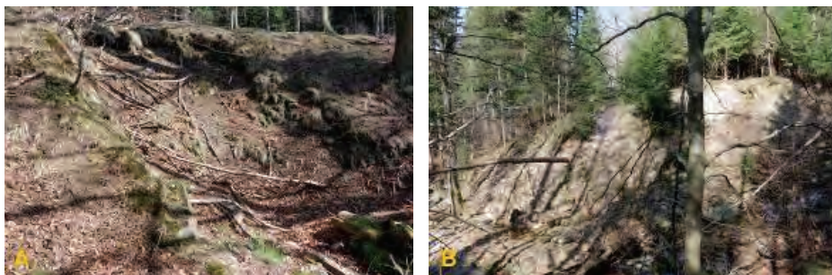
Ryc. 15. Sztolnia nr 23: A – zapadnięte okno, B – hałda (stan z 1.04.2017 r., fot. D. Wójcik) Fig. 15. Adit No. 23: A – collapsed portal, B – tailing (photo 01/04/2017, D. Wójcik)
