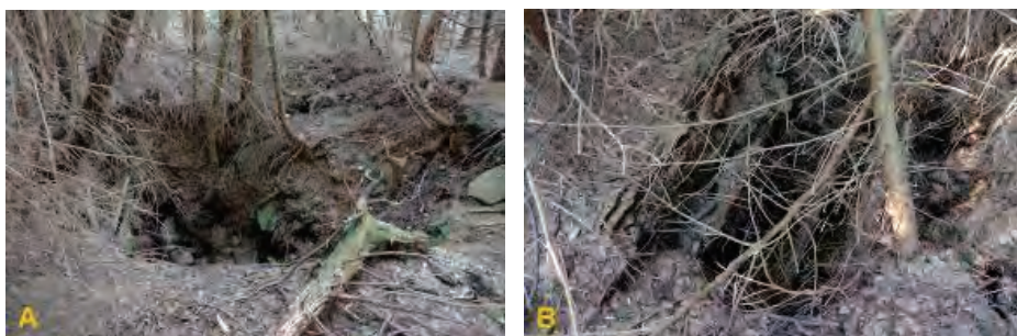
Ryc. 11. Wyrobiska „Wołowej Góry”: A – zapadlisko szybiku nr 1, B – zrąb szybiku nr 2 (stan z 1.04.2017 r., fot. D. Wójcik)
