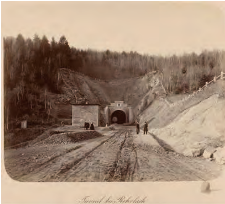
Ryc. 1. Północno-zachodni wylot tunelu kolejowego w Trzciesku podczas prac budowlanych (dolny-slask.gov.pl)
