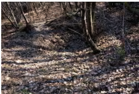
Ryc. 3. Zapadlisko szybiku nr 1 według stanu z 7.04.2018 r. (fot. M. Kalisz) Fig. 3. Collapsed shaft No. 1 as for 7/04/2018 (photo M. Kalisz)
