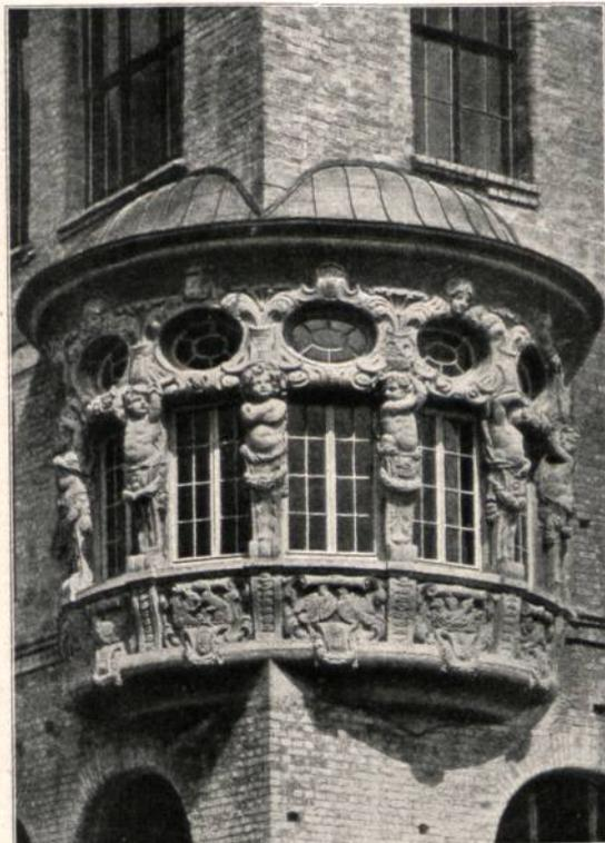
Abbildung 57. Erker am Schulhaus in Konstanz-Petershausen. Als Beispiel für die im Beton liegenden Ausdrucksmöglichkeiten. (Dyckerhoff & Widmann A.-G., Dresden.)
