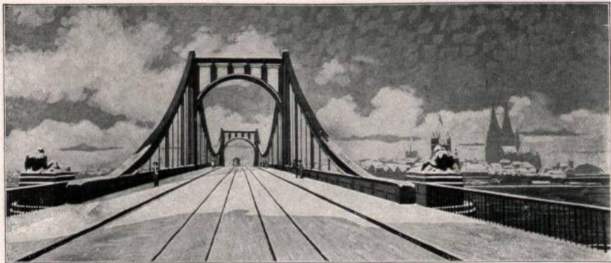
Abbildung 39. Maschinenfabrik Augsburg-Nürnberg, Gustavsburg b. Mainz. Hängebrücke in Köln (Stabkette).
