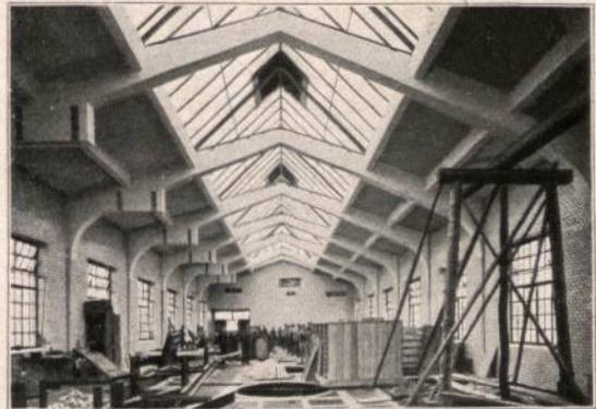
Abbildung 29. Eisenbeton-Rahmenkonstruktion für eine Halle. (Allgemeine Hochbau-Gesellschaft Düsseldorf.)
