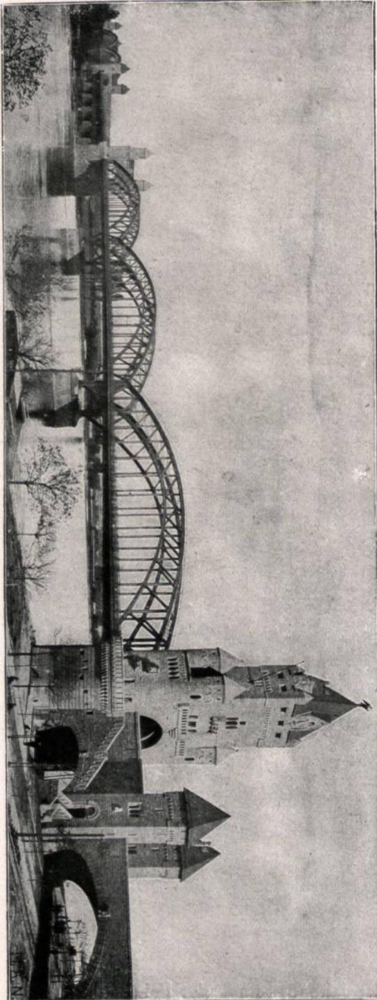
etwas größer als an den Kämpfern. Im Scheitel berührt die Fahrbahn den Bogen, im übrigen stützt sie sich auf ihn mittels entsprechend abgelängter Pfosten. Der gedrungenen Trägerform und schlanken Linienführung des Bogens wegen findet dieses System auch bei denjenigen Anklagen, die an steinernen Vorbildern den Maßstab aller Schönheit suchen (Abbildung 26).
