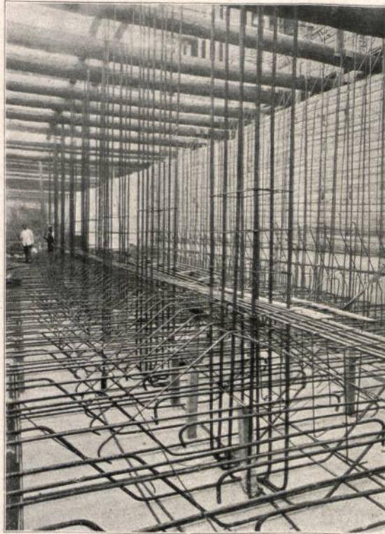
Abbildung 50. Bewehrungseinzelheiten vom Bau der Leipziger Untergrundbahn. (Kell & Löser, Leipzig.)
