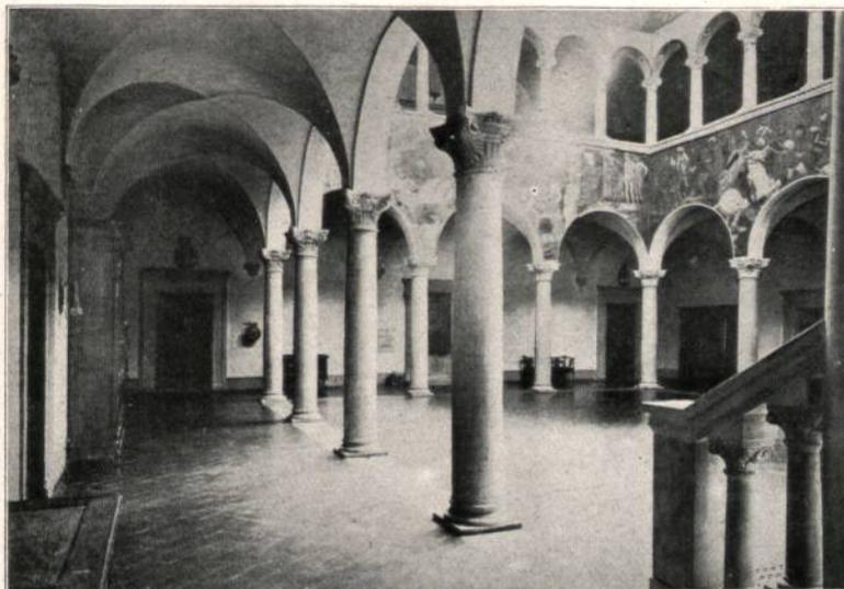
Abbildung 56. Künstlerische Formgebung und Bearbeitung des Betons. (Aus dem Eigenhaus des Herrn Oberamtsrichters a. D. Wohlgemuth in Günterstal bei Freiburg i. Br. Ausführung: Brenzinger & Co., Freiburg i. Br.)
