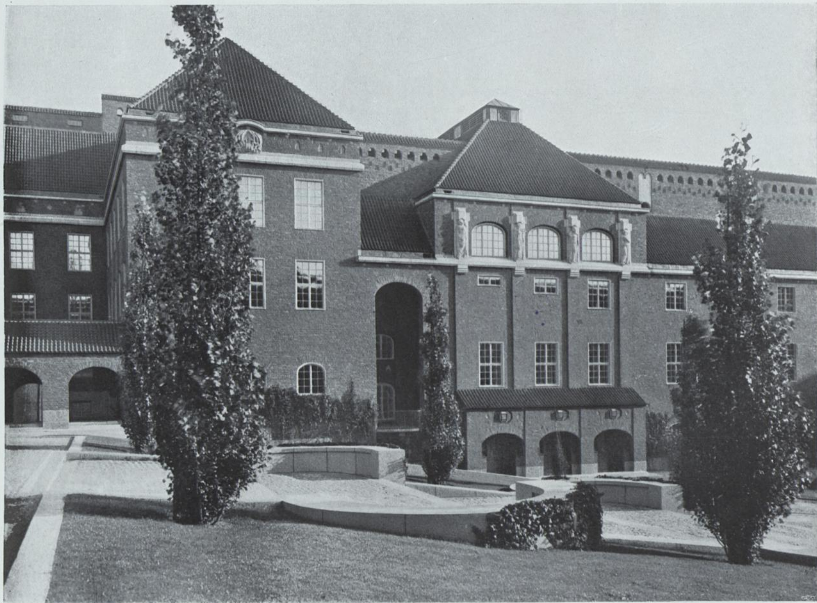
PARTI AV STORA GÅRDEN, ÖSTRA SIDAN.
