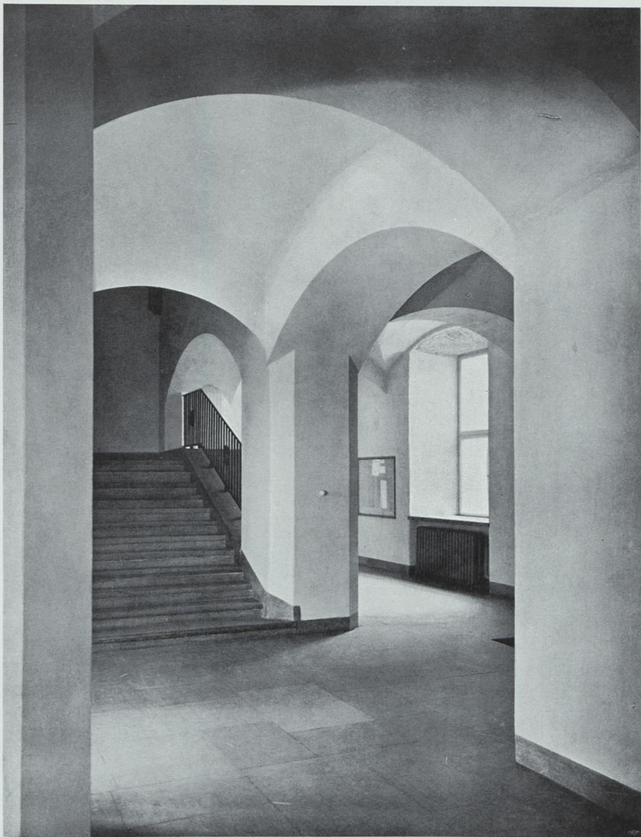
TRAPPA I VÄG- OCH VATTENBYGGNADSAVDELNINGEN.
