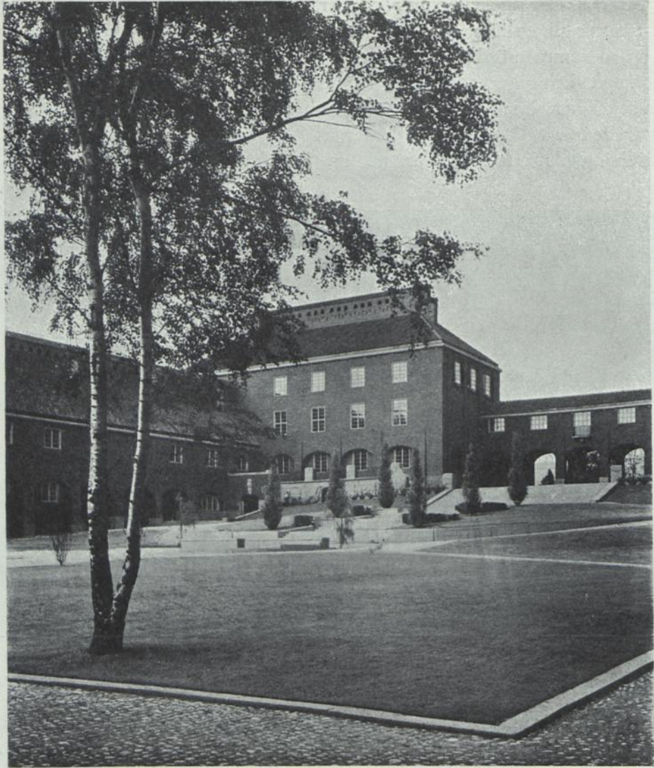
PARTI AV STORA GÅRDEN, NORDVÄSTRA HÖRNET.
