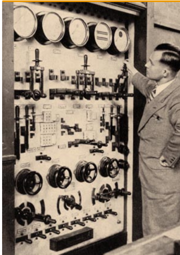
Tablica rozdzielcza w Instytucie Elektrotechnicznym, lata 30. XX wieku
