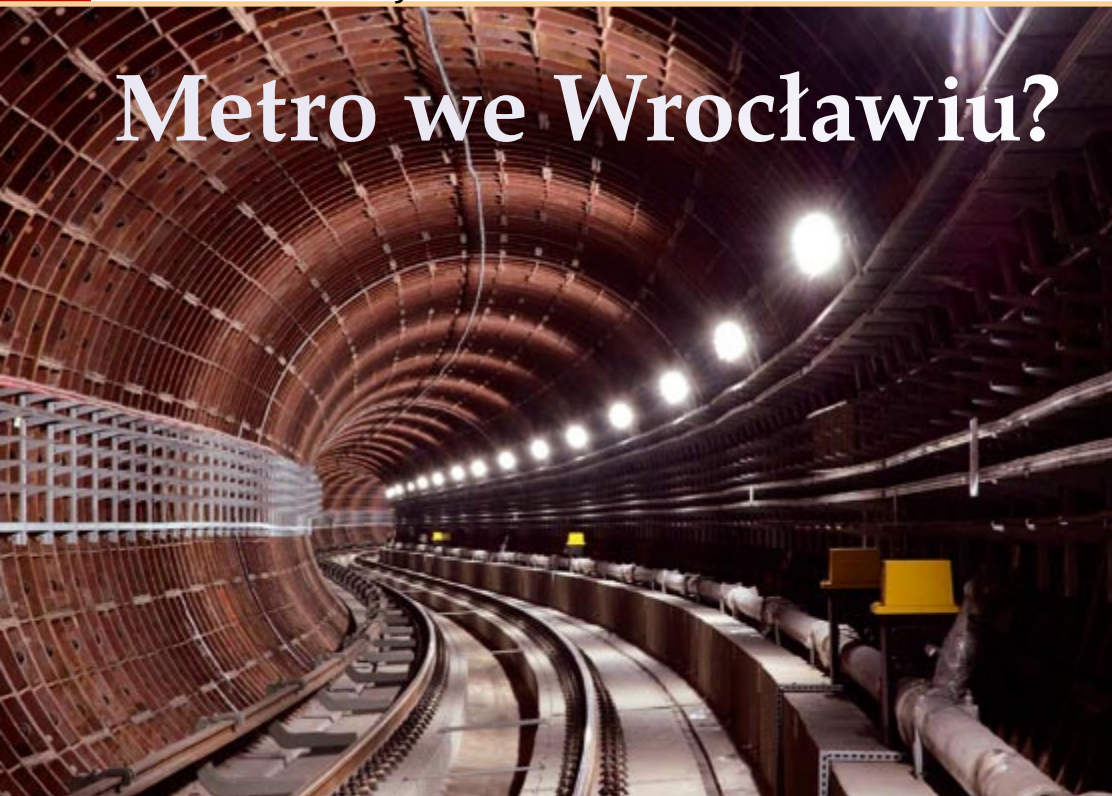
Tunel metra zrealizowany metodą górniczą
