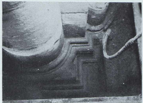
Abb. 38. Base des südöstlichen Langhauspfeilers.
