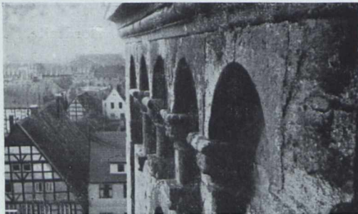
Abb. 83. Blendgalerie am Südostturm.
