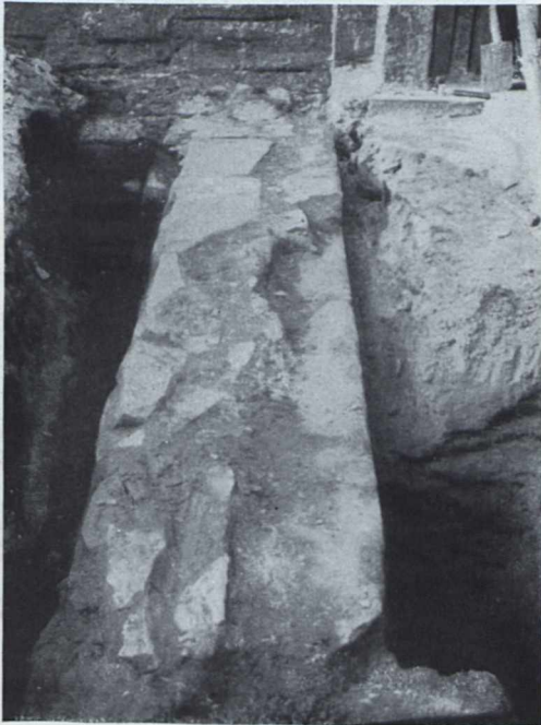
Abb. 32. Westmauer der Südvorhalle.
