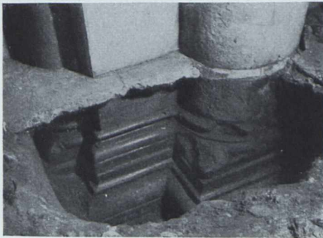
Abb. 37. Base des nordwestlichen Langhauspfeilers.
