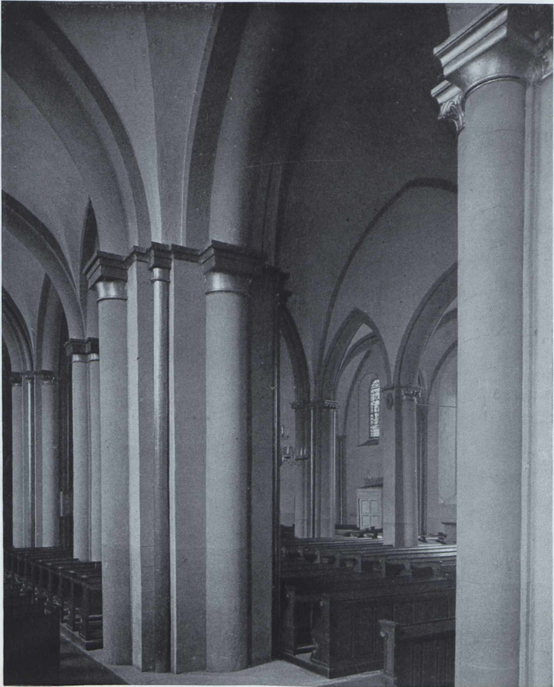
Abb. 21. Blick vom Nordseitenschiff ins Langhaus.
