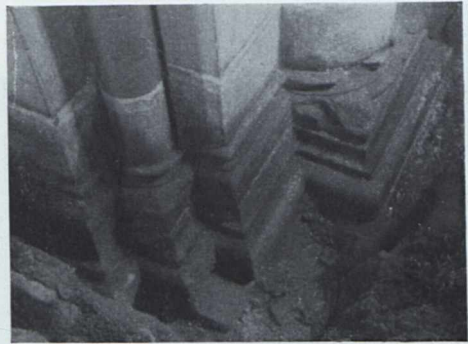
Abb. 36. Base des nordwestlichen Langhauspfeilers.
