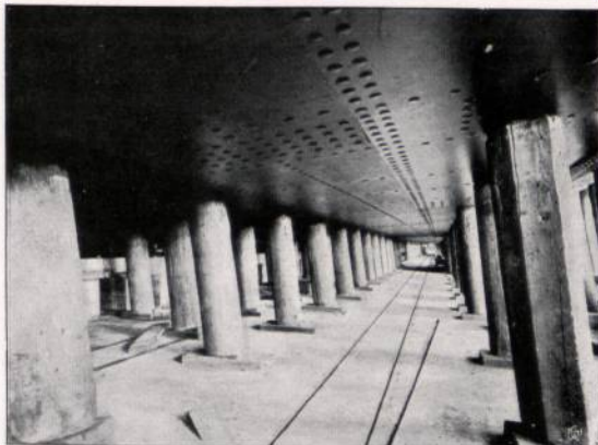
Abbildung 70. Boden des Riesendampfers „Olympic“ der White-Star-Line (Liverpool) kurz vor dem Stapellauf. Gebaut bei Harland & Wolff, Ltd. in Belfast.
