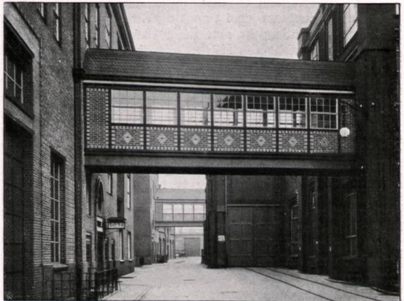
Abbildung 2. Hof mit Eisenbahngeleis und Übergangsbrücken.
