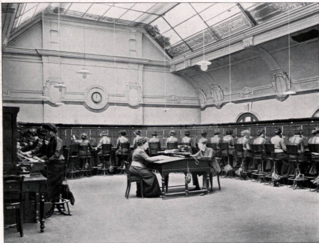
Abbildung 21. Ortsfernspredamt Berlin-Kurfürst, Teilaufnahme (A.-G. Siemens & Halske, Berlin). A-Schränke ohne Vielfachfeld für den Dienstleistungsbetrieb.
