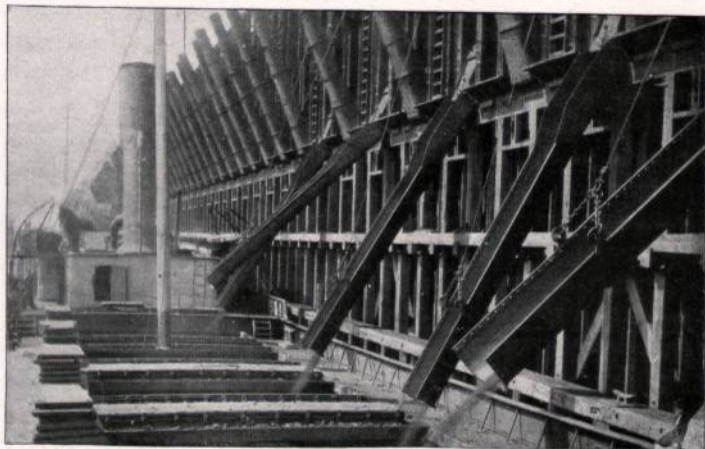
Abbildung 11. Amerikanischer Binnenseedampfer beim Übernehmen der Ladung mit Schüttrinnen.
