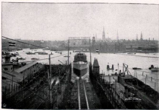
Abbildung 71. Stapellauf auf der Reiherstieg-Schiffswerft und Maschinenfabrik in Hamburg. Auf der Abbildung ist die eigenartige Hellingkranlage mit Drahtseilen über der ganzen Länge der Helling erkennbar.
