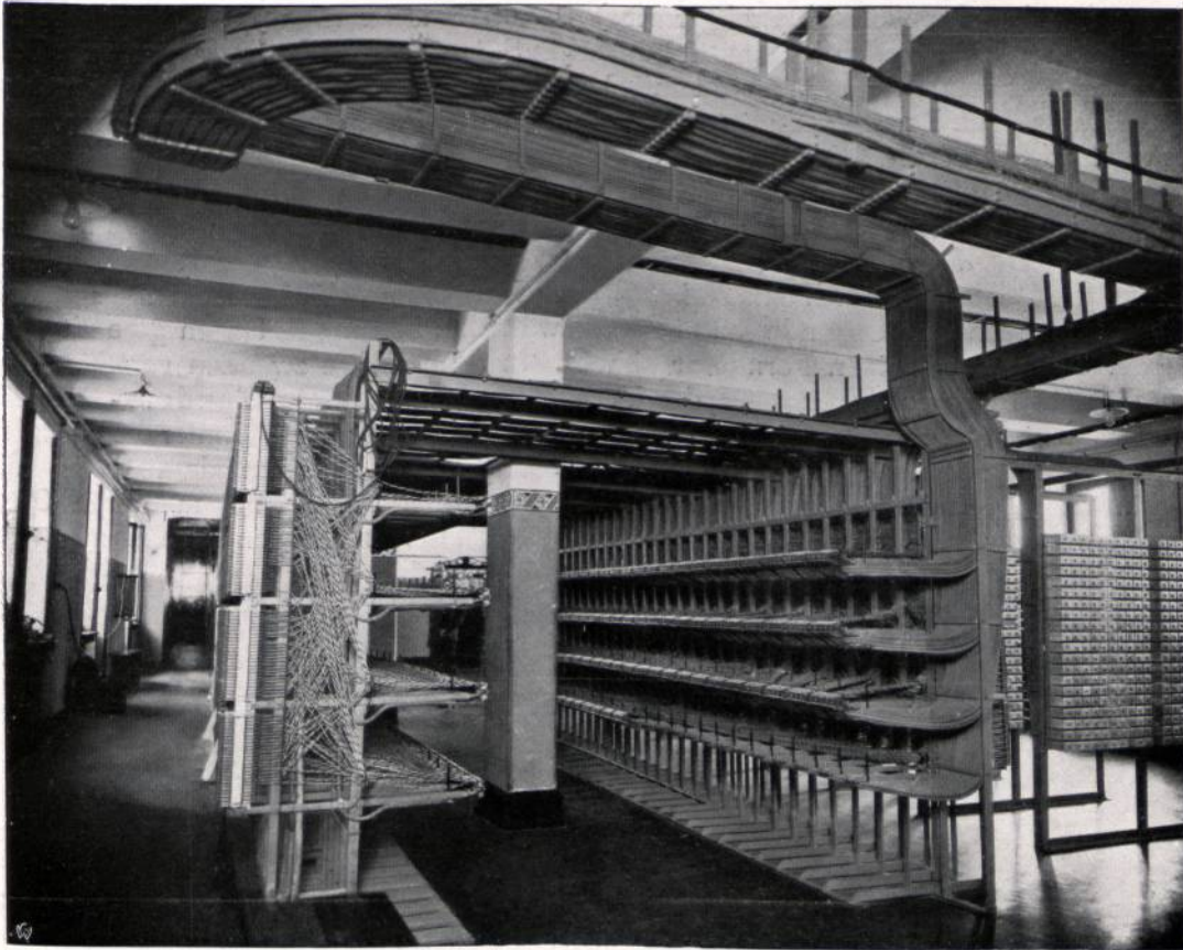
Abbildung 20. Umschalerraum des Fernsprechamts in Meß (Deutsche Telephonwerke G. m. b. H., Berlin). Links der Hauptverteiler mit Sicherungsleisten, in der Mitte der Zwischenverteiler mit Lötösenstreifen und rechts die Relaisgestelle.
