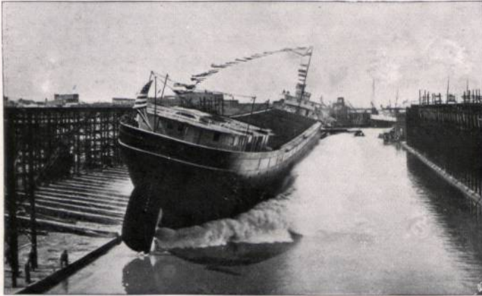
Abbildung 72. Seitlicher Stapellauf, besonders häufig an den amerikanischen Binnenseen angewandt, wo enge Flußläufe einen Längsablauf nicht gestatten. Der ablaufende Dampfer hat eine Länge von 154 m und einen Bruttoreaumgehalt von 4900 Reg.To, entspricht also der Größe der größten Überseefracht-dampfer.
