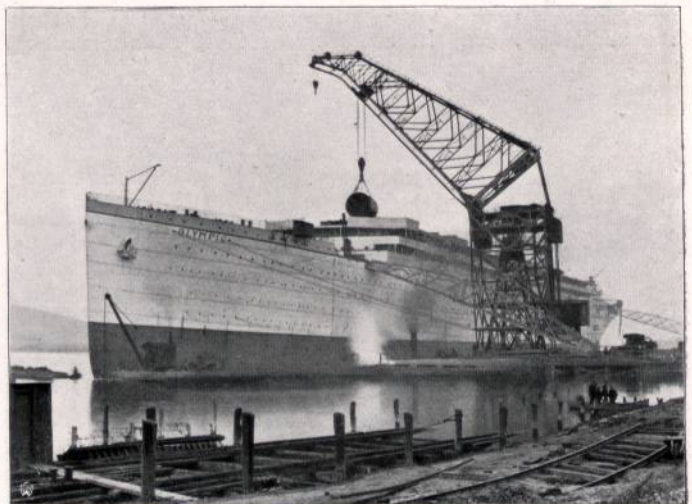
Abbildung 77. Großer Schwimmdrehkran von 150 t Nutzlast, ausgeführt von der Deutschen Maschinenfabrik A.-G. in Duisburg für Harland & Wolff Ltd. in Belfast, einen Kessel in den Riesendampfer „Olympic“ einsetzend.
