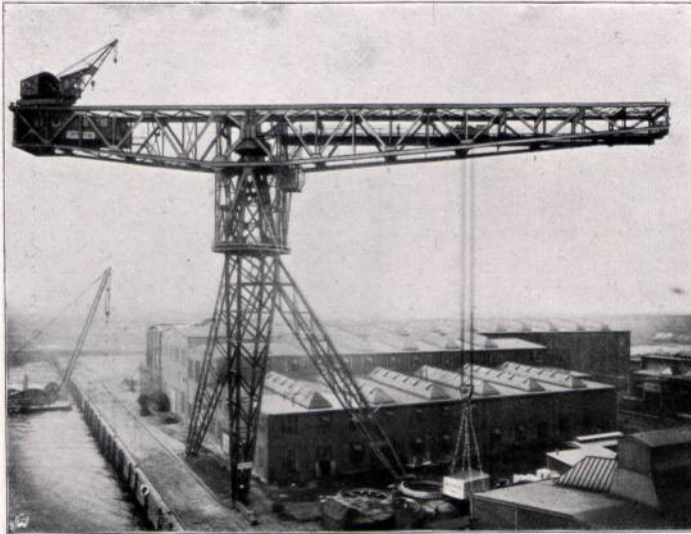
Abbildung 76. Großer Turmdrehkran für 250 t Probelast auf der neuen Werft der Vulcanwerke in Hamburg, ausgeführt von der Deutschen Maschinenfabrik A.-G. in Duisburg.
