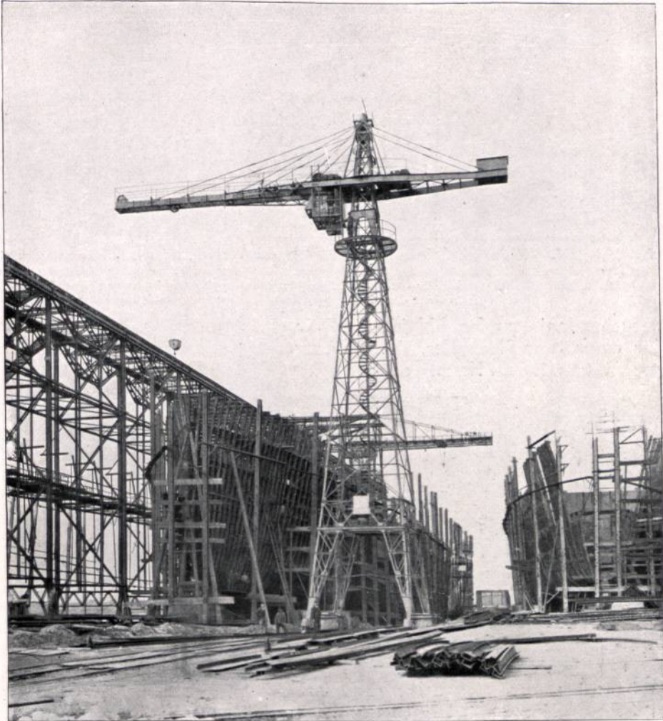
Abbildung 60. Hellingkrananlage mit fahrbaren Turmdrehkränen auf der Werft des Bremer Vulcan, Schiffbau und Maschinenfabrik, in Vegesack, ausgeführt von der deutschen Maschinenfabrik A.-G. in Duisburg. Im Vordergrund: Turmdrehkran mit Fahrbahn auf Werftflur; im Hintergrunde Cantileverkran auf Hochbahn (Hochbahn links sichtbar).
