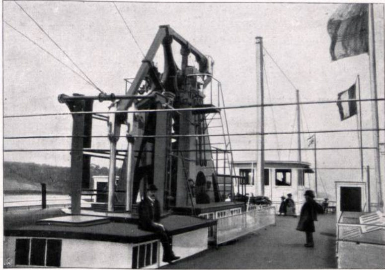
Abbildung 84. Deck eines amerikanischen Flußdampfers mit dem Balancier der Räderschiffmaschine.
