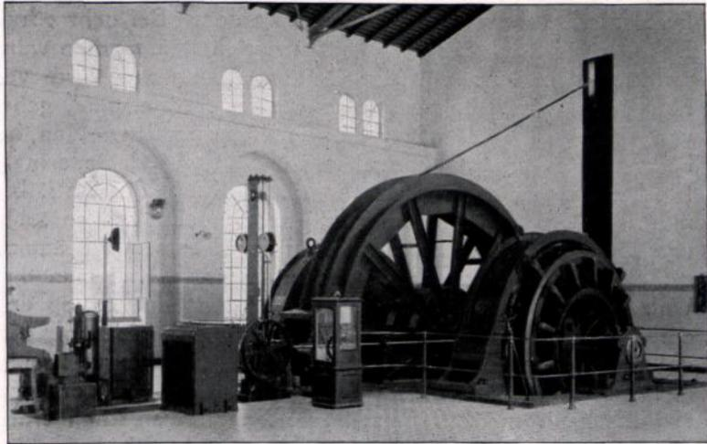
Abbildung 209. Förderanlage der Zeche Gottfried Wilhelm in Rellinghausen, ausgeführt von den Siemens-Schuckert-Werken, Berlin.
