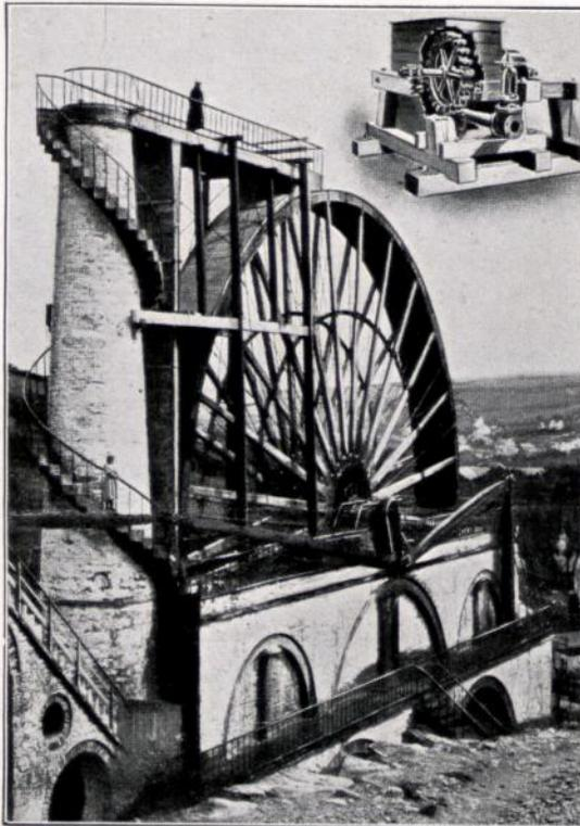
Abbildung 20. Wasserrad auf der Insel Man; das Wasser kommt durch den gemauerten Turm und läuft auf das Rad. — Oben rechts zum Vergleich ein Peltonrad gleicher Leistung.
