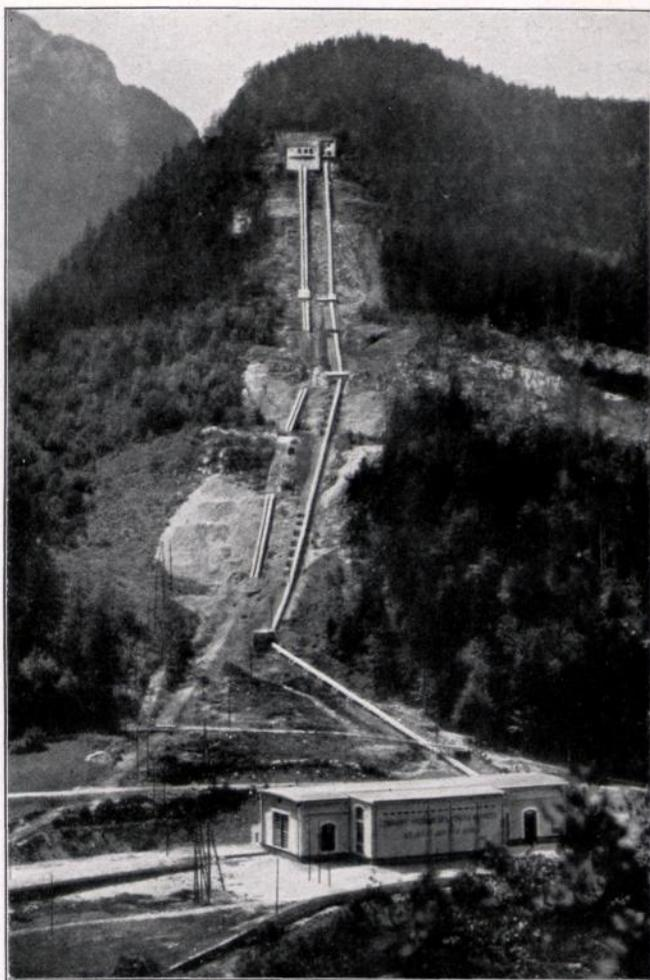
Abb. 17. Blick auf ein Wasserkraftwerk und auf die Druckleitungen. Aus „Zeitschrift f. d. ges. Turbinenwesen“ 1908. (Verlag R. Oldenbourg, München.)
