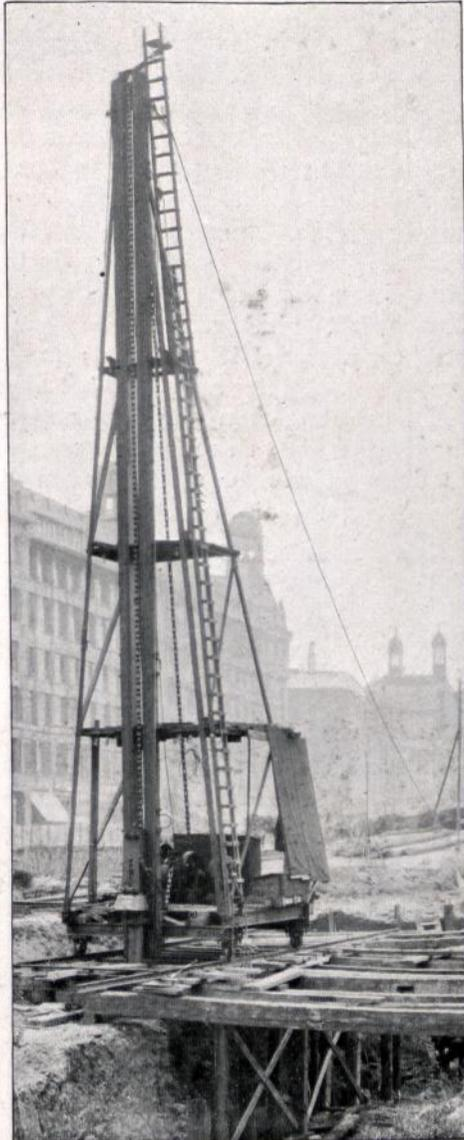
Abbild. 8. Ramme mit elektrischem Antrieb.
