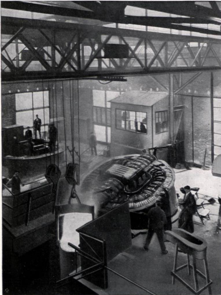
Abbildung 27. Abstich eines Röchling-Rodenhauser-Ofens für Elektro Stahl.
