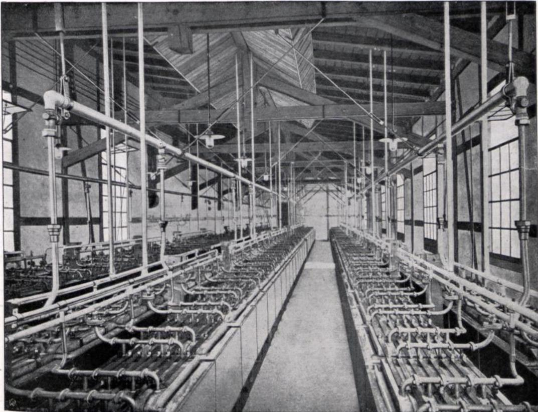
Abbildung 10. Elektrolytische Anlage „System Schuckert“ zur Gewinnung von 1200 cbm Wasserstoff und 600 cbm Sauerstoff innerhalb 24 Stunden. (Seit 1902 in Dauerbetrieb.)
