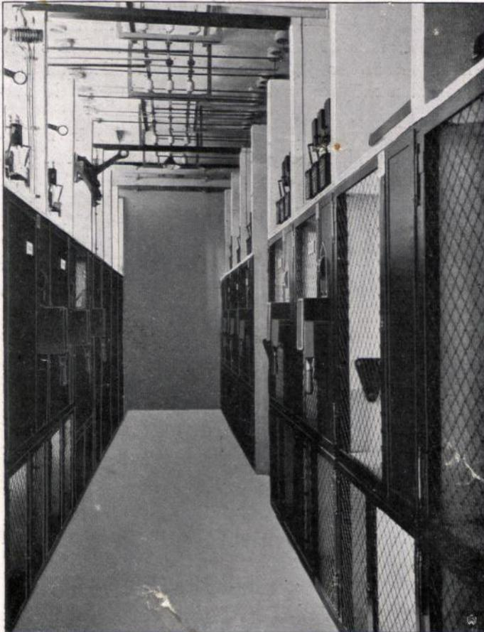
Abbildung 165. Generatorwand nach dem Zellensystem für Drehstrom, ausgeführt von Voigt & Haefner für die Phönix-A.-G.
