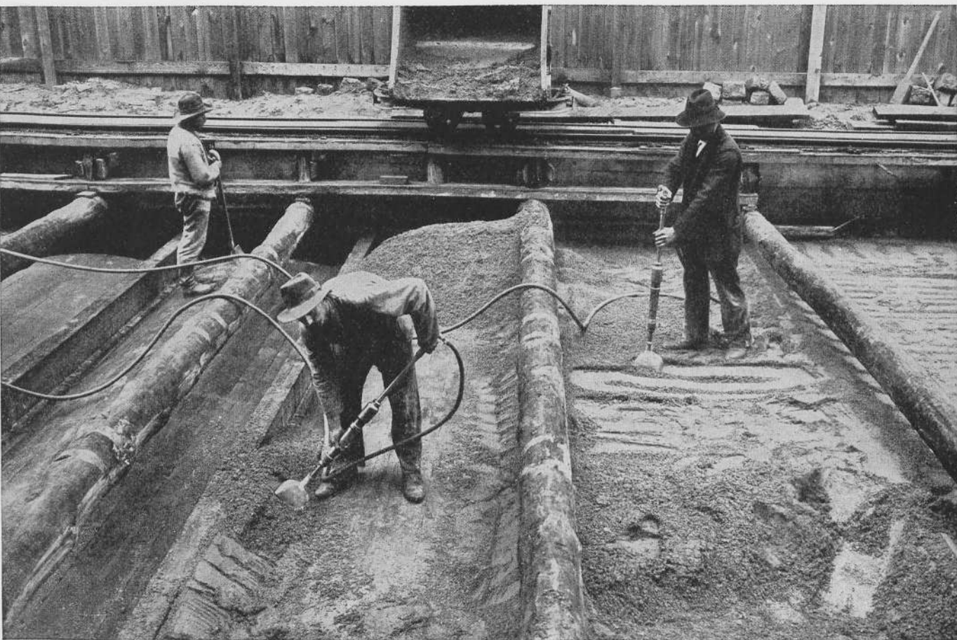
Einstampfen des Betons für die Tunneldecke mit Druckluftwerkzeugen
