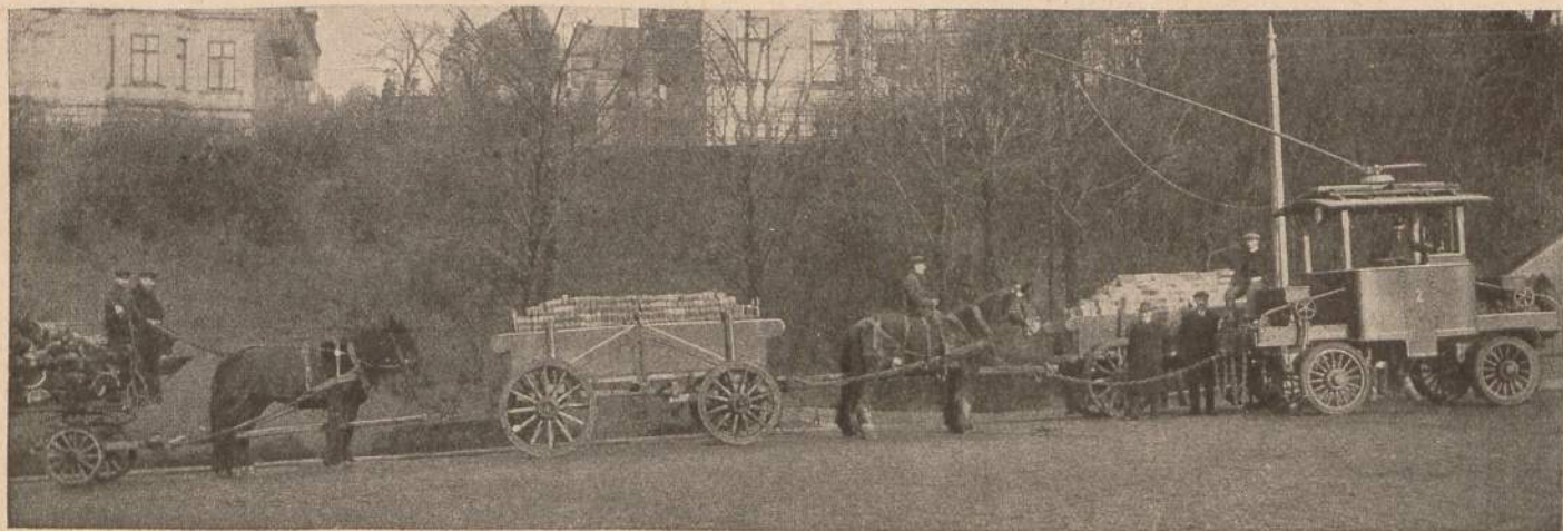
823. Wagen der gleislosen Straßenbahn als Schlepper in einer steil ansteigenden Straße am Hafen von Altona
