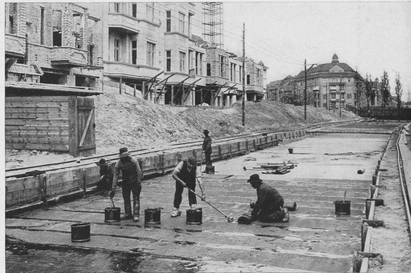
Aufbringen der Dichtungsschicht auf die Tunneldecke
