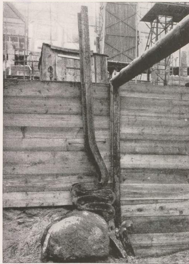
Baugrubenwand, mit Schalbrettern ausgekleidet. Davor ein gefalteter Doppel-T-Träger, der beim Einrammen auf einen Granitblock geriet
