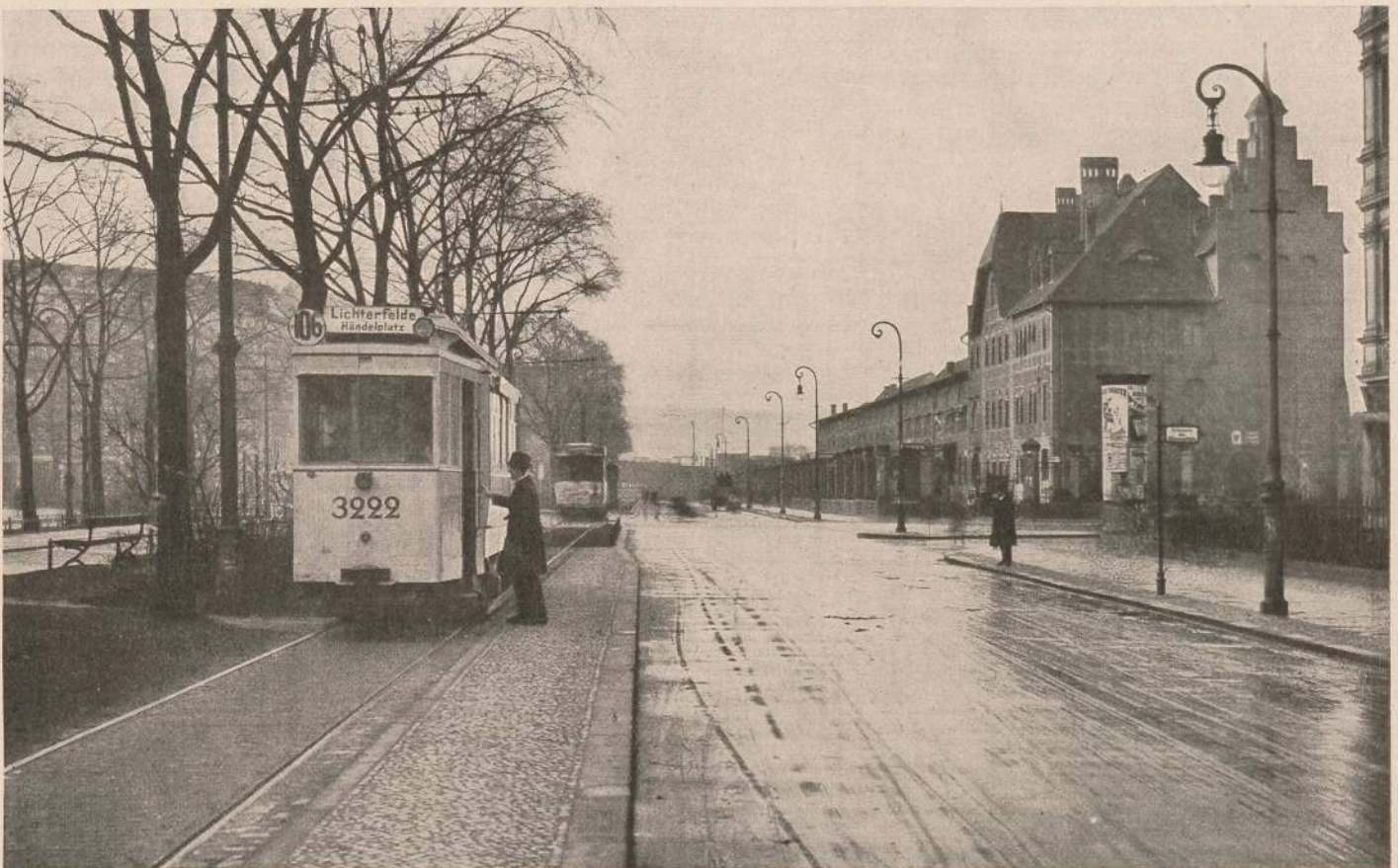
741. Haltestelle mit Schutzinsel zur Seite eines Gleises auf eigenem Bahnkörper
