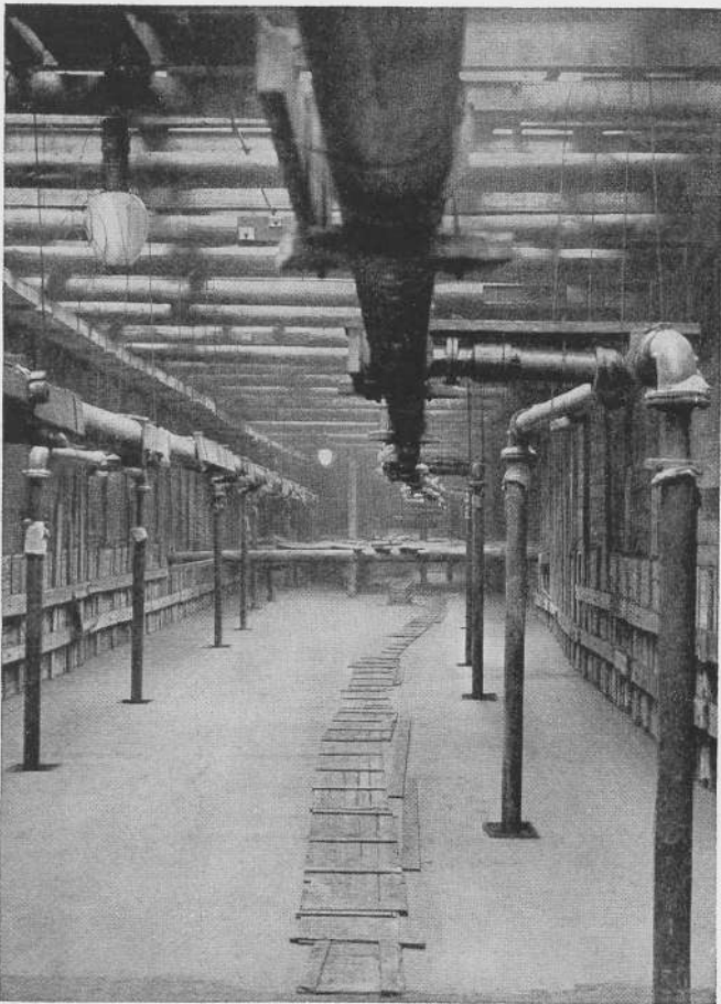
Fertige Tunnelsohle mit zweireihiger Wasserhaltungsanlage
