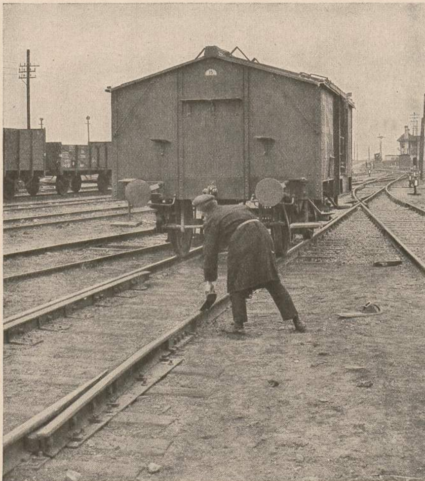
436. Gleisbremse
