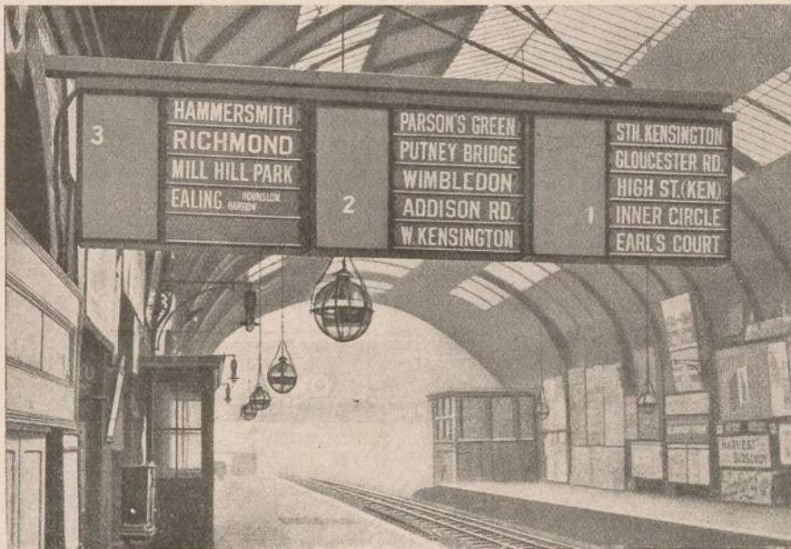
656. Zugrichtungsanzeiger auf einem Londoner Schnellbahnhof
