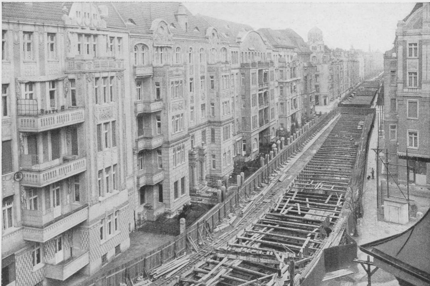
Blick auf eine abgesteifte Baugrube. Zwischen die Köpfe der Doppel-T-Träger sind Baumstämme gesetzt
