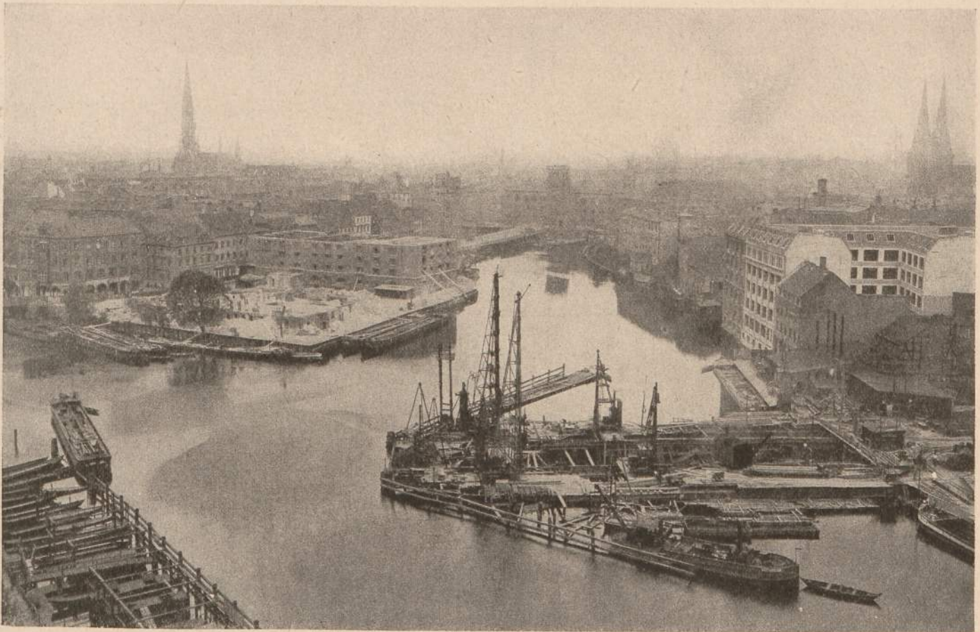
607. Herstellung des Fangedamms für den zweiten Bauabschnitt der Spreeunterführung an der Wallstraße mit den Rammen zum Eintreiben der Spundpfähle für den Dammbau
