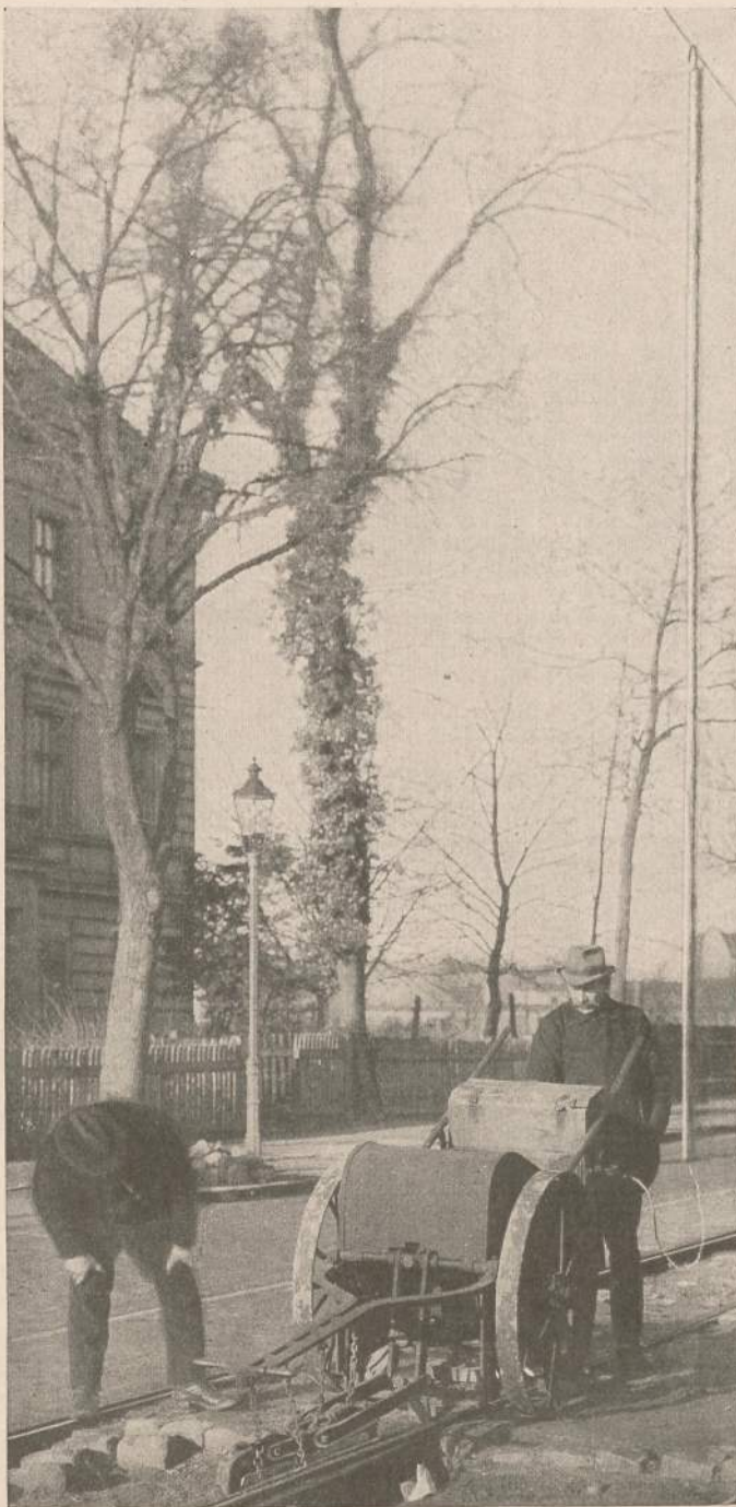
732. Elektrisch angetriebene Schienenfeile
