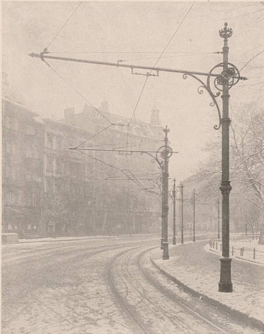
705. Auslegermaste zum Tragen einer seitlich liegenden Oberleitung Gradlinige Form der Arme mit Hilfsverspannung
