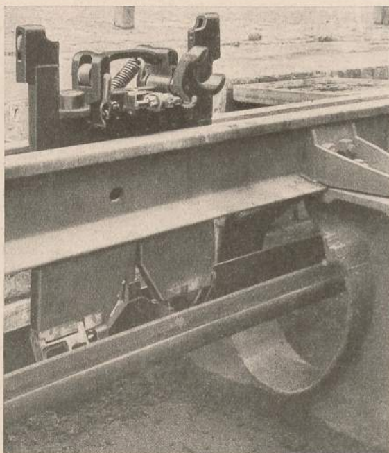
724. Schützunterleitung im Bau
