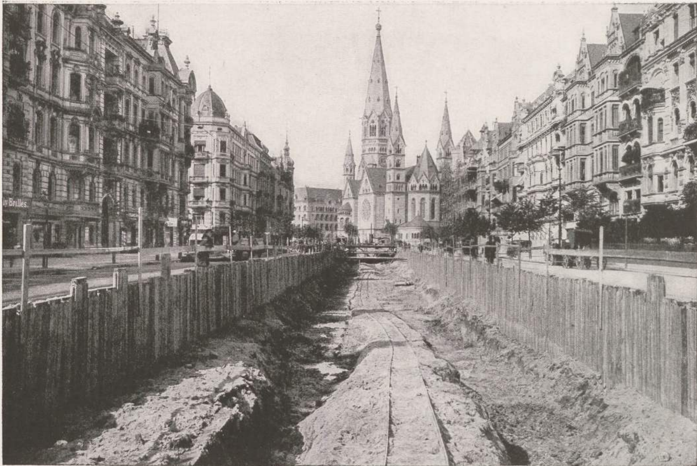
Vom Bau der ältesten Tunnelstrecke: hölzerne Spundwände in der Tauenzienstraße. Im Hintergrund die Kaiser Wilhelm-Gedächtnis-Kirche
