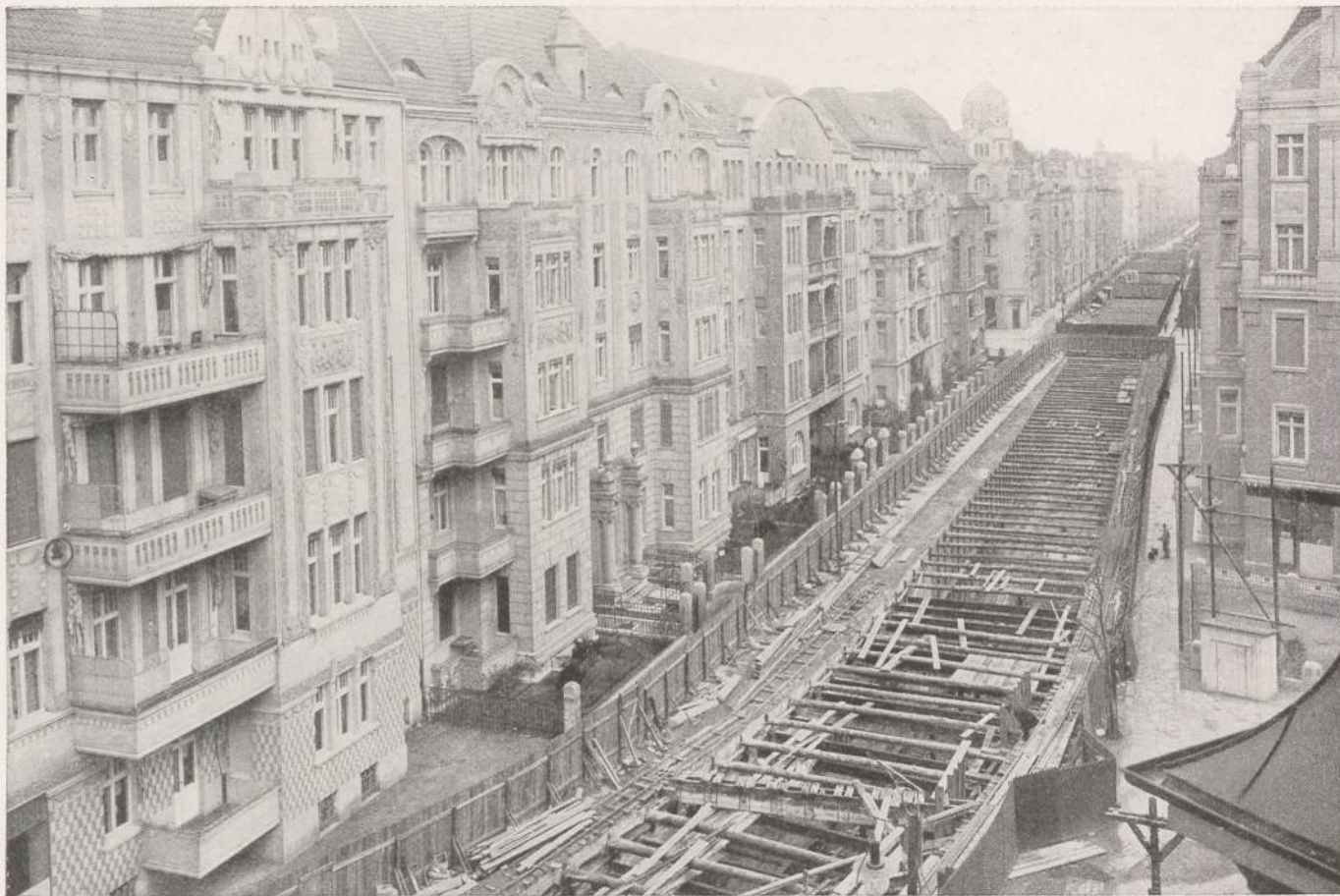
Blick auf eine abgegräbte Baugrube. Zwischen die Köpfe der Doppel-T-Träger sind Baumstämme gefügt
