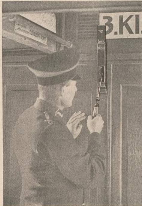
662. Betätigung des Kurzschließers
