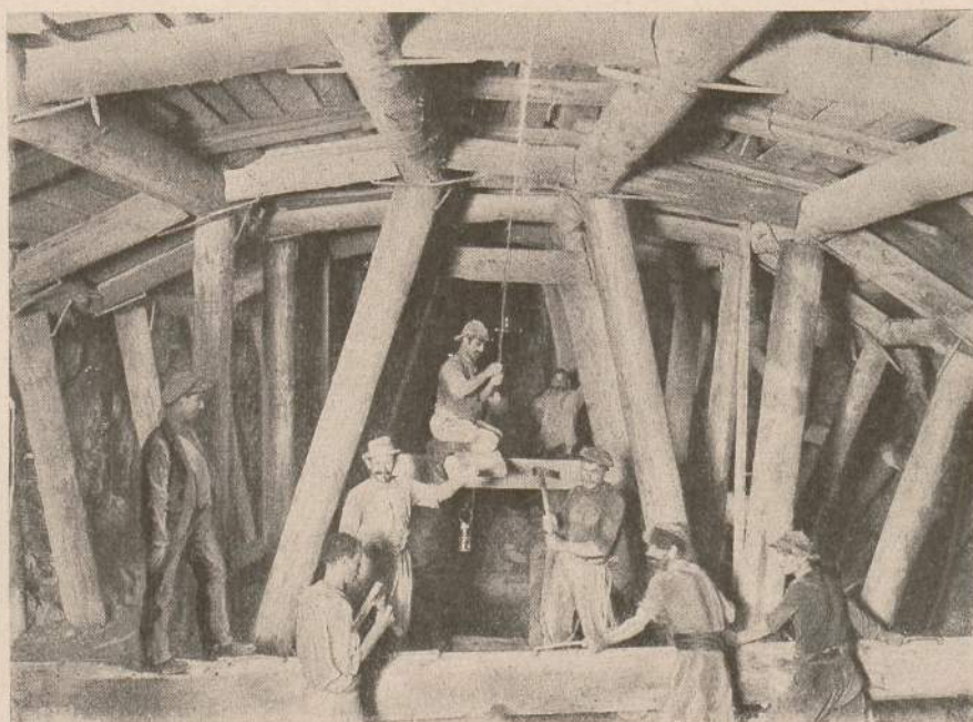
305. Richtlampe im Tunnel
