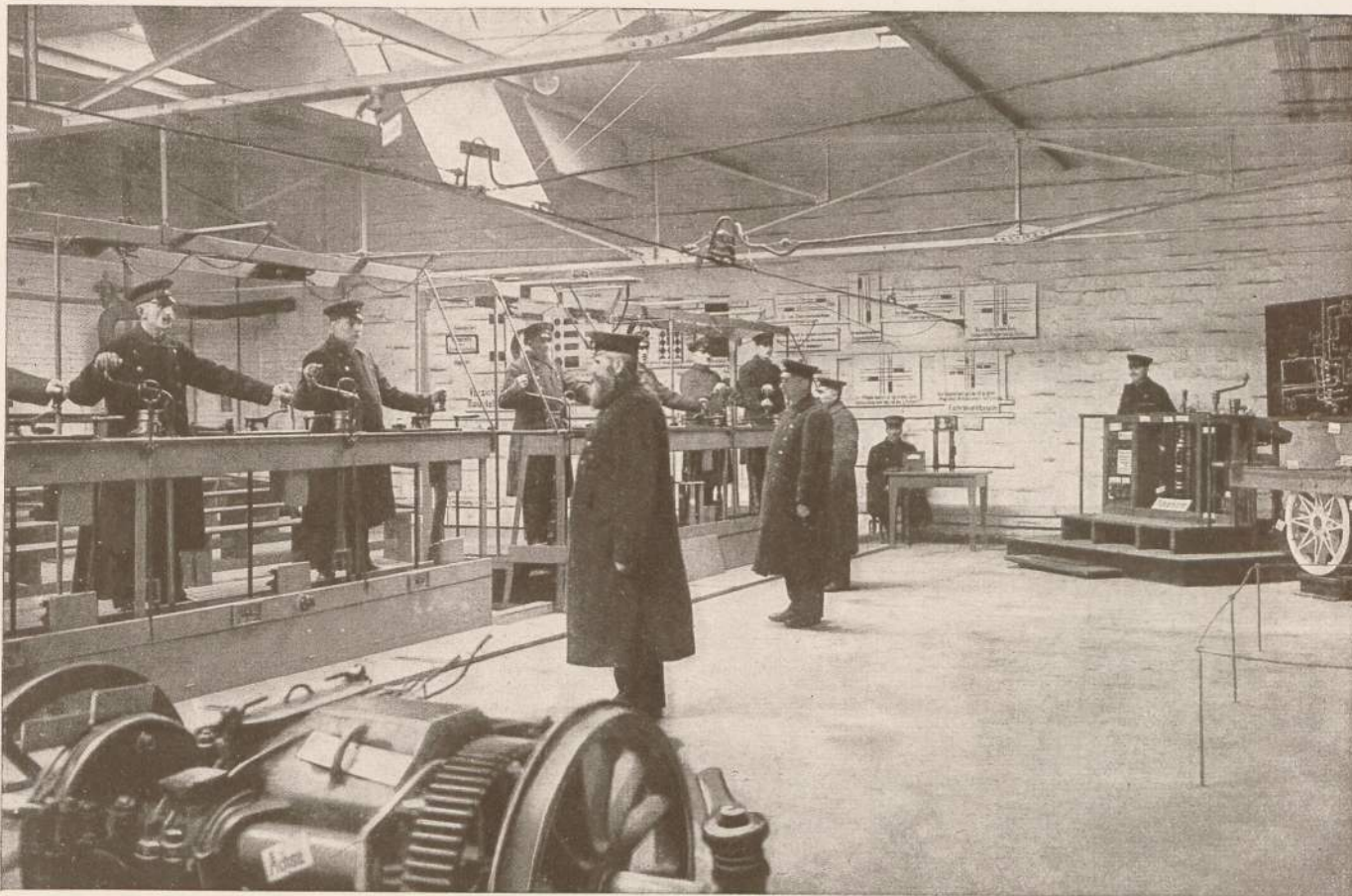
2. Einüben der Bedienung von Fahr- und Handbremskurbel von dem hier rechts sichtbaren Pult aus erfolgt auch das Einschalten der Lampen hinter der Streckenschautafel auf Bild 4
