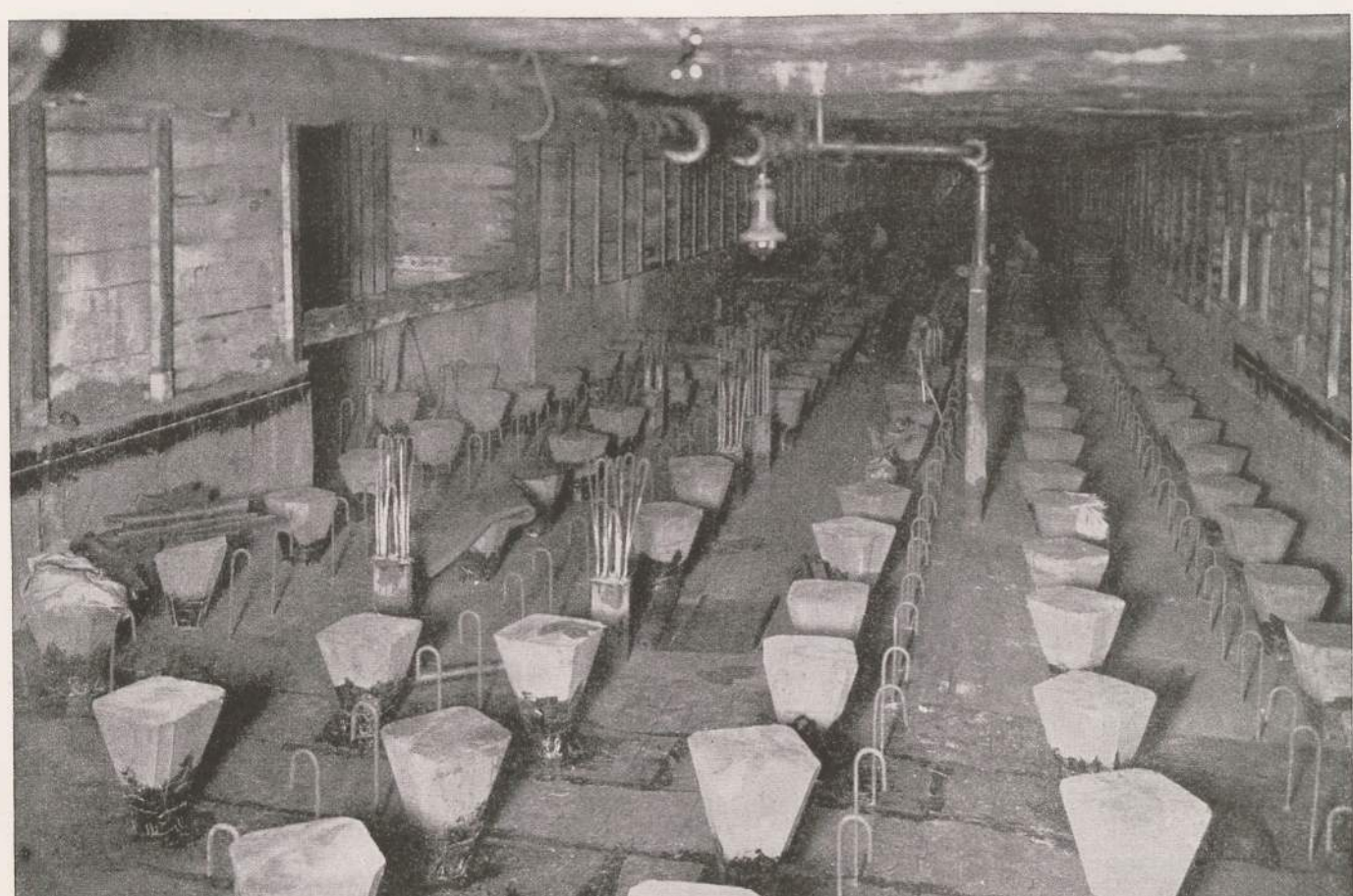
Köpfe der Betonpfähle, auf denen der Tunnel im südlichen Teil der Friedrichstraße ruht. Siehe auch Bild 596
