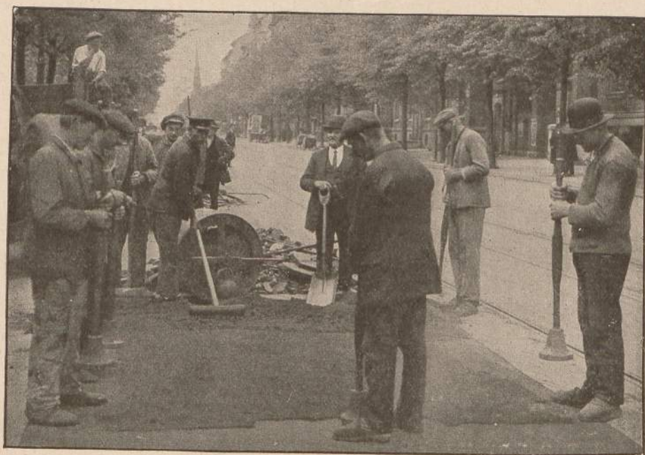
52. Aufstampfen und Walzen des Asphalts mit angewärmten Werkzeugen
