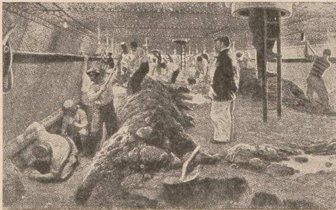
615. Blick in die Arbeitskammer unter dem Seinetunnel
