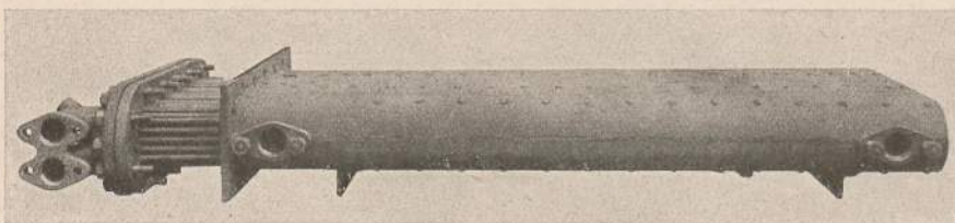
391. Speisewasser-Vorwärmer Bauart Vulcan
