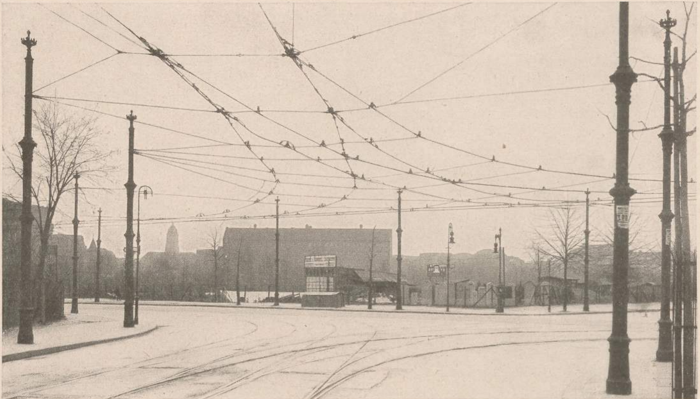
714. Oberleitung an einer Verzweigungsstelle
