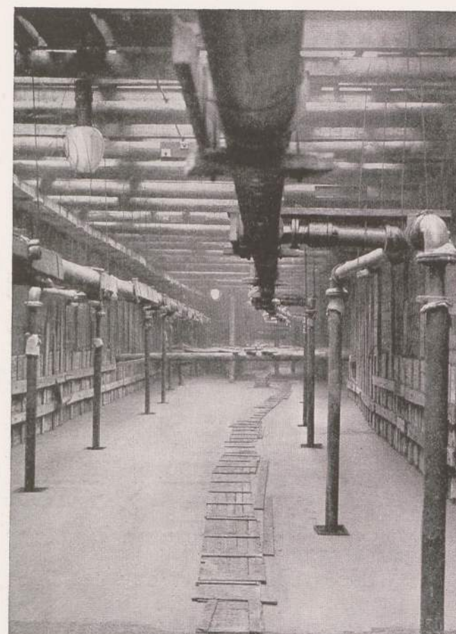
Fertige Tunnelsohle mit zweireihiger Wasserhaltungsanlage
