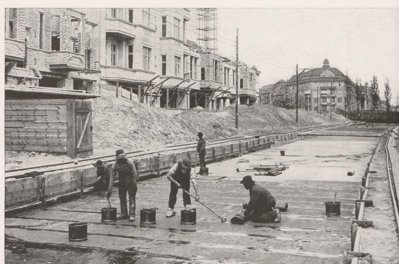
Aufbringen der Dichtungsschicht auf die Tunneldecke
