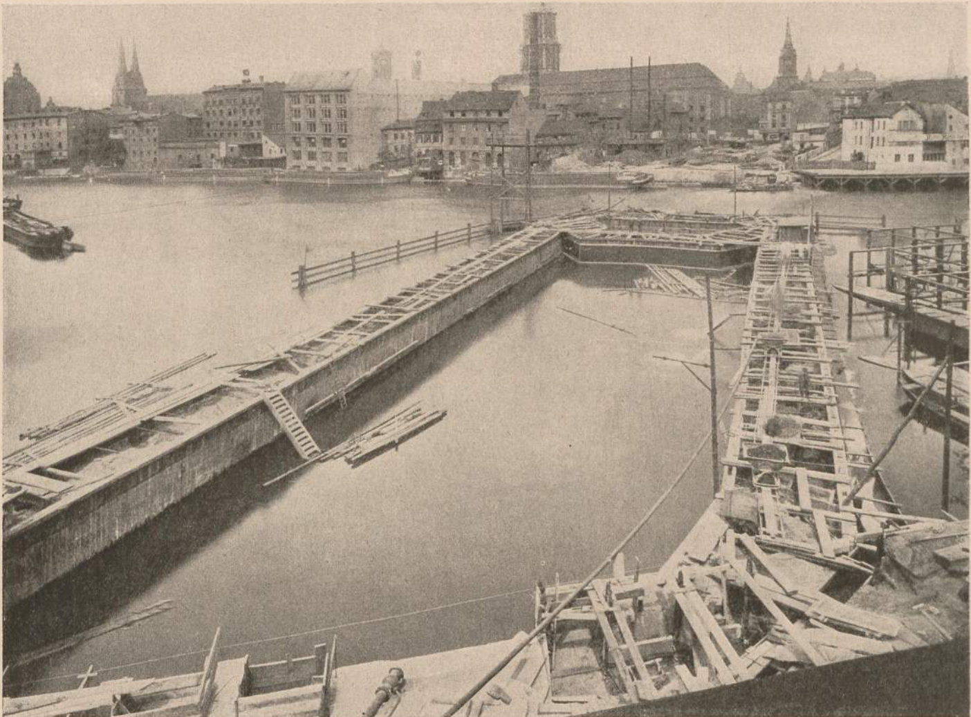
605. Fangedamm für den ersten Bauabschnitt der Spreeunterfahung an der Wallstraße Unternehmerin war die Gesellschaft für den Bau von Untergrundbahnen in Berlin
