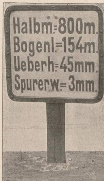
335. Krümmungs-Täfelchen Gibt Halbmesser, Bogenlänge, Überhöhung und Spurerweiterung für die Krümmung an
