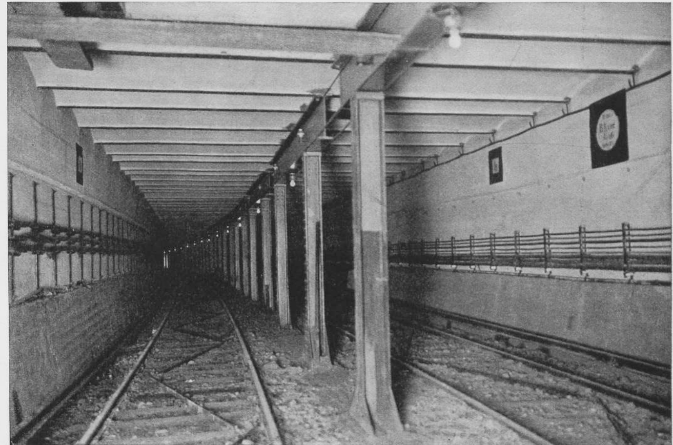
Blick in einen fertigen Tunnel mit Mittelstützen. An den Wänden sind die stromführenden Kabel aufgehängt
