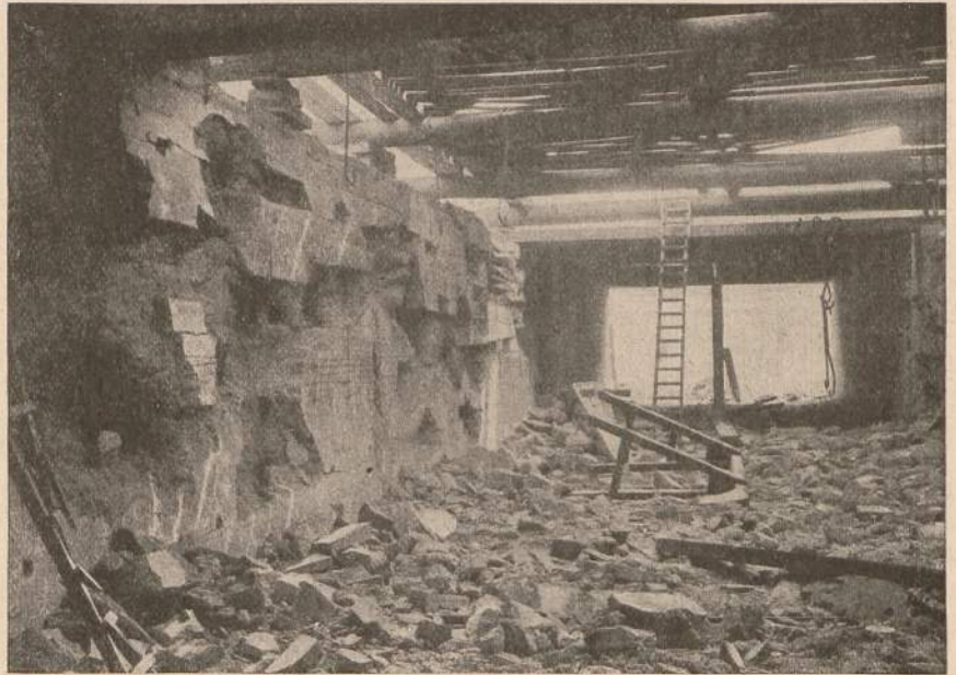
634. Gesprengte Tunnelwände
