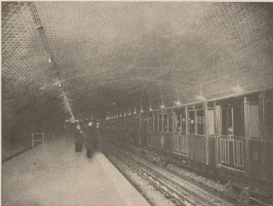
565. Haltestelle der Pariser Untergrundbahn mit gewölbter Decke
