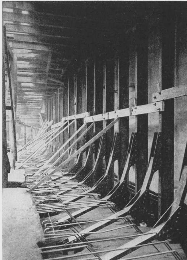
Eiserne Stützen für eine Tunnelwand, die alsbald mit Beton umkleidet werden
