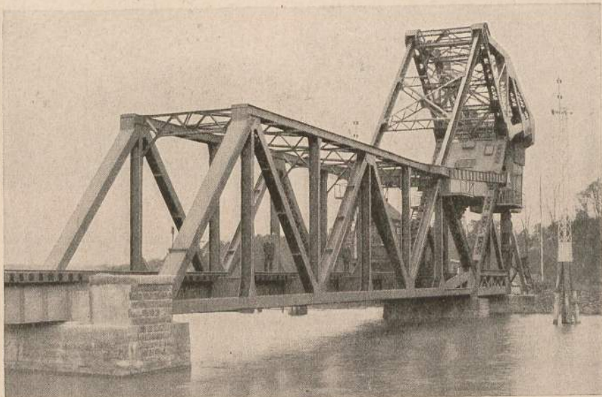
293. Die Wippbrücke über den Trollhätta-Kanal geschlossen. Das Gegengewicht ist emporgehoben
