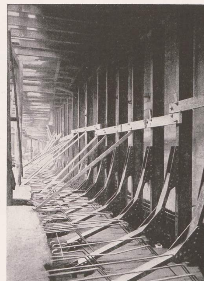
Eiserne Stützen für eine Tunnelwand, die alsbald mit Beton umkleidet werden
