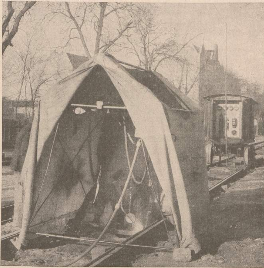
730. Herstellung einer Stoßverschweißung
