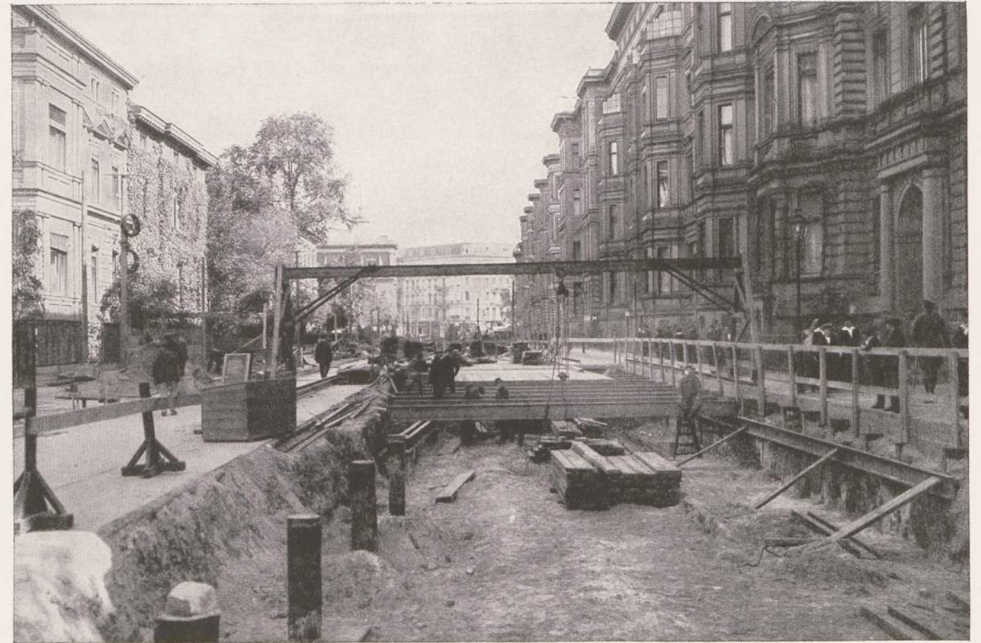
Einbau der Straßenabdeckung. Über solche Brücken geht, nachdem sie mit Bohlen belegt sind, der Straßenverkehr hinüber, während drunten ausgeschachtet wird
