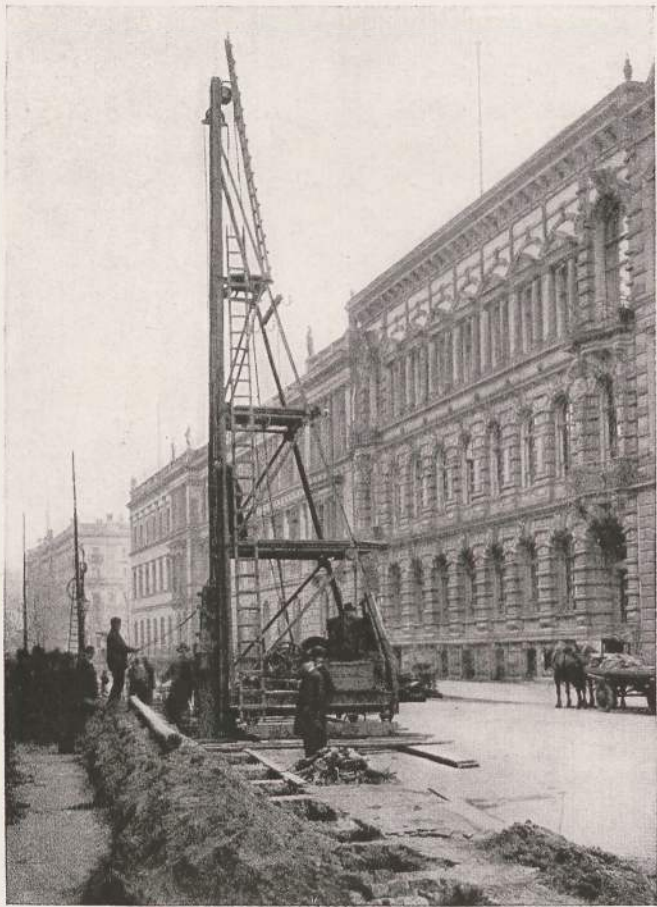
Einrammen von Doppel-T-Trägern zum Abstützen der künftigen Baugrube
