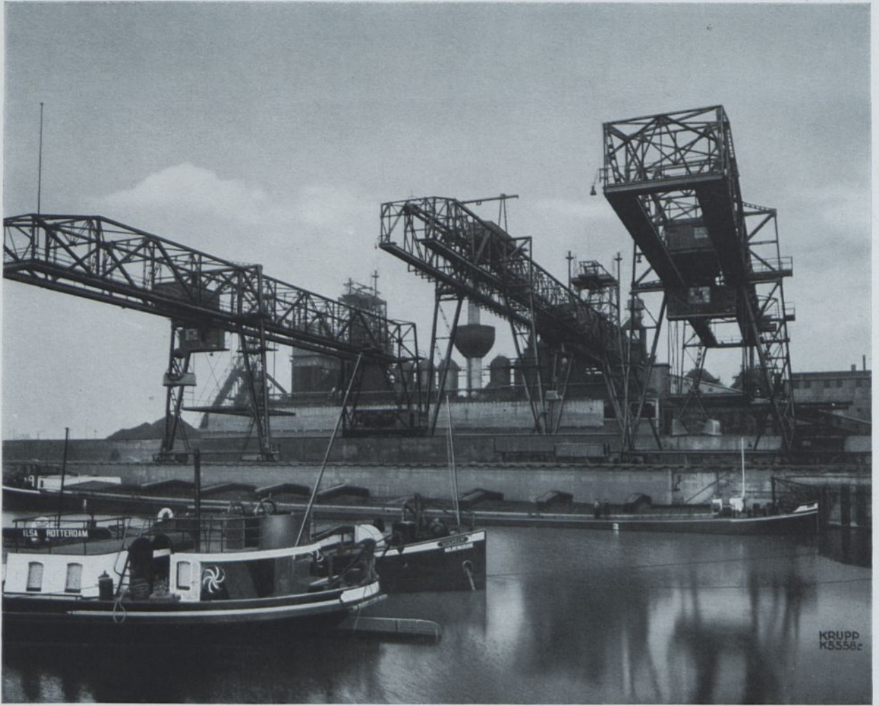
Erzentladung am Hochofenwerk Essen-Borbeck.
