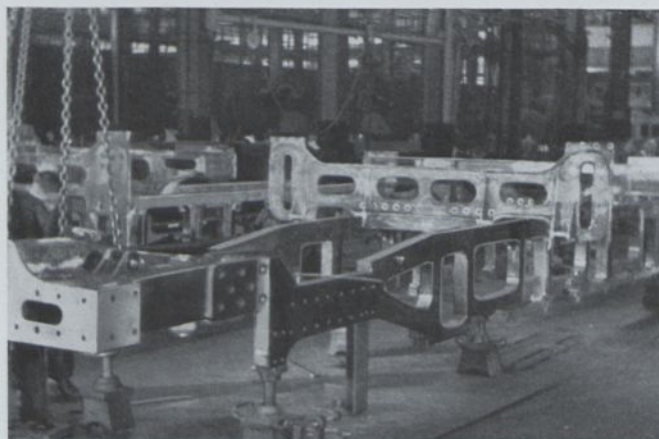
Einbau der Querträger.
