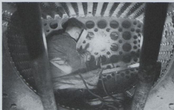
Einschweißen der Rohre in der Feuerbüchse.
