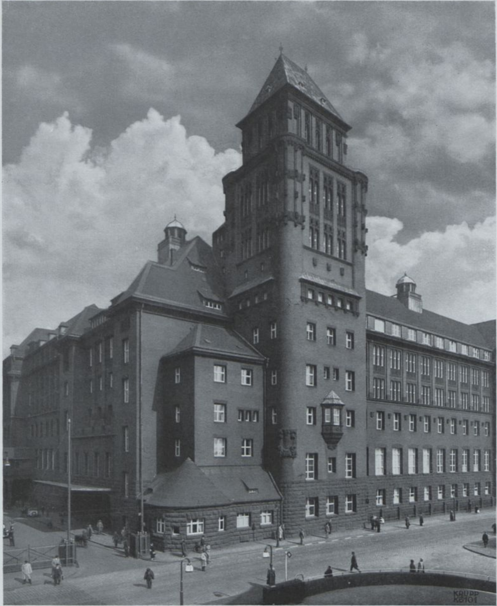
Hauptverwaltungsgebäude der Fried. Krupp A.G. in Essen.
