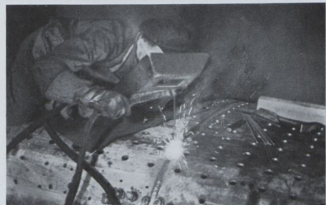
Elektrisches Schweißen eines Kessels.
