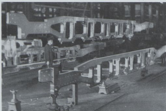
Zusammenbau der Rahmen.
