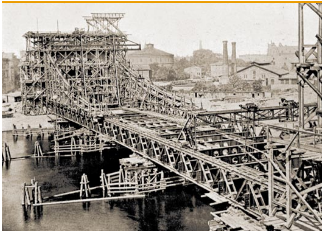
Most Cesarski w trakcie budowy, jesień 1909 r. Ilustracja z: „Die Kaiserbrücke in Breslau”, s. 41. Zbiory Specjalne Biblioteki Uniwersytetu Wrocławskiego, sygn. GŚL 15132 III
