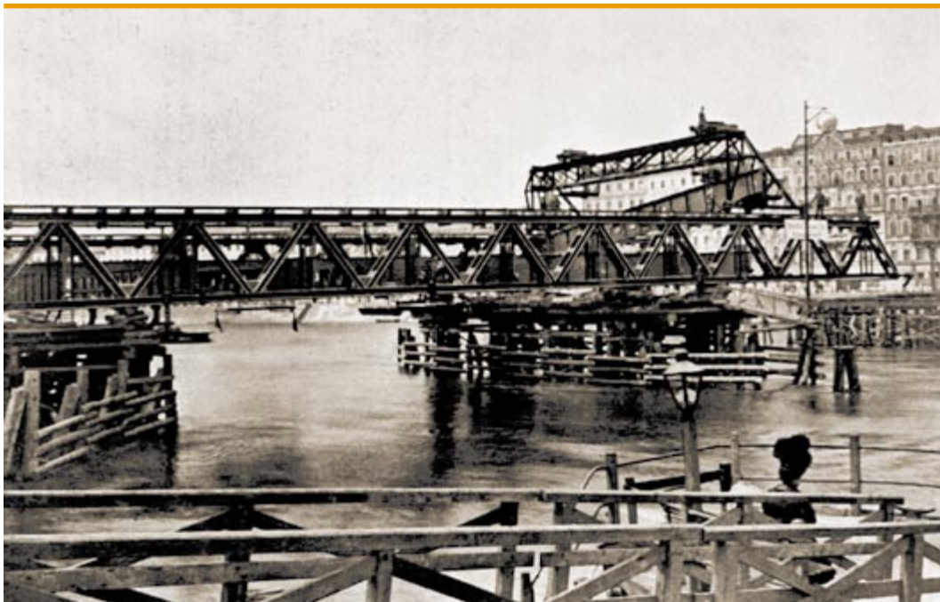
Most Cesarski we wstępnej fazie budowy na początku 1909 r. Ilustracja z: „Die Kaiserbrücke in Breslau”, s. 38. Zbiory Specjalne Biblioteki Uniwersytetu Wrocławskiego, sygn. GŚL 15132 III
