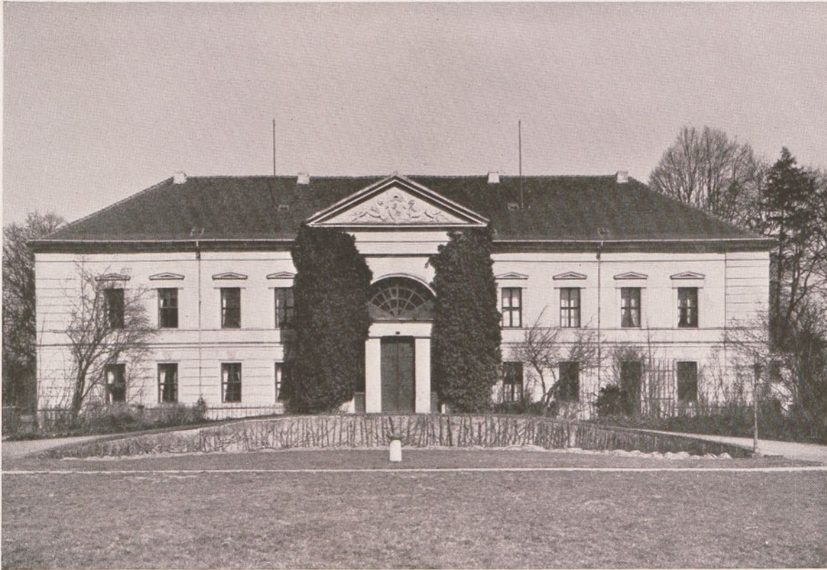
Schloß Buckow. Ausbau von Schinkel 1803
