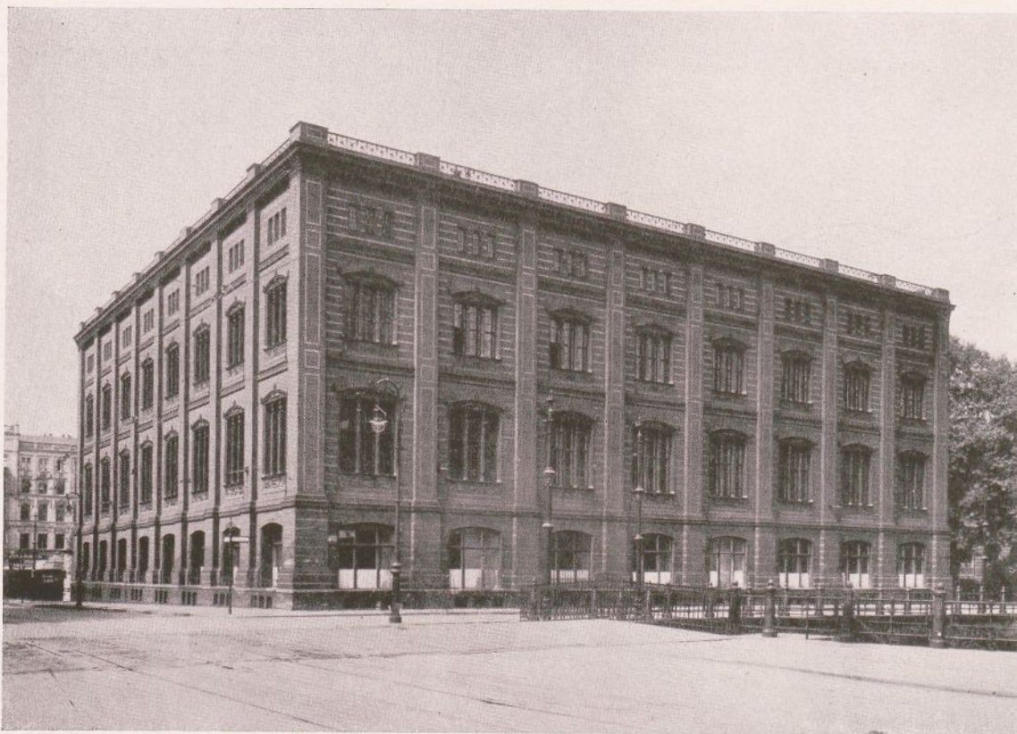
Berlin, Bauakademie von Nordosten
