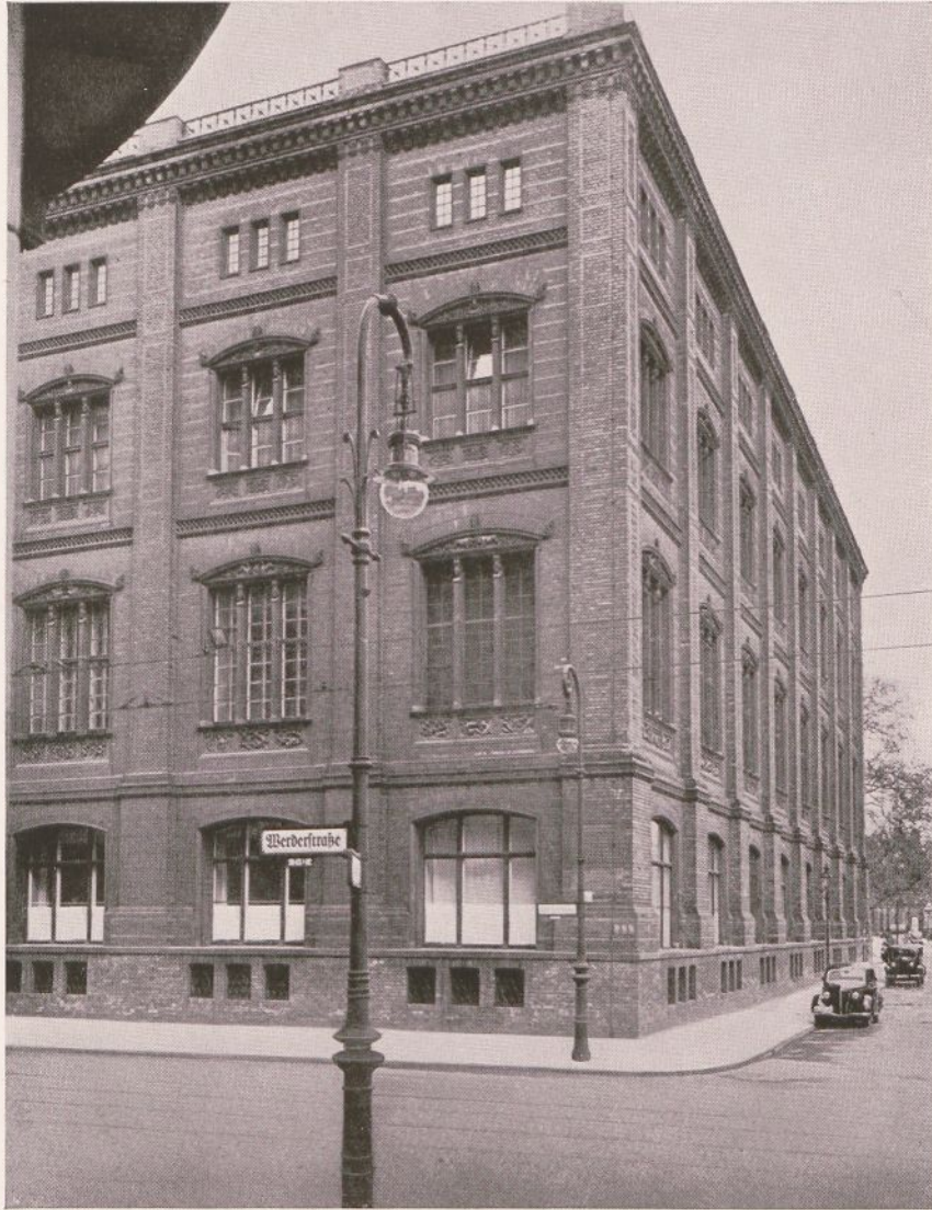
Berlin, Bauakademie. Schrägansicht in Verkürzung
