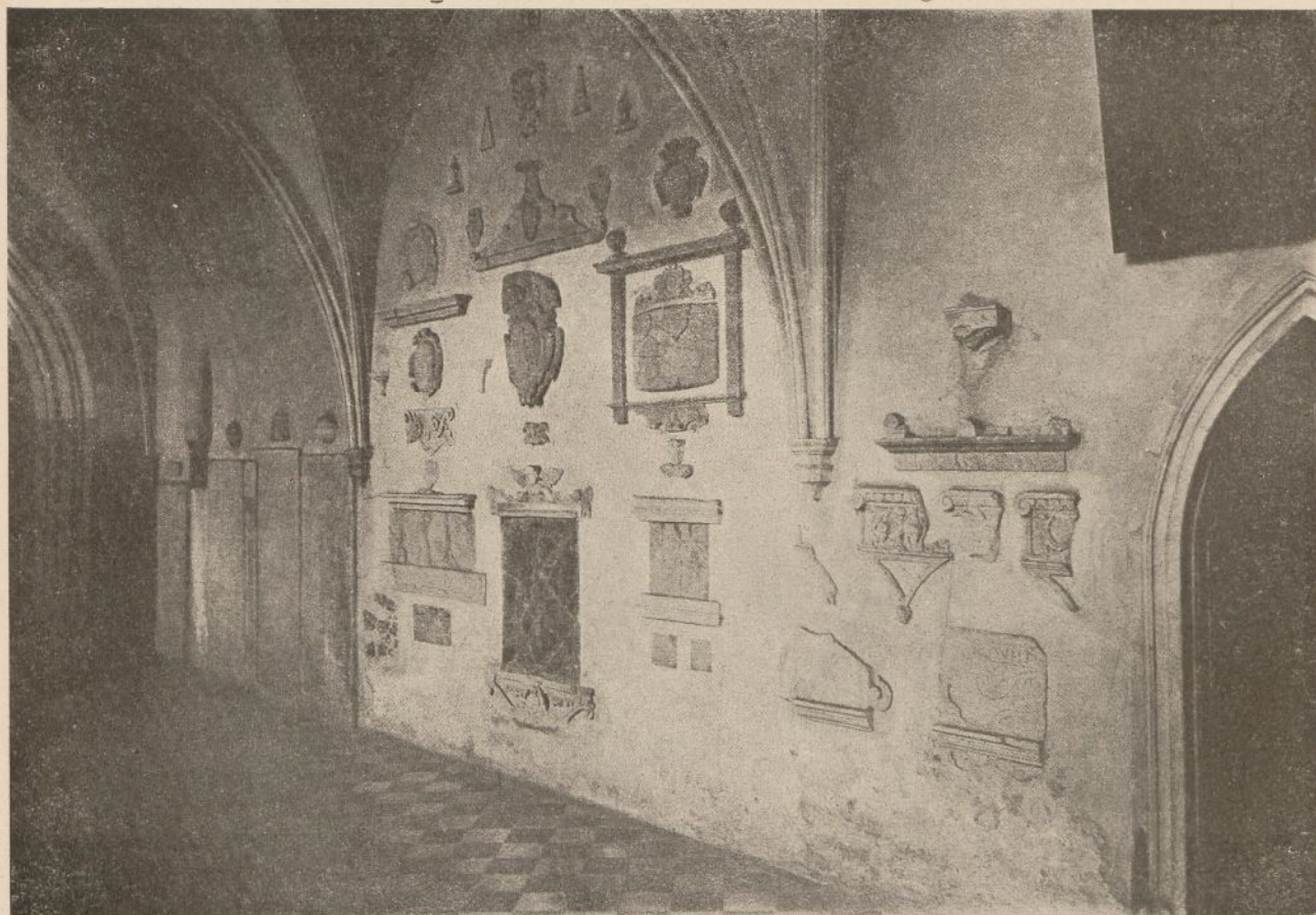
Fig. 74. Ściana południowa nowego korytarza wejścia od furty do krużganków — do str. 75. (Fot. L. Lepszy).
