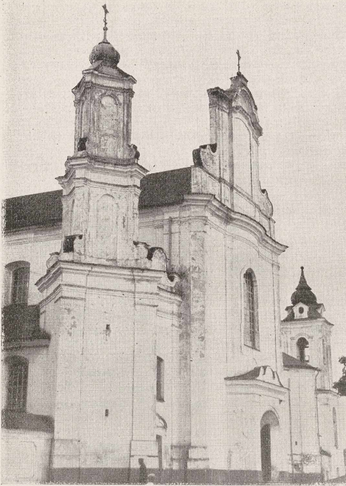
F. 17. Boruny pod Krewem. K. po-bazylijański. Wedle kontraktów z lat 1747—48 i protokloarnych pochwał z ust J.K. Claubitza, budowla ta postaw. wedle „abrysów i inwencji p. architekty Aleksandra Osikiewicza” autora także innych budowli. Fot. M. Morelowski.
