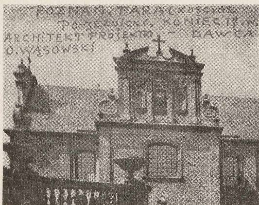
F. 39. POZNAŃ. Fara skończona na przełomie 17 i 18 w. „wedle rysowanego wzoru” O. B. Wąsowskiego S. J. architektki. Por. członkowanie i ozdobne woluty po bokach szczytu w sztuce wileńskiej 18 w. jak f. 40. Podobne, na szczytach k. św. Katarzyny, architektki J. K. Glaubitza 1740—43, wzorowane na znacznie starszyc. .
