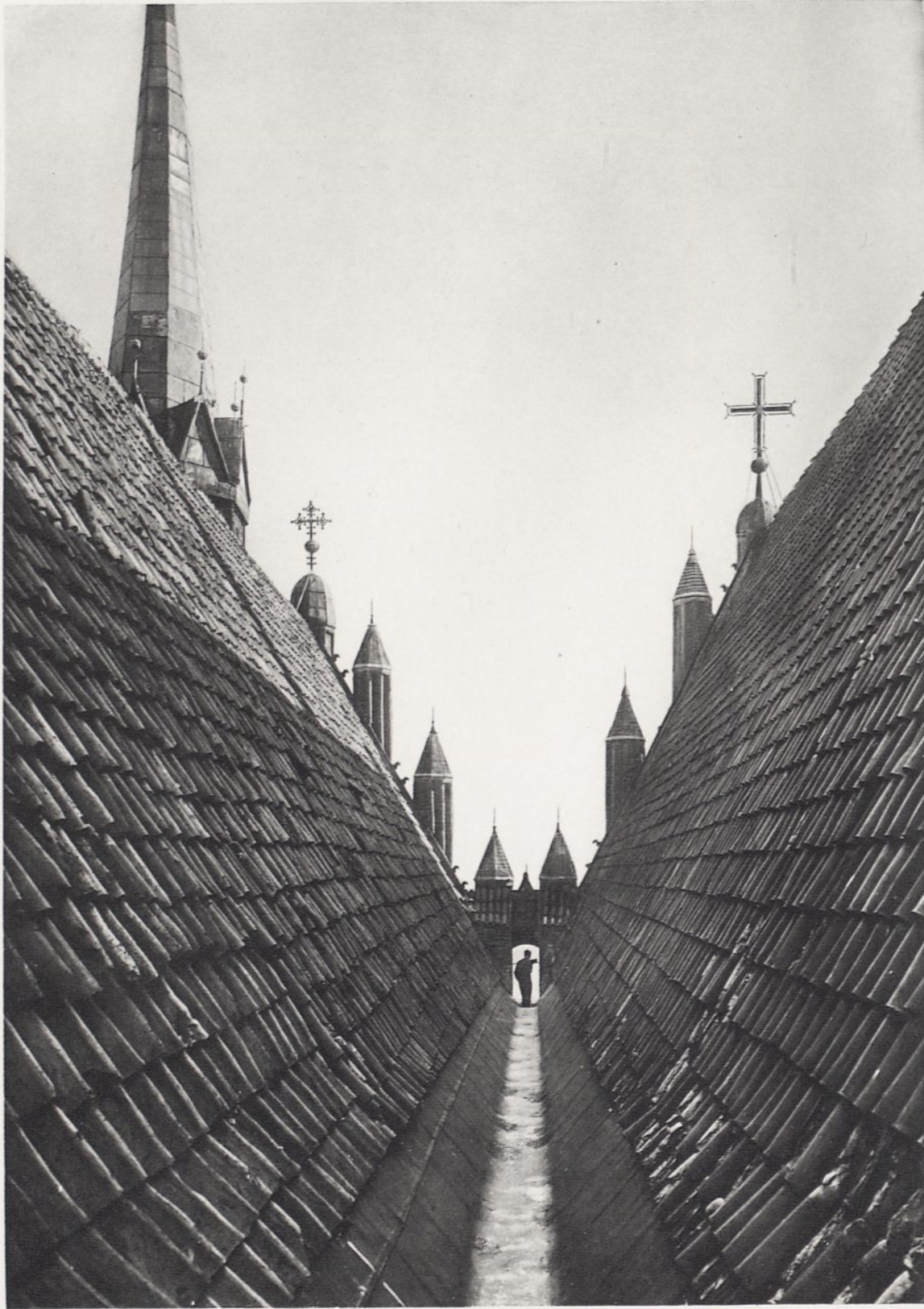
24a. Dach des nördlichen Querhauses
