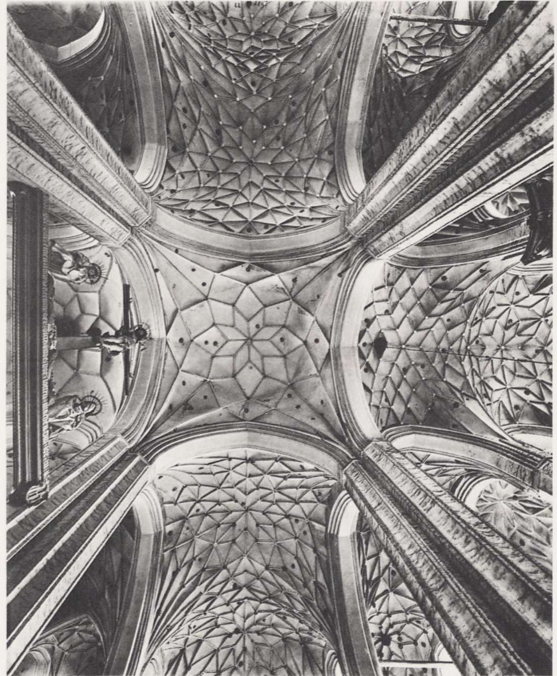
20b. Gewölbe über der Vierung
