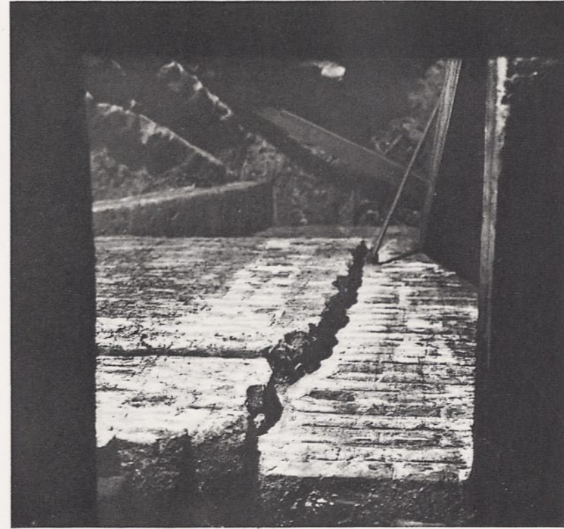
22b. Baufuge zwischen dem Mauerwerk der Basilika und des Hallenchores
