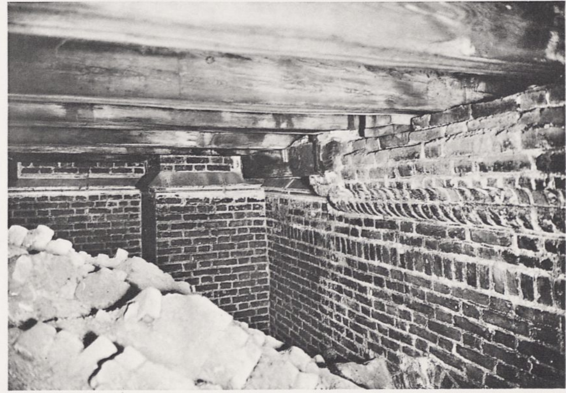
22d. Anschluß der Außenwand der Basilika an den Glockenturm
