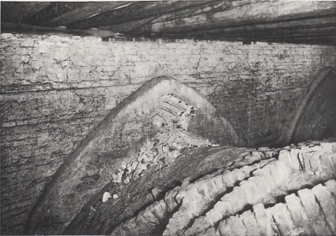
21c. Schilbbogen und Fensteröffnung an der Innenwand der Basilika über dem Mittelschiff
