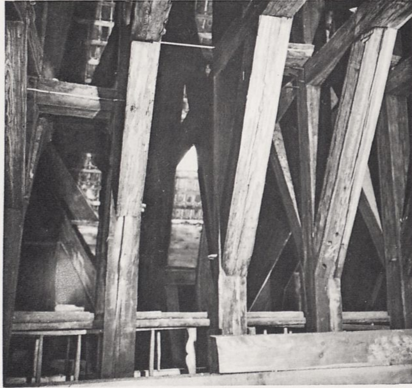
22a. Baufuge zwischen dem Dachwerk der Basilika und des Hallenchores
