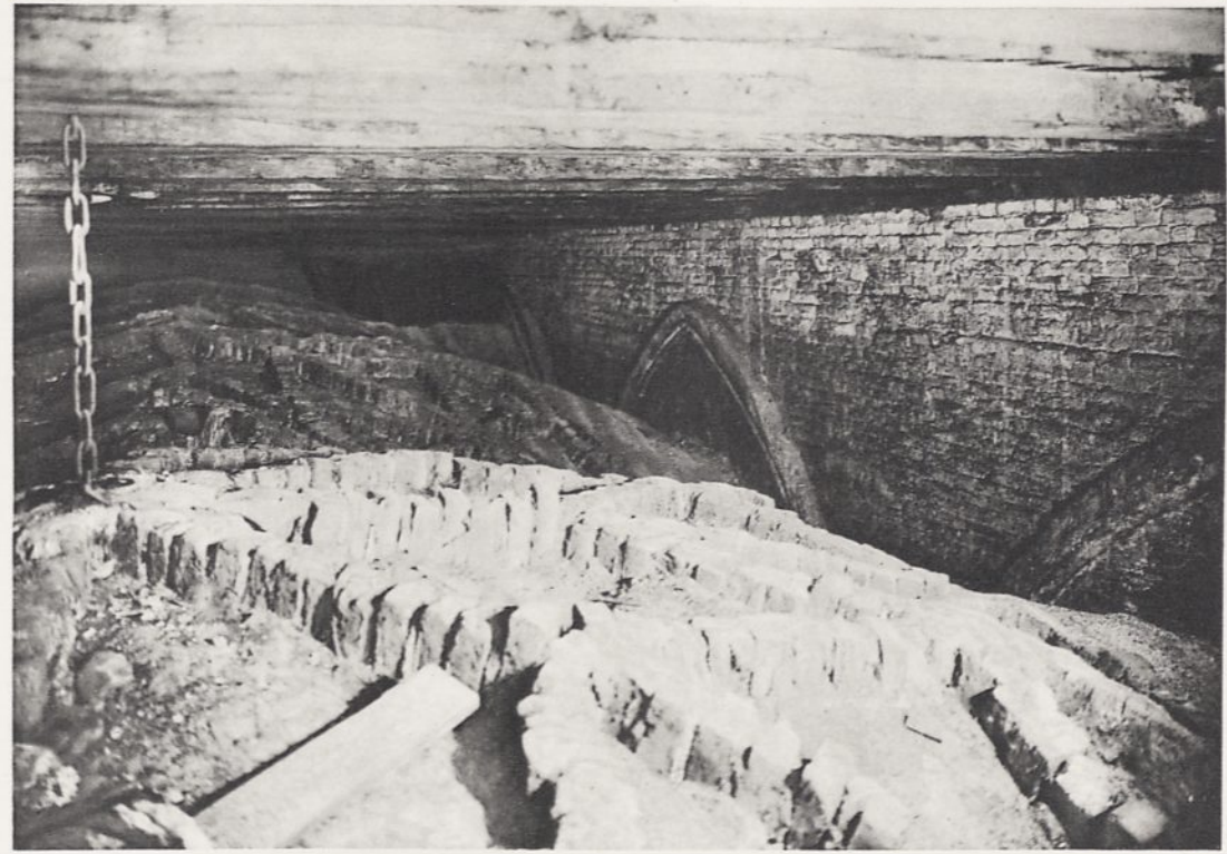
21b. Gewölbe des Mittelschiffs und Schilbbogen an der Innenwand der Basilika
