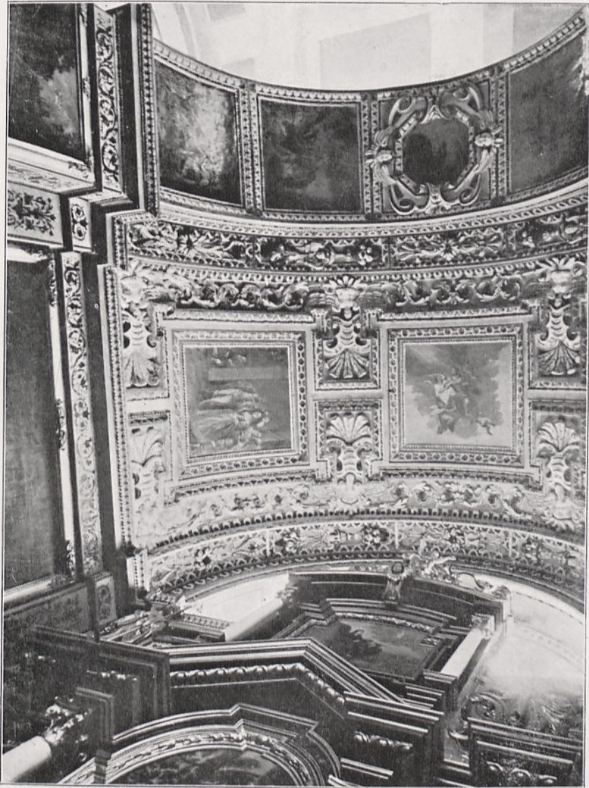
Fig. 26. Sklepienie kaplicy św. Jana Chrzc. w kościele na Bielanych pod Krakowem, z malowaniami Jana Proszowskiego (do str. 163).
