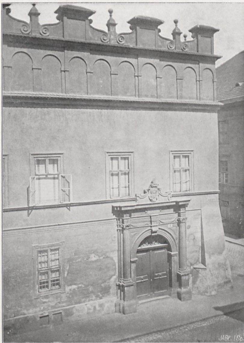
Fig. 12. Widok fasady Prałatówki N. P. M. w Krakowie, od strony kościoła Maryackiego (do str. 87).
