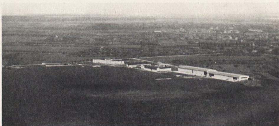
Abb. 1. Luftbild des Flughafens Braunschweig.
