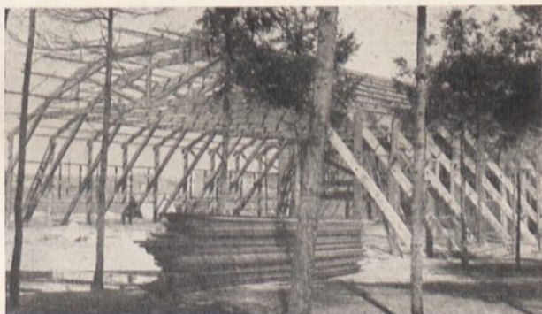
Abb. 7. Montage einer Holzhalle am Flugplatz Lublin.
