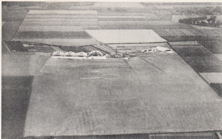
Abb. 47. Gesamtansicht des See Sport flughafens Heston-Air-Park bei London.
