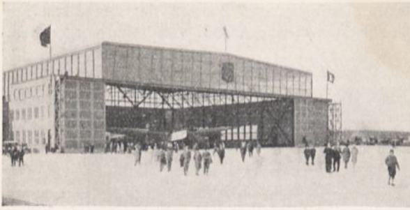
Abb. 8. Flugzeughalle in Travemünde mit großer betonierter Plattform.
