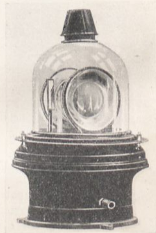
Abb. 17. Drehlinseleuchte DL 50 Lichtstärke 150 000 HK.
