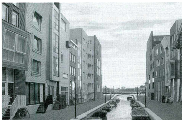
Ryc. 14. Java , Amsterdam – ulica poprzeczna z kanałem Fig. 14. Java , Amsterdam – transverse road with a canal
