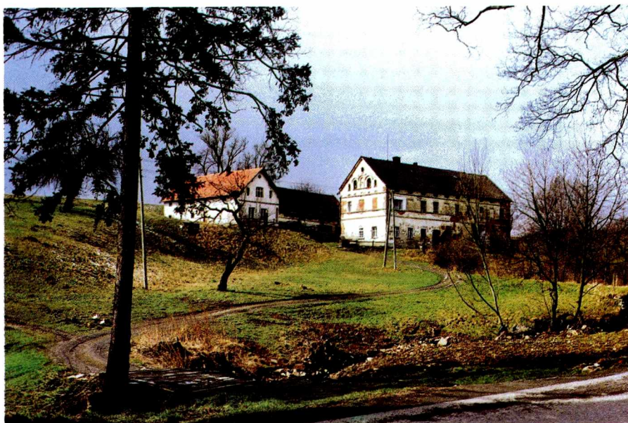
Ryc. 3. Wojbórz, zabudowa mieszkalno-zagrodowa
