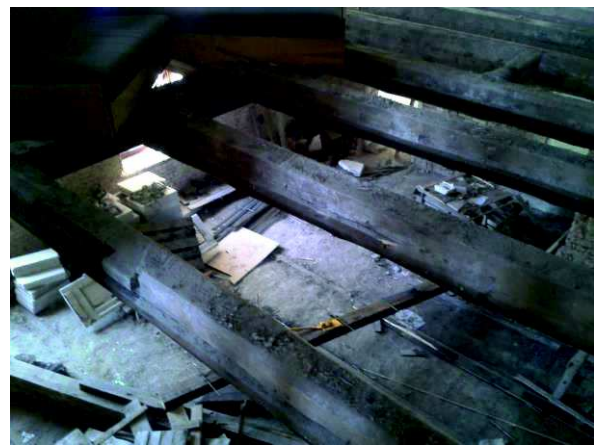
Rys. 5.4 Widok rozstawu belek stropowych pomieszczenia z którego spadł poszkodowany (16224-5303-K061-Pt/12)
