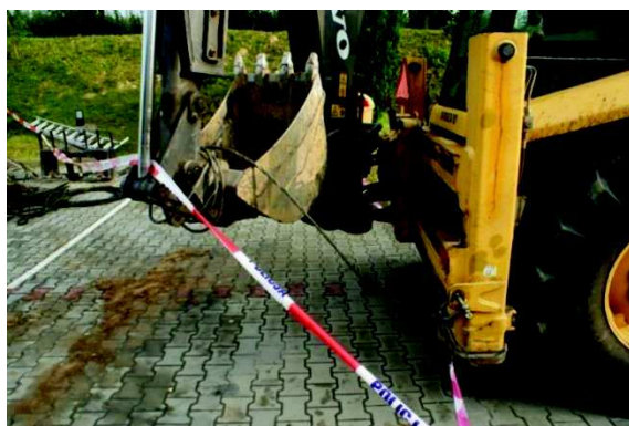
Rys. 6.12 Koparko-ładowarka wykorzystywana do wyburzenia ścian z przywiązaną do jej ramy liną stalową (Protokół Kontroli 08062-5303-K031-Pt/11)
