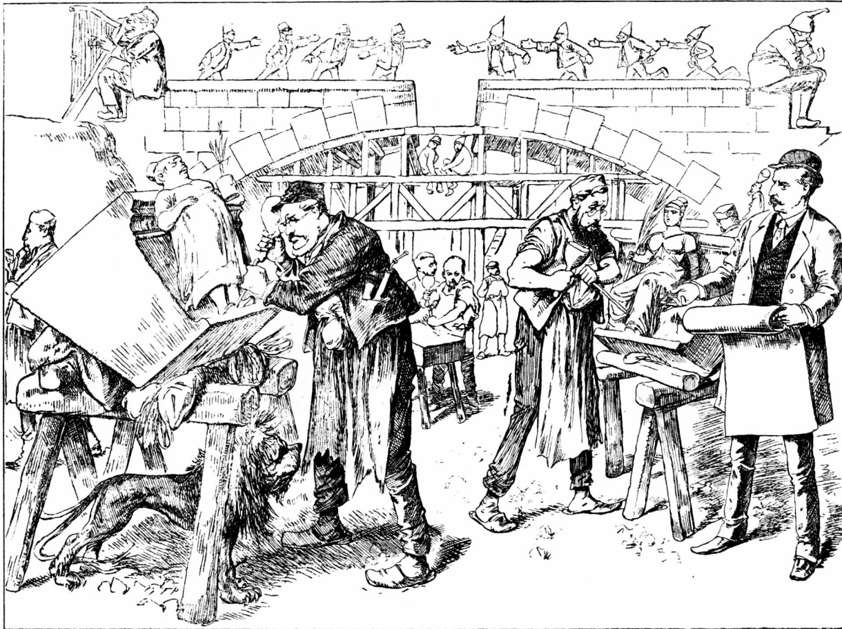
Abb. 100. E. Juch: Der Bau der Ausgleichsbrücke. Wiener „Figaro“, 1890.
