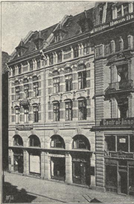
Façade des Hauses Seestern-Pauly, Friedensstr. 4.
