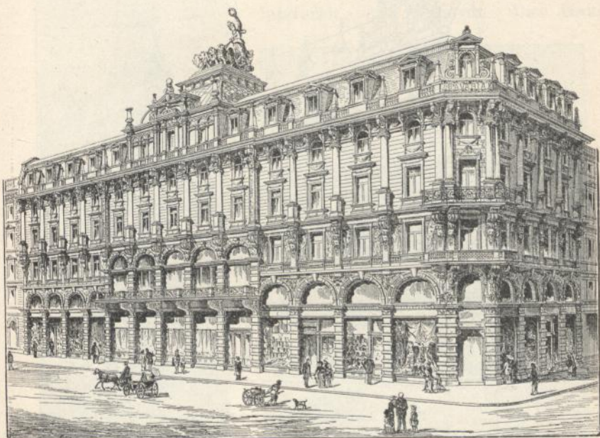
Wohn- und Geschäftshaus zur „Bavaria“: Façade.
