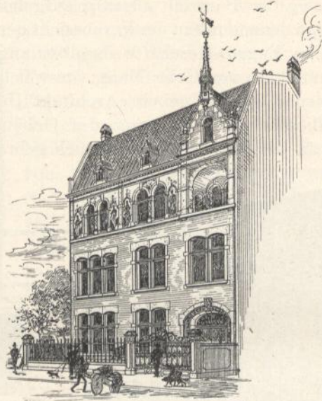
Façade des Hauses Maubach.
