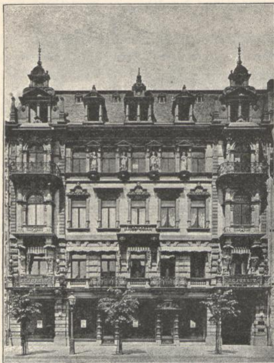
Façade des Hauses Jureit (Rossmarkt).
