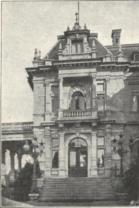
Façaden-Detail des Gesellschaftshauses,
