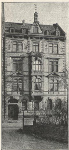
Façade des Hauses Grüder.
