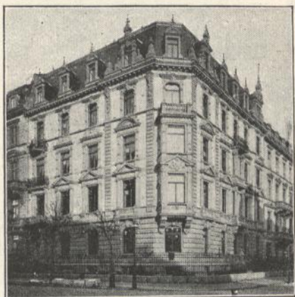
Façade des Hauses Schnatter.
