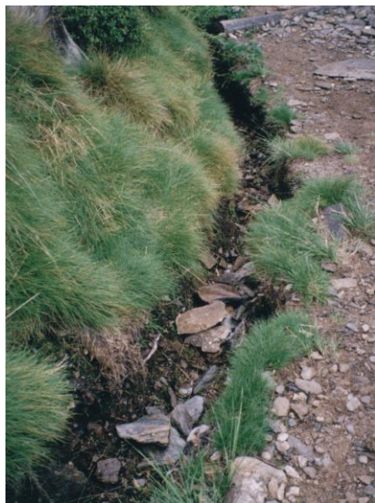
A) Rów wykopany i nieumocniony.
