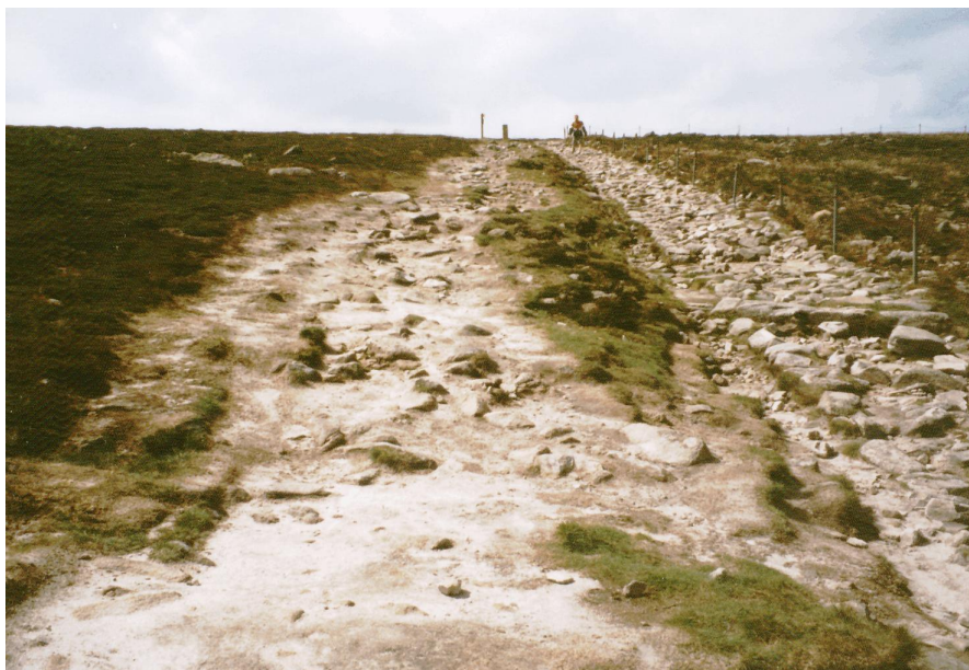
Ryc. 24. Powierzchnie degradacyjne oraz małe bruzdy erozyjne w strefie pobocza lewego na czerwonym szlaku turystycznym (Droga Przyjaźni Polsko-Czeskiej) – odcinek badawczy C4.
