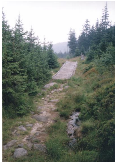
B) Rów wykopany i częściowo zarośnięty.
