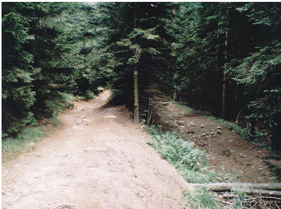
Ryc. 38. Podwójny tor szlaku Droga Bronka Czecha, odcinek B2 (oznaczenie szlaku turystycznego dotyczy strony prawej, rzadko wykorzystywanej przez turystów, ze względu na duże zniszczenie nawierzchni lub przebiegającą fragmentarycznie rynnę erozyjną).
