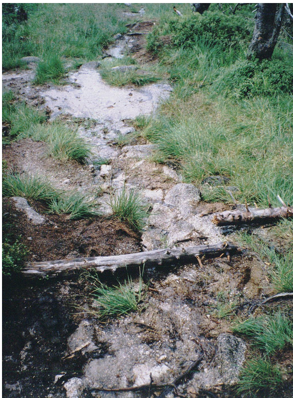
Ryc. 33. Degradacja nawierzchni szlaku Koralowa Ścieżka (odcinek J8): lokalne przegłębienia wypełnione wodą, formy akumulacyjne, „oczka błotne”, ślady spłukiwania powierzchniowego.
