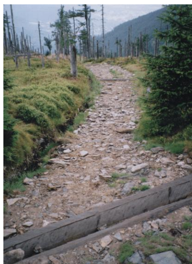
A) Przepust drewniany
