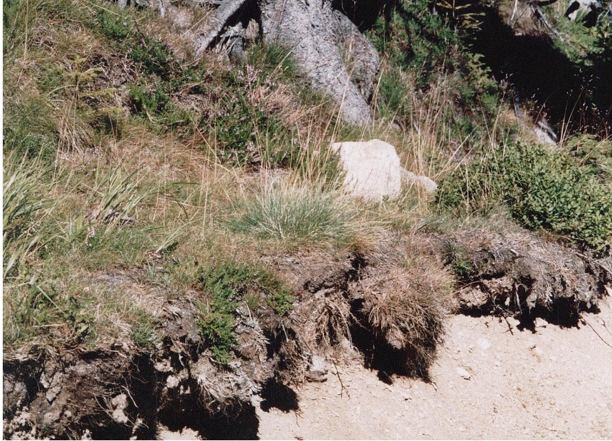
Ryc. 42. Nisze degradacyjne, będące efektem działania lodu włóknistego (Droga Bronka Czecha, odcinek B5).
