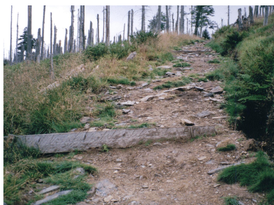
B) Umocowany w podłożu płaski próg przeciwieryzyjny.
