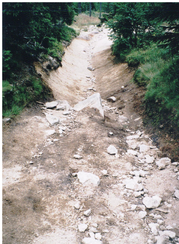
Ryc. 40. Duża (gł. 80-90 cm, szer. zmienna do 300 cm) bruzda erozyjna na nieformalnej części szlaku (Droga Bronka Czecha, odcinek B3).
