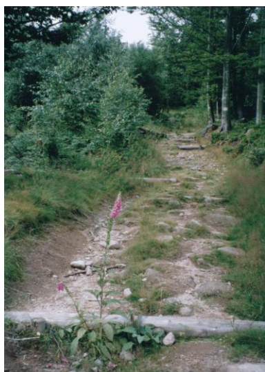
A) Umocowany w podłożu okrągły próg przeciwieryzyjny.
