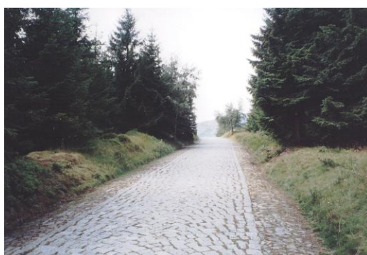
C) Wyraźne kontury strefy szlaku i poboczy stworzone dzięki specjalnemu ułożeniu kostki granitowej, a także przegłębieniu szlaku (utworzeniu skarpy).
