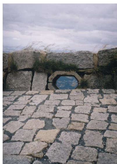
D) Przepust betonowy
