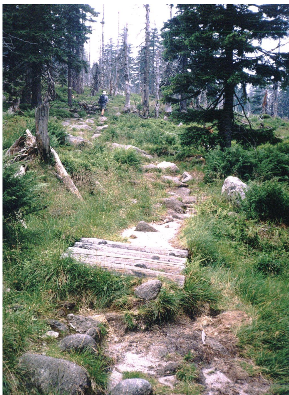
Ryc. 28. Degradacja szlaku Ścieżka nad Regłami (odcinek Z7): formy erozji wstecznej oraz małe powierzchnie degradacyjne.
