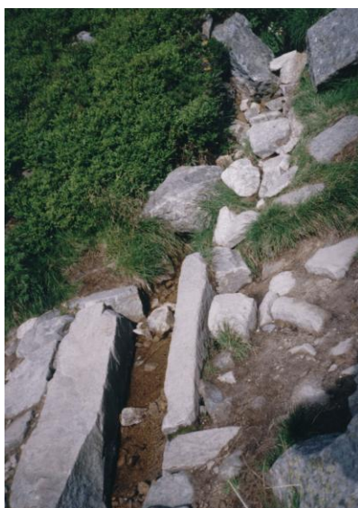
C) Przepust kamienny
