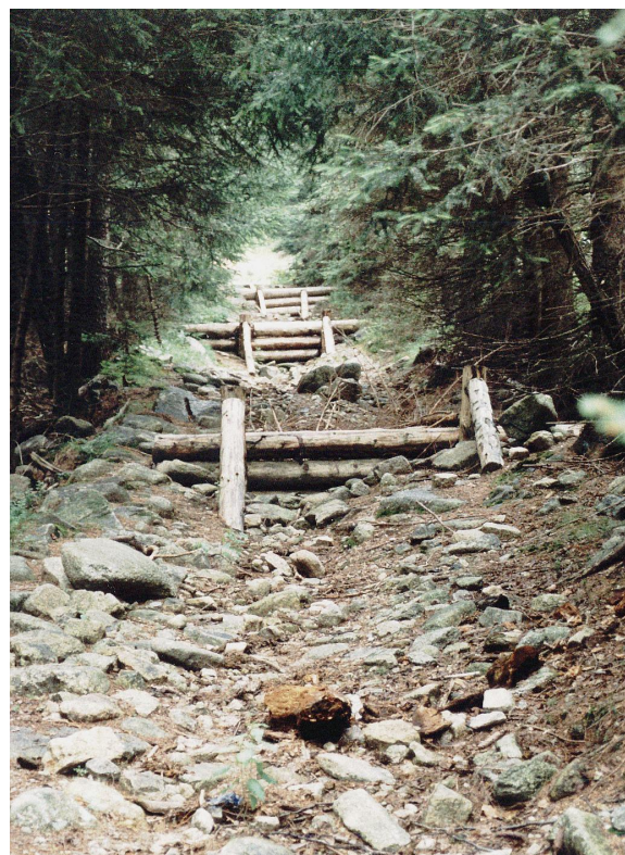
Ryc. 36. Urządzenia przeciwoerozyjne w rynnach erozyjnych na Drodze Bronka Czecha, odcinek B3.
