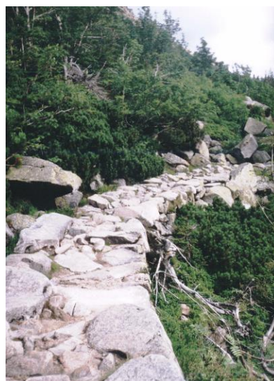
B) Wyraźne kontury nawierzchni ułożone z głazów i bloków skalnych.
