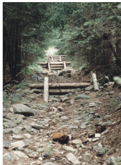
D) Wysokie, zbudowane z bali drzewnych progi przeciwieryzyjne.
