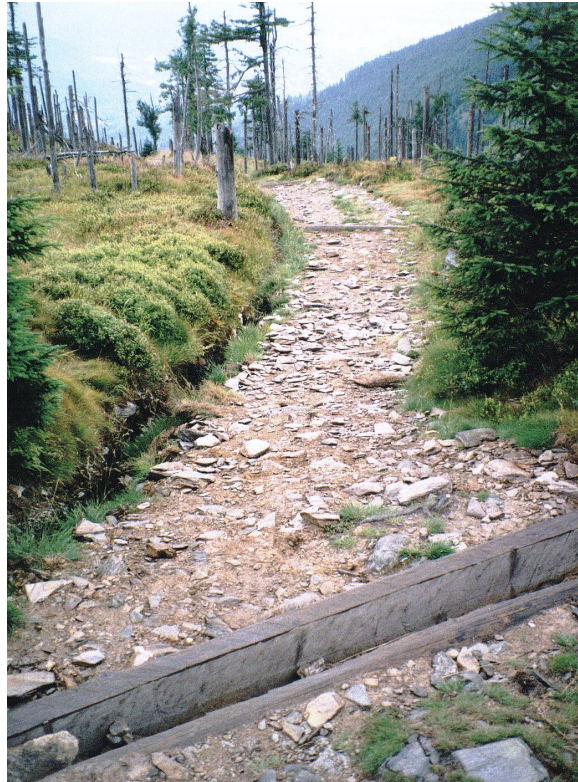
Ryc. 47. Bruk gruzowy i urządzenia przeciwozyjne (przepust powierzchniowy, rów odwadniająca) na czarnym szlaku na Sowią Przełęcz (odcinek S3).
