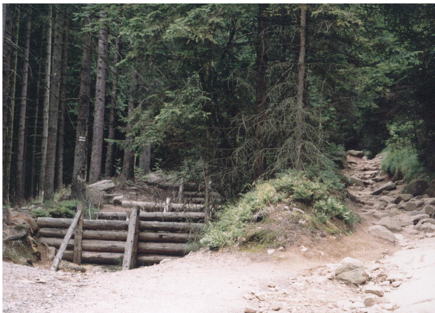
Ryc. 76. Przykłady niewłaściwego oznakowania szlaków turystycznych oraz ich dużego zniszczenia (odcinek B3, początek odcinka od strony Karpacza).
