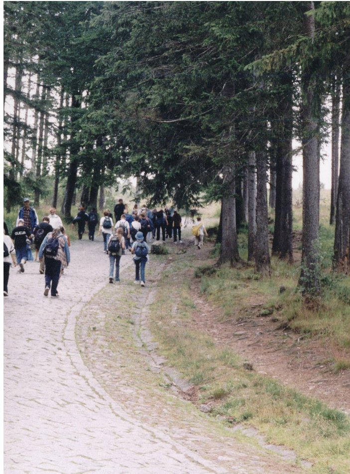
Ryc. 79. Fragment odcinka N1 z „niewygodnie” ułożoną kostką granitową, przyczyniająca się do tworzenia dzikich, równoległych ścieżek do szlaku.
