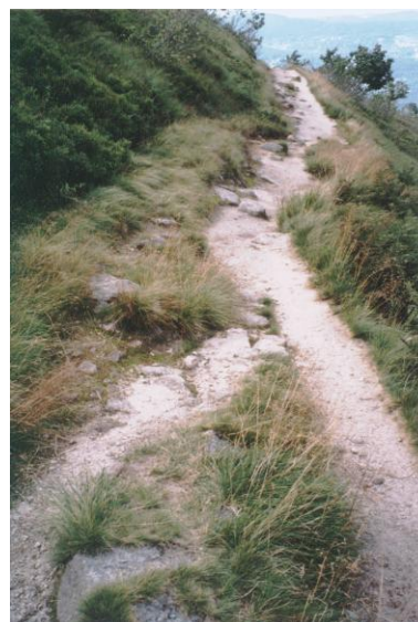
Ryc. 72. Fragment odcinka Z1, podlegający rozdeptywaniu oraz wymagający postawienia barier zabezpieczających przed utratą równowagi na stromym stoku.
