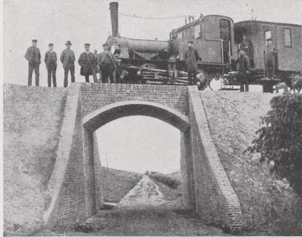
Abb. 65. Oldenburg, alte Eisenbahnbrücke.
