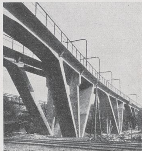
Abb. 61. Ilse-Bergbau A.-G., Kohlenhochbahn.
