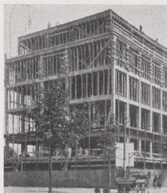
Abb. 14 und 15. Danzig, Allgemeine Ortskrankenkasse. Eisenbeton-Rohbau und Ausführung.
