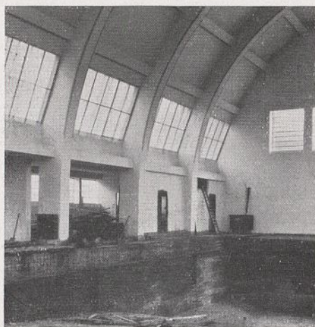
Abb. 44. Berlin, Hallenbad. Poststadion.
