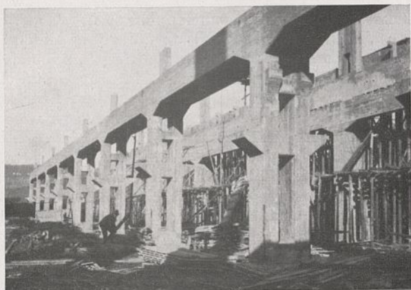
Abb. 58. Eßlingen, Lokomotivwerkstätte. Kranbahn.
