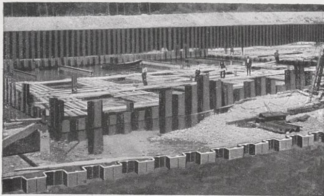
Regulierung der Iller unter Verwendung von Hoesch-Spundwandisen, Profil II und III in Bohlen bis 16 m Länge.
