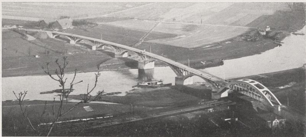
Abb. 2. Die neue Straßenbrücke bei Vlotho.
