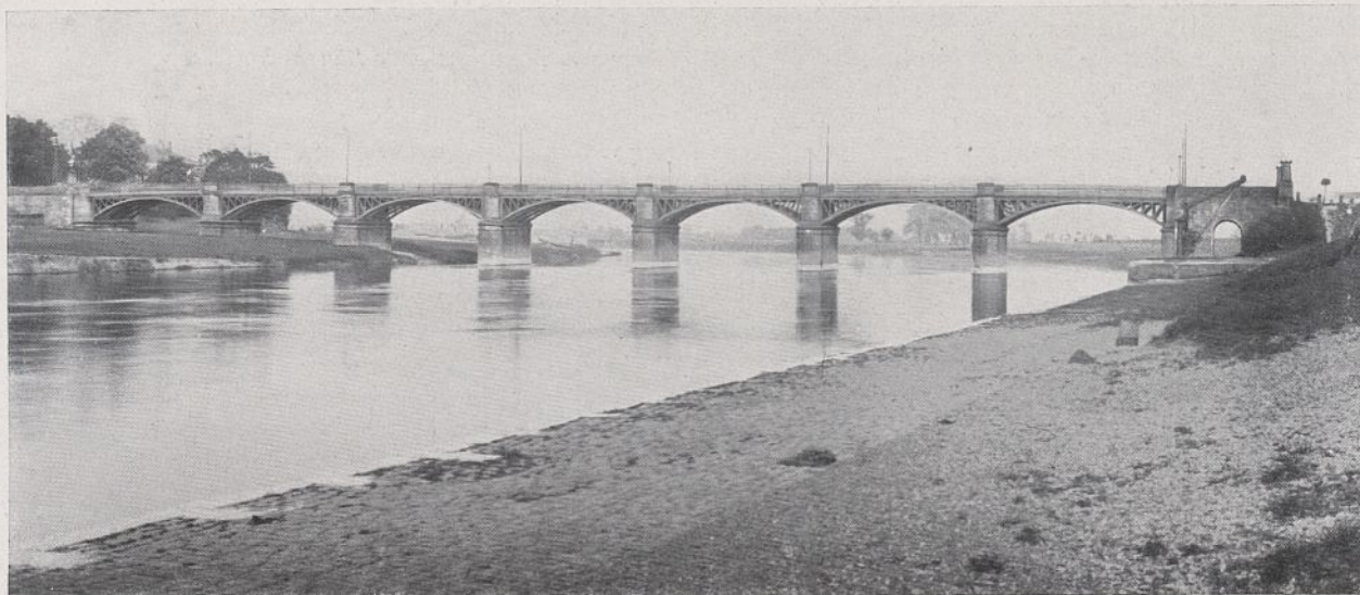
Abb. 5. Die alte Straßenbrücke bei Rinteln.
