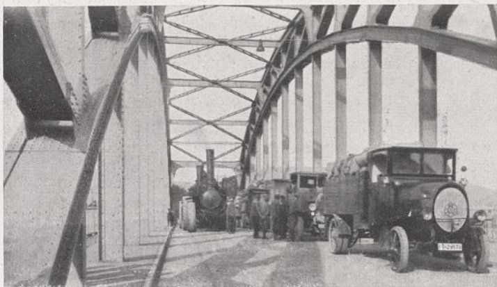
Abb. 9. Straßenbrücke bei Rinteln, Probelastung.
