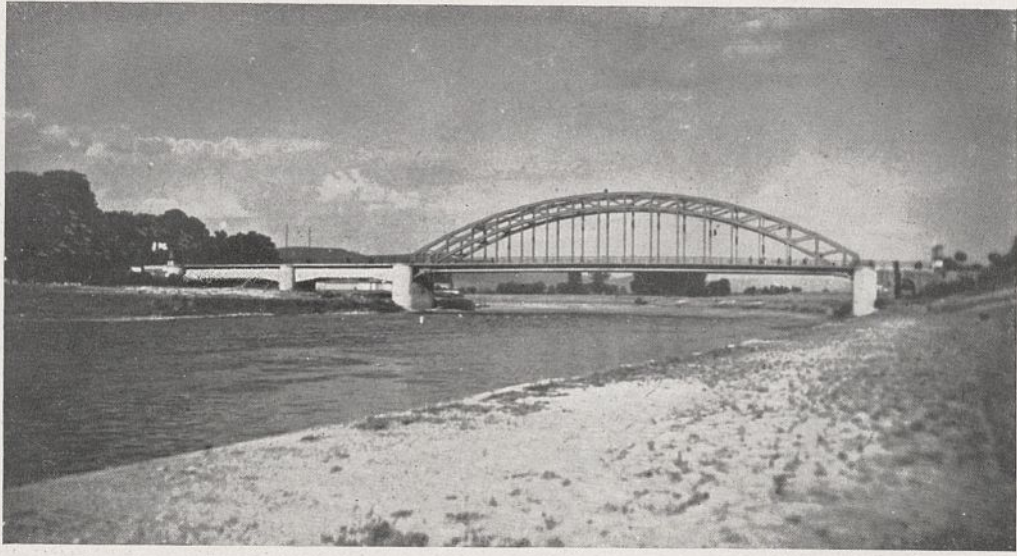
Abb. 1. Die neue Straßenbrücke bei Rinteln.
