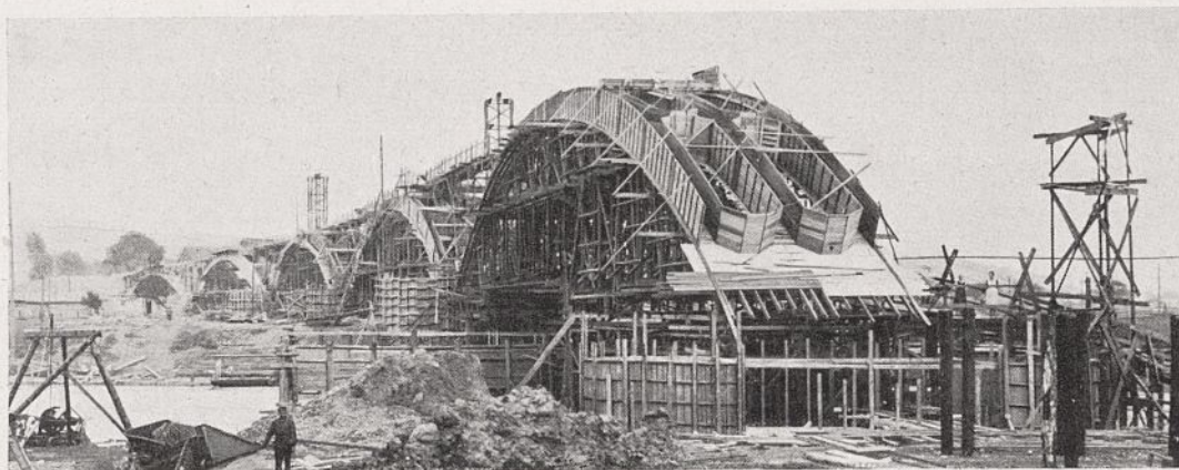
Abb. 18. Straßenbrücke bei Vlotho, Einschalung der Längsrippen.
