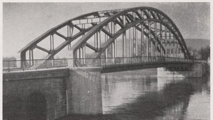
Abb. 10. Straßenbrücke bei Rinteln, Anschluß an das alte Widerlager.
