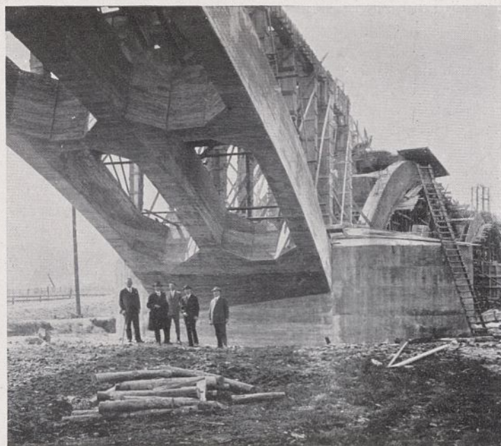
Abb. 12. Straßenbrücke bei Vlotho, letzter Zwischenpfeiler rechts mit dem Ansatz des Bogens.
