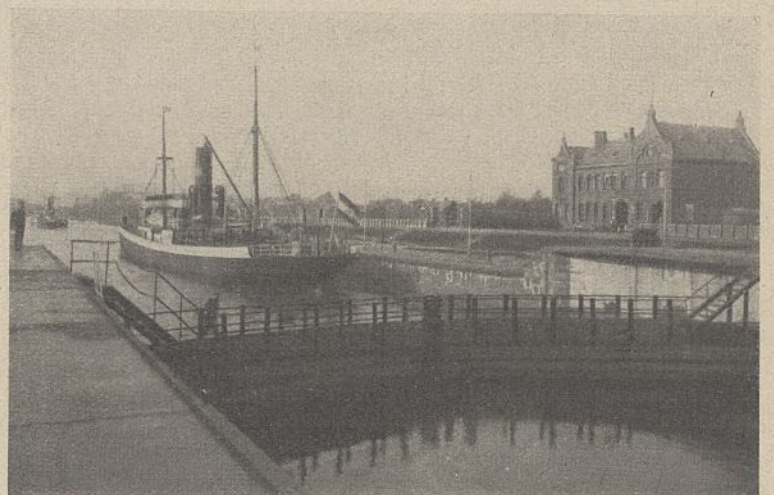
Abb. 5. Alte Nordschleuse in Holtenau. (Blick nach dem Kanal.)
