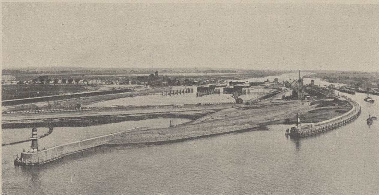
Abb. 9. Bau der Einfahrt von der Elbe zu den neuen Schleusen in Brunsbüttelkoog. (Dahinter links die fast fertigen neuen Schleusen, rechts die noch betriebenen alten Schleusen mit ihrer Einfahrt)
