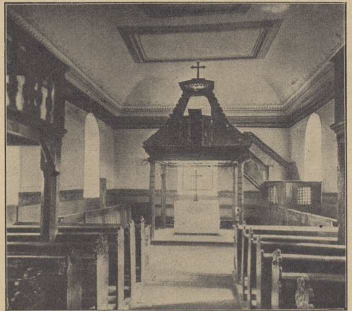
Abb. 6. Inneres der Kirche vor dem Abbruch.
