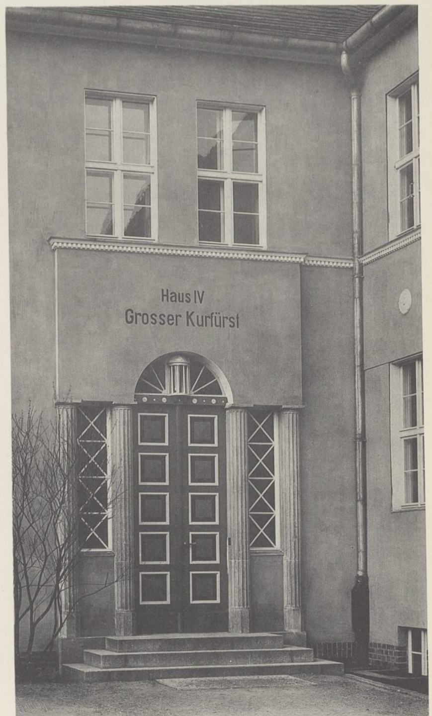
Abb. 3. Eingang zum mittleren Wohnhaus IV.
