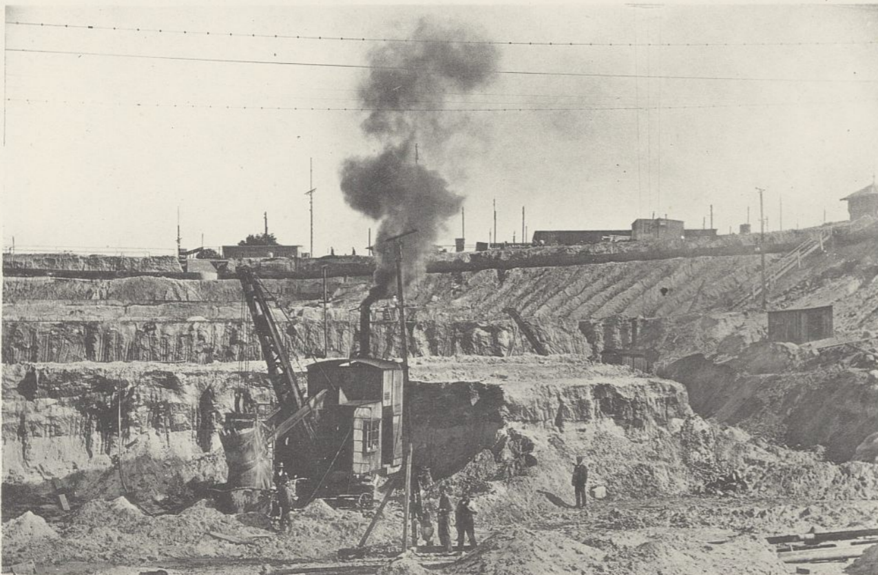
Abb. 3. Löffelbagger beim Füllen eines Kübels.
