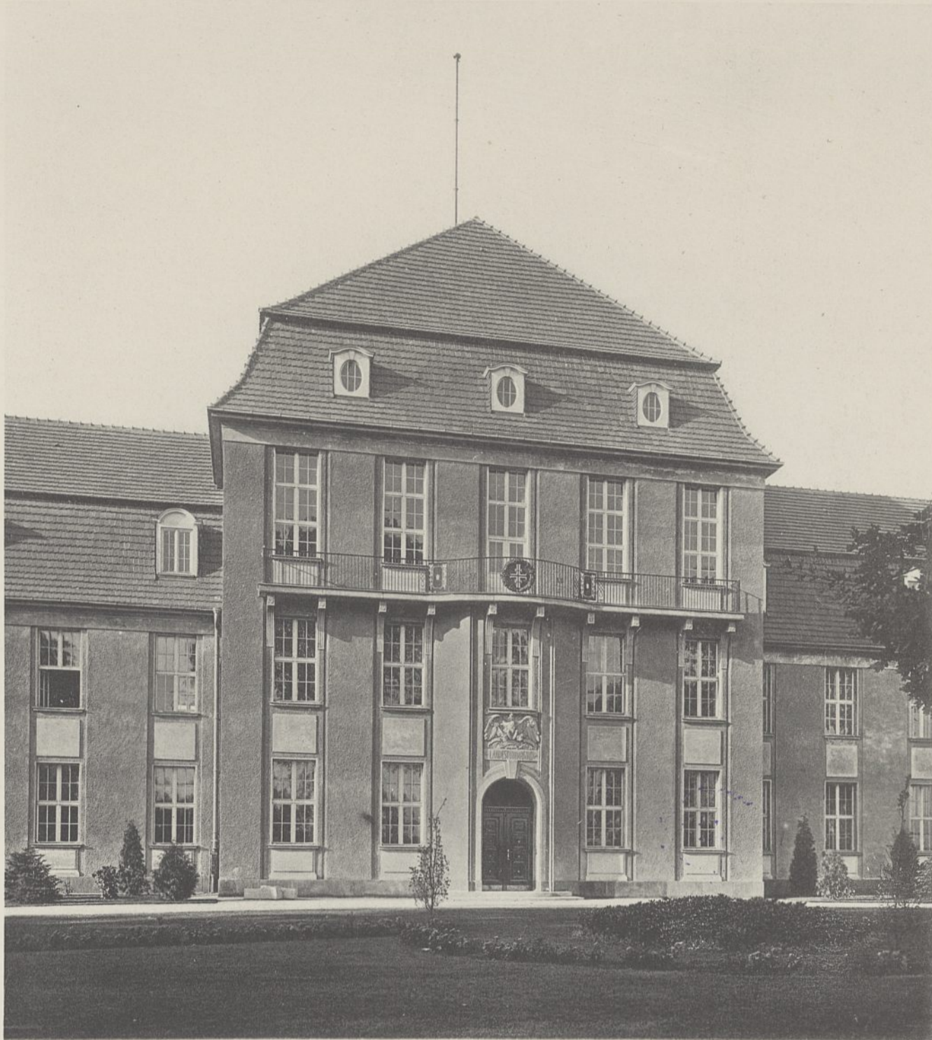
Abb. 1. Hauptansicht des Mittelbaues von Norden.
