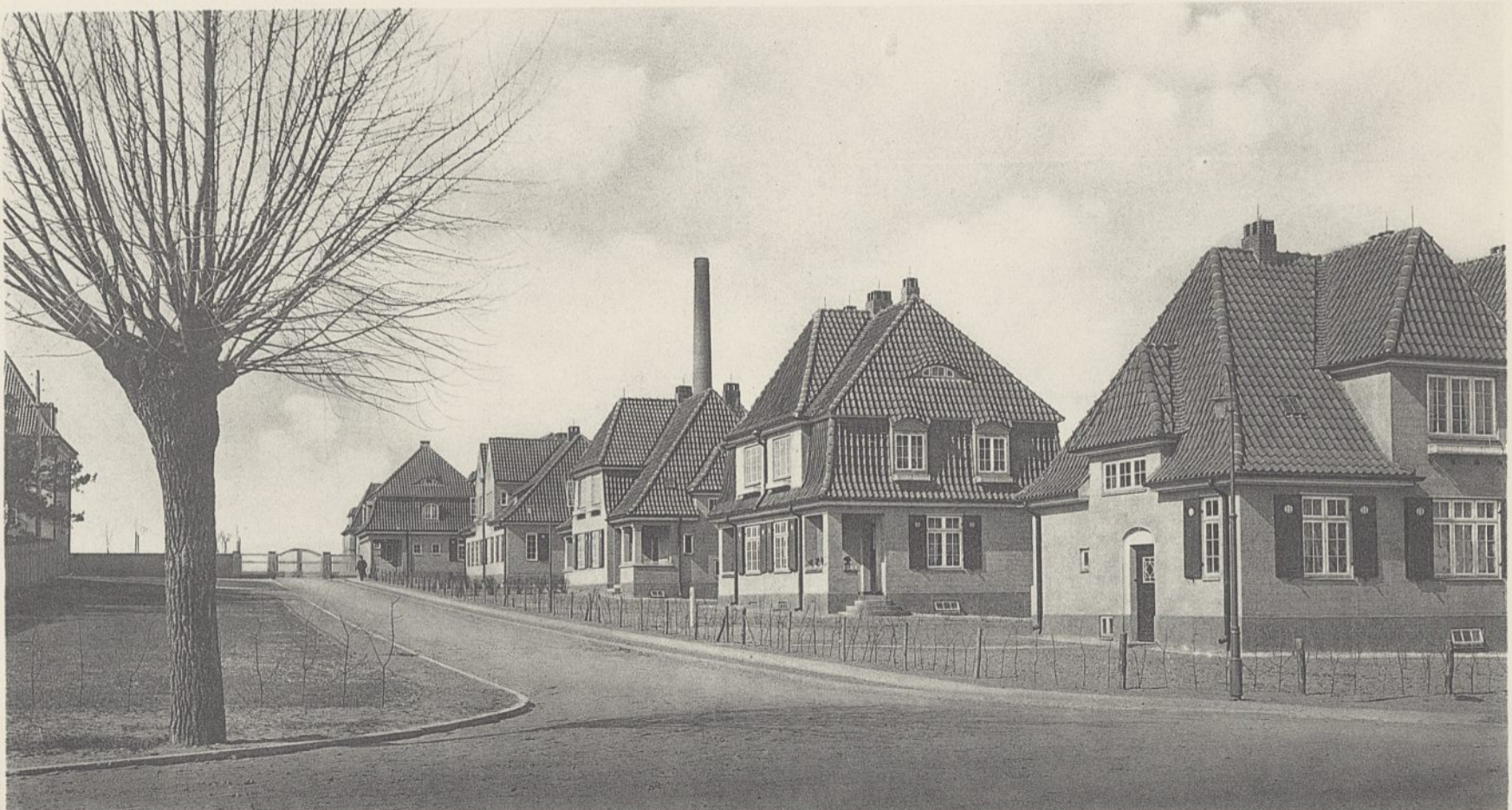
Abb. 3. Zufahrtstraße mit Pfortnerhaus, Pflegerwohnhäusern und Maschinistenhaus.
