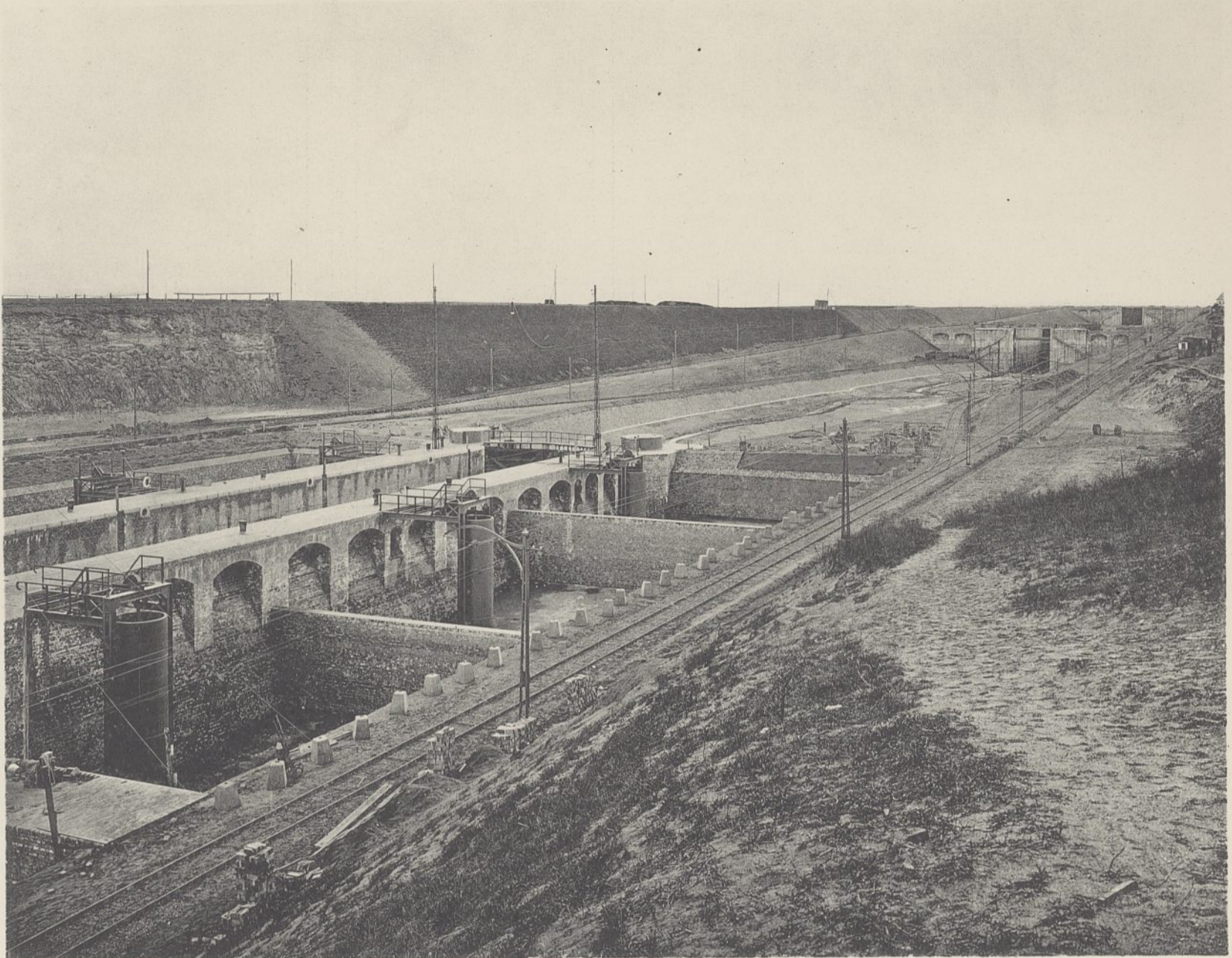
Abb. 1. Sparbecken der Schleusen bei Niederfinow.
