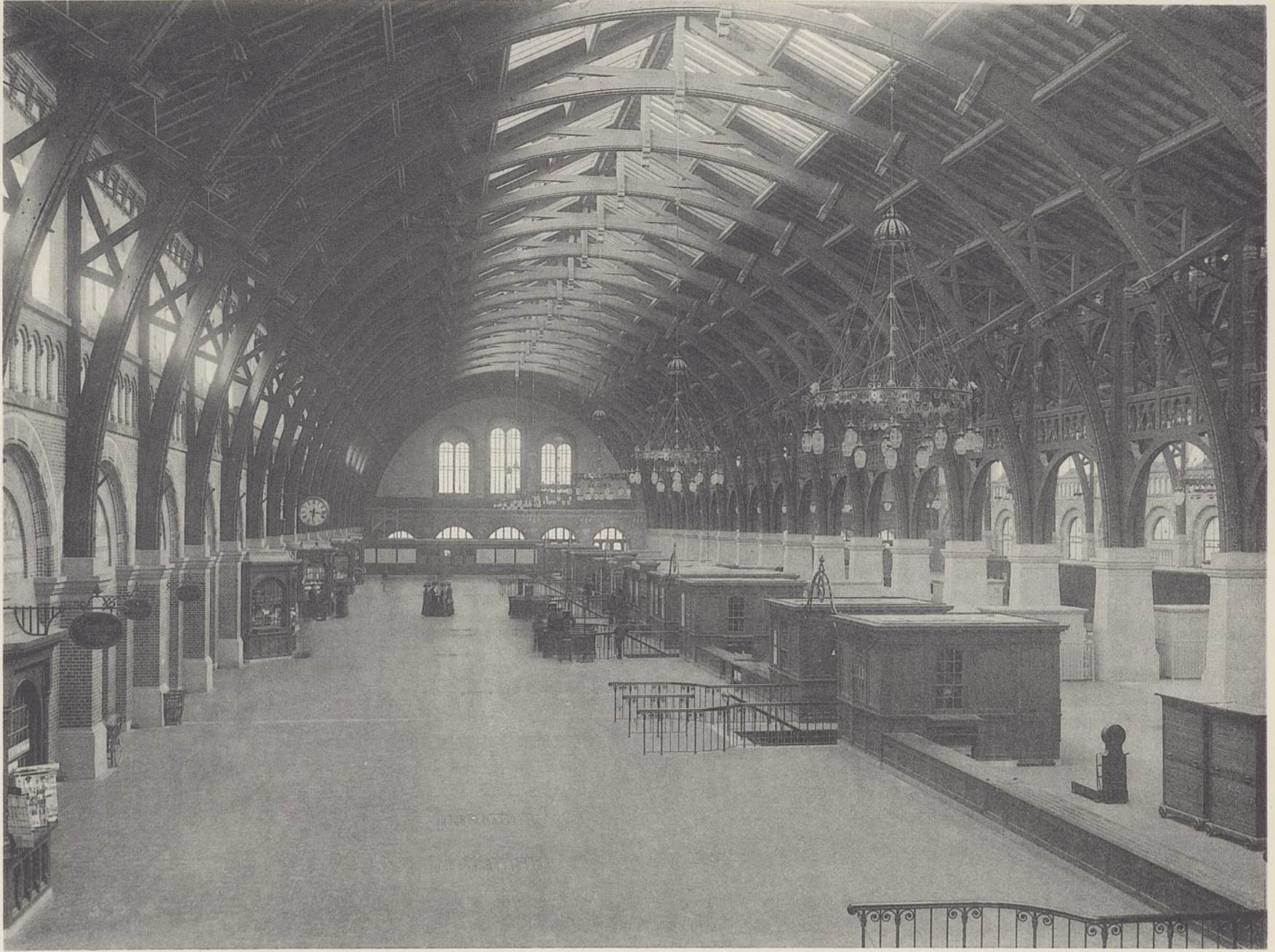
Abb. 1. Blick nach Osten in die Abgangshalle.
