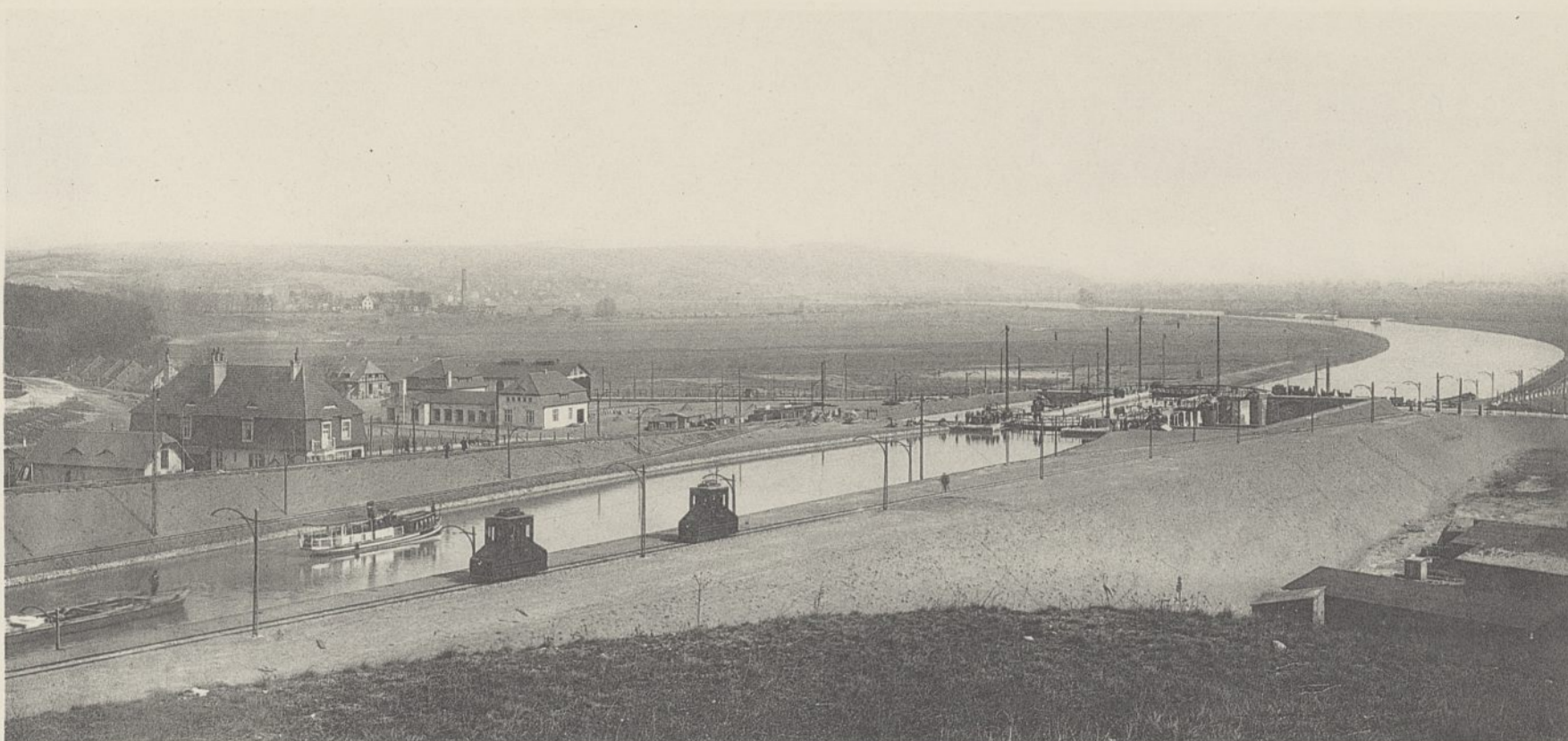
Abb. 1. Blick auf die Schleuse IV der Schleusentreppe bei Niederfinow mit Werkstattanlage.
