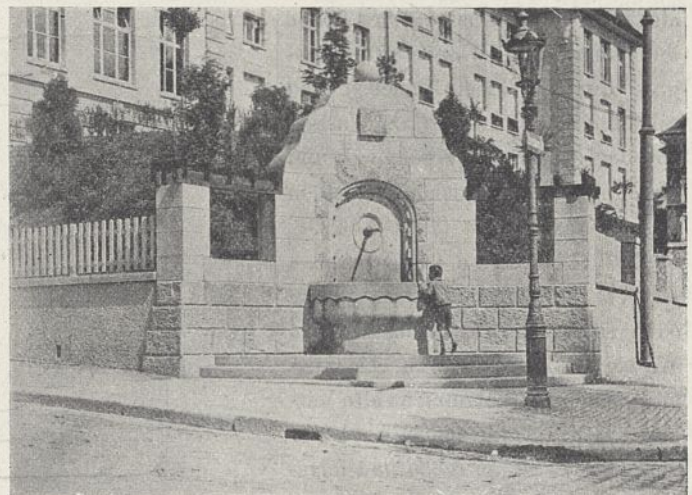
Abb. 103. Kantonschulbrunnen in Zürich.
