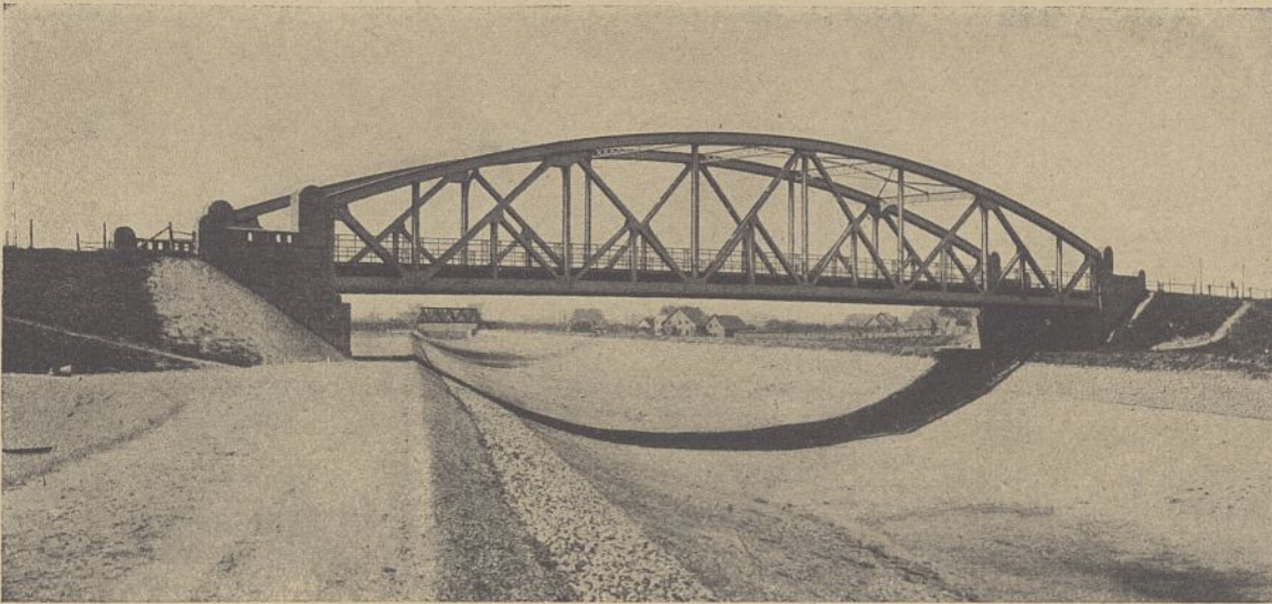
Abb. 3. Straßenbrücke über den Hauptkanal bei Lohnde. Blick nach Westen.
