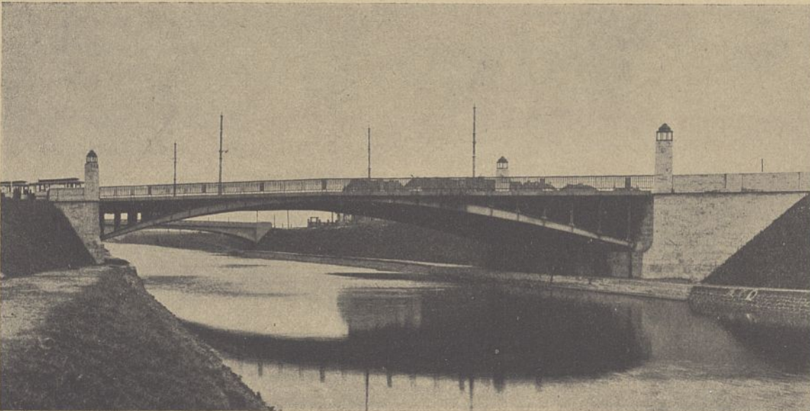
Abb. 4. Schiefe Brücke über den Hauptkanal im Zuge der Podbielskistraße.
