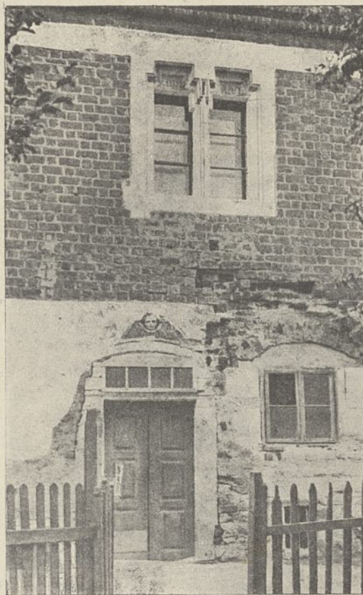
Fig. 31. Wislica. Dom Długosza, Fragment ściany południowej.
