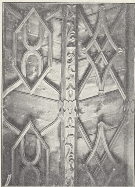
Fig. 21. Rogów. Dwór, szczegół stropu sali jadalnej.
