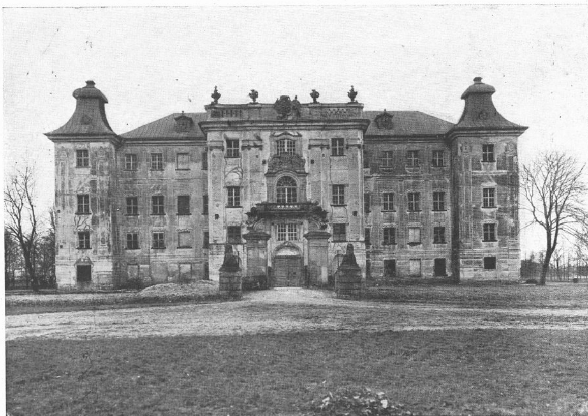
21. Rydzyna, zamek, fasada północna.
