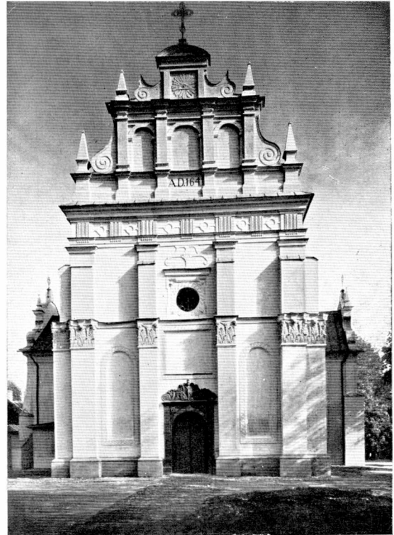
8. Radzyń, kościół parafialny pod wezwaniem św. Trójcy, fasada.
