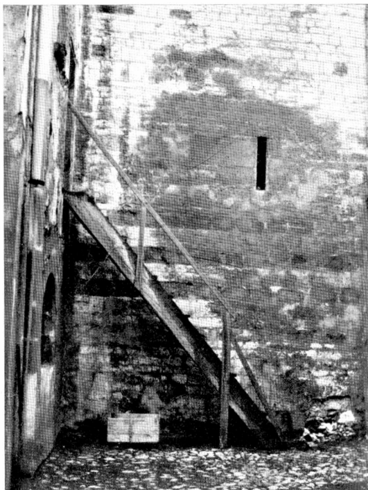
37. Kraków, kościół św. Andrzeja, dolna część wieży północnej; watek ściany stanowią kwadry wapieniaka obrobionego dłutem oraz kilka pasów piaskowca. — 38. Ściana północna transeptu: watek jej stanowią kwadry wapieniaka obrobione młotkiem (okno z epoki baroku).
