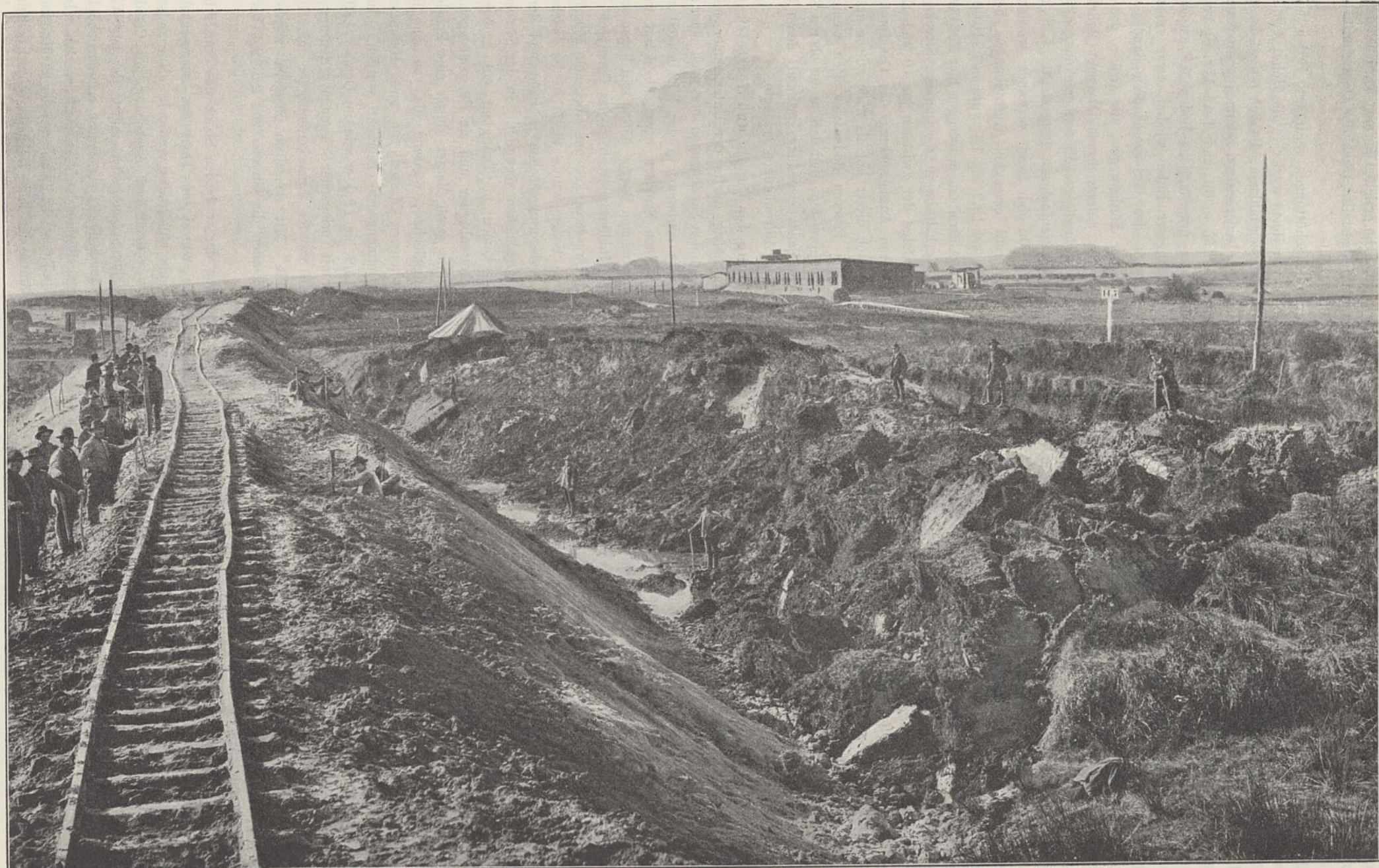
Abb. 8. Mooraufreibung an der Sanddammschüttung bei km 14,7.
