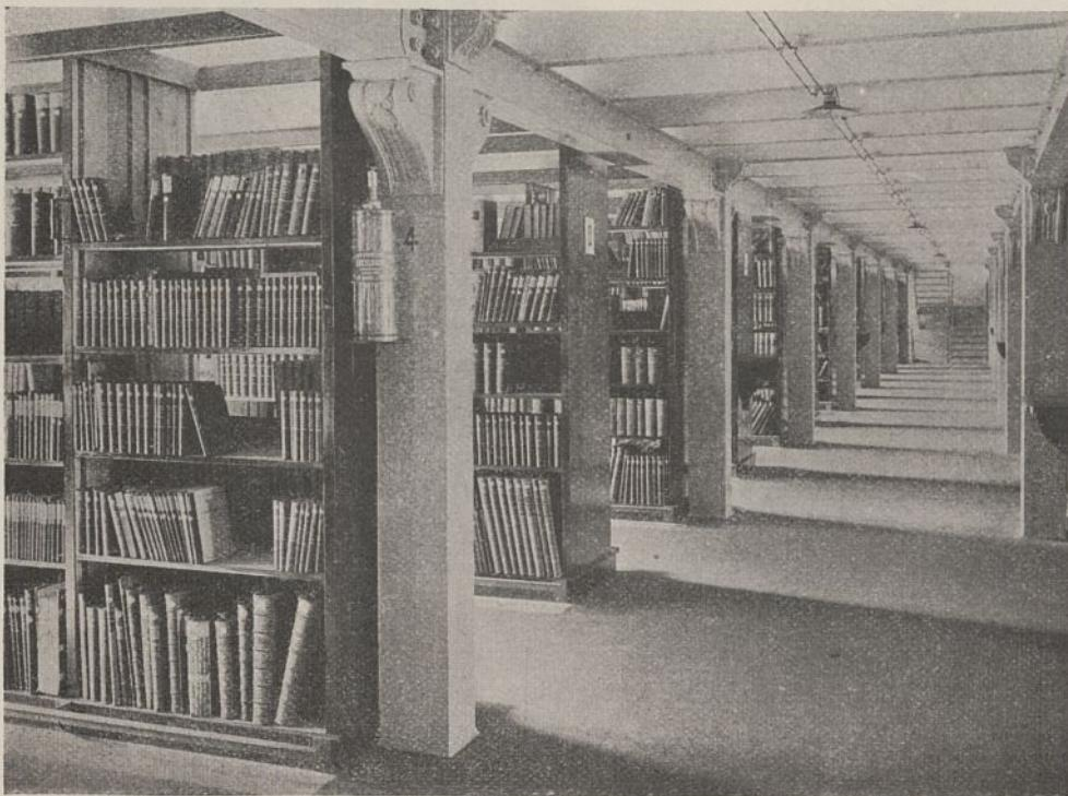
Abb. 13. Deckenbildung und Anordnung der Bücherschäfte in den Speichergeschossen.
