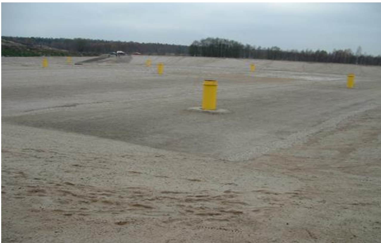
Rys. 33. Kwatera 2 do składowania odpadów z pełnym systemem zabezpieczeń wód gruntowych. [Źródło:MSO]
