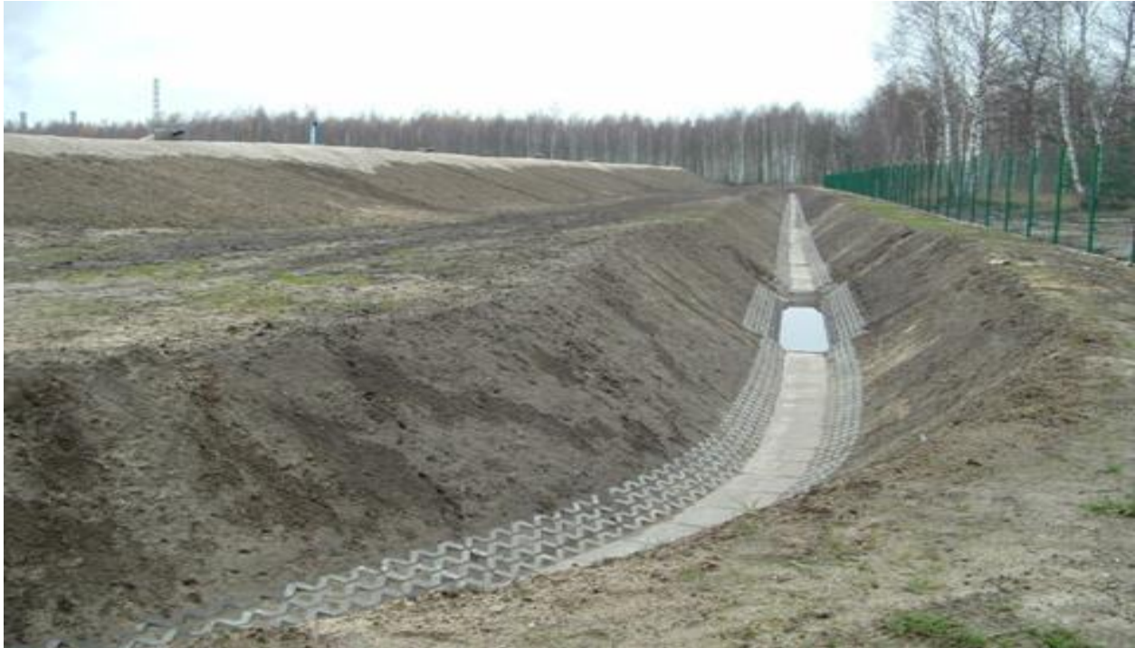
Rys. 32. Sposób wykonania rowu „bez nazwy” odprowadzającego wody powierzchniowe z terenu składowiska przy kwaterze oraz spoza terenu składowiska.
