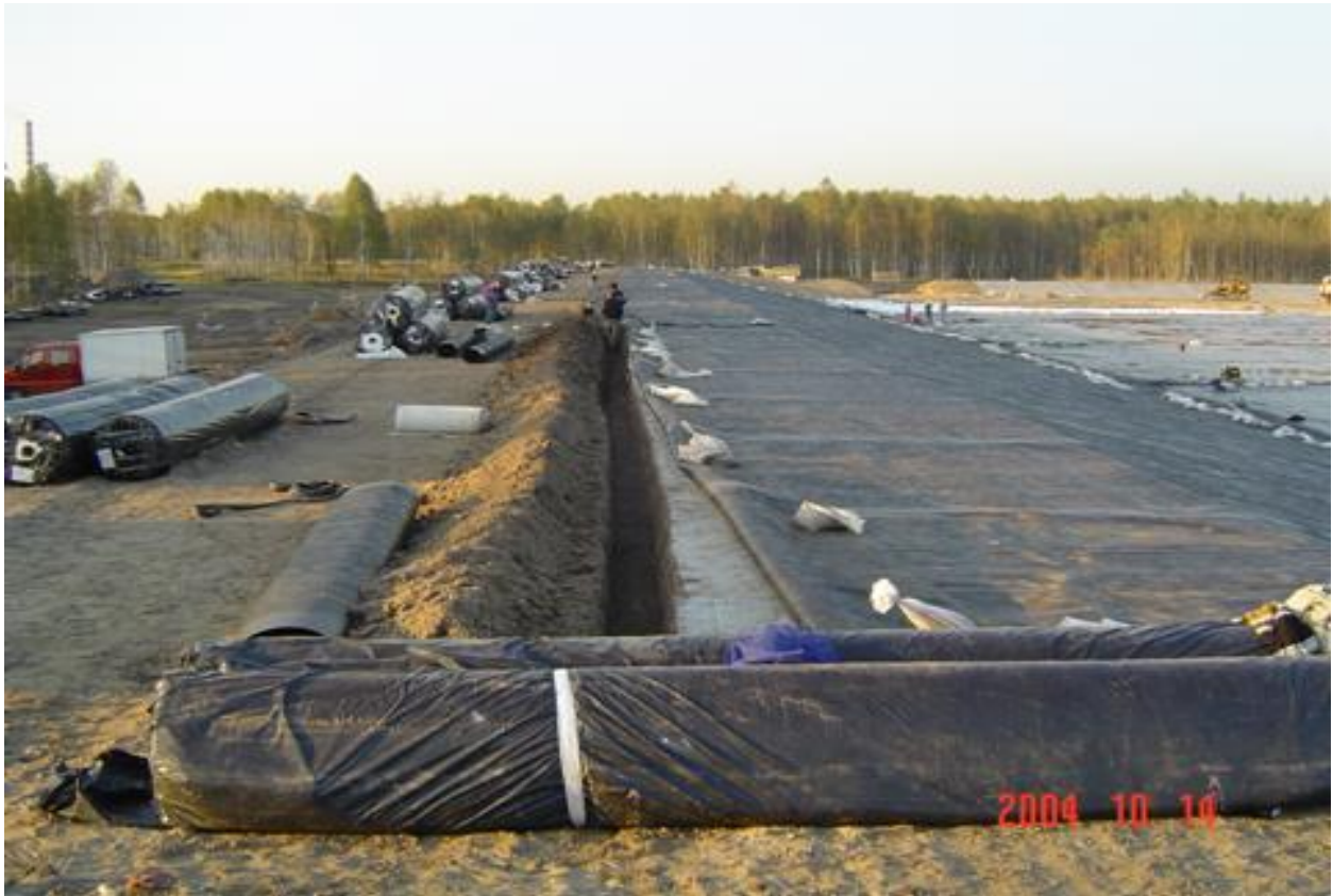
Rys. 31. Zdjęcie z budowy z zakotwienia folii w grobli technologicznej [Źródło: MSO
