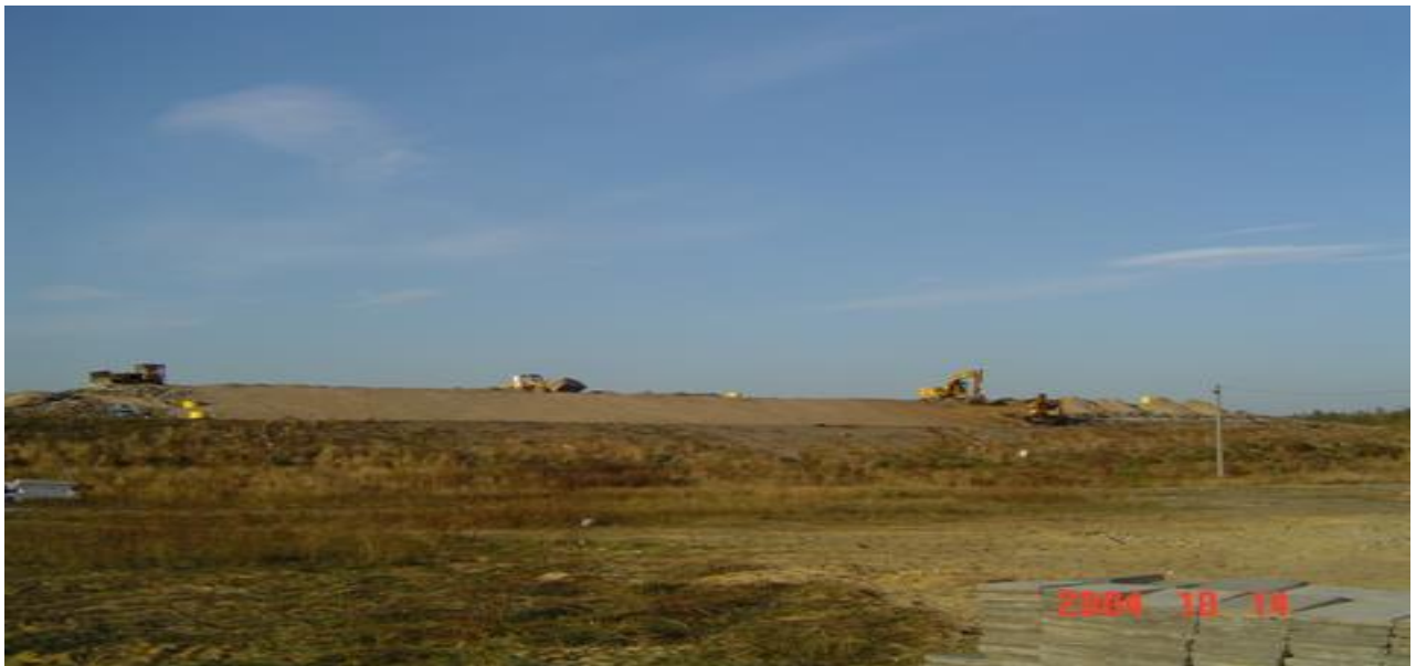
Rys. 26. Południowa skarpa kwatery 1 w trakcie rekultywacji 2004r.[MSO].
